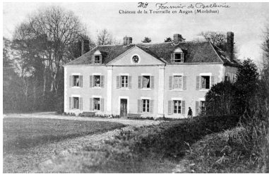
Vue générale Phot. Elise Lauranceau IVR53_20045606242NUCB
