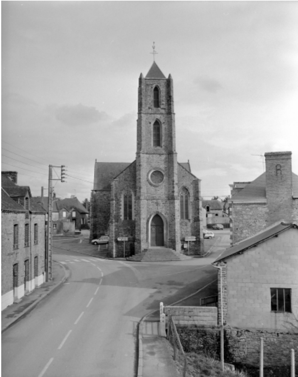
Elévation ouest : vue générale
