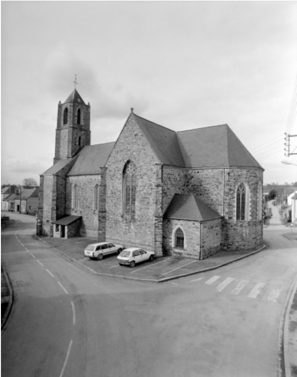
Elévation sud : vue générale
