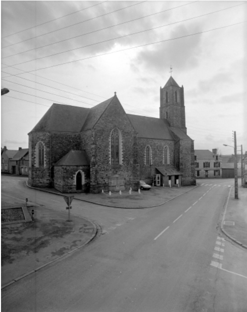
Elévation nord : vue générale
