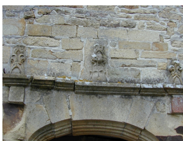
Détail des décors de la porte mortuaire Phot. Anne-Cécile Le Ninivin IVR53_20043518841NUCA
