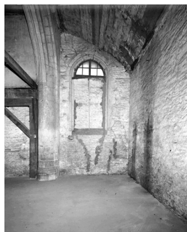
Collatéral nord, mur ouest Phot. Isabelle Barbedor IVR53_19693500073V
