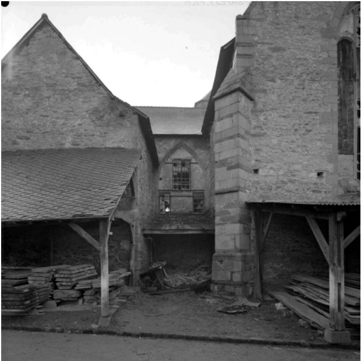
Elévation nord du transept et de la sacristie
