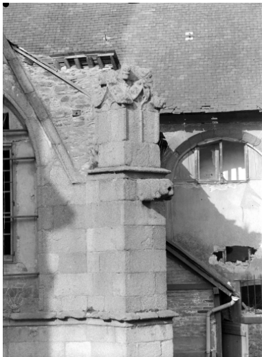
Détail sur un contrefort Phot. Isabelle Barbedor IVR53_19693500094V
