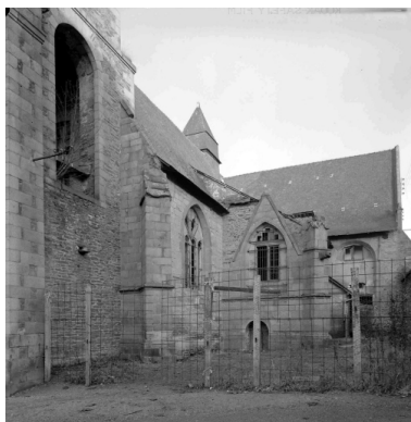
Elévation sud-est Phot. Isabelle Barbedor IVR53_19693500027V
