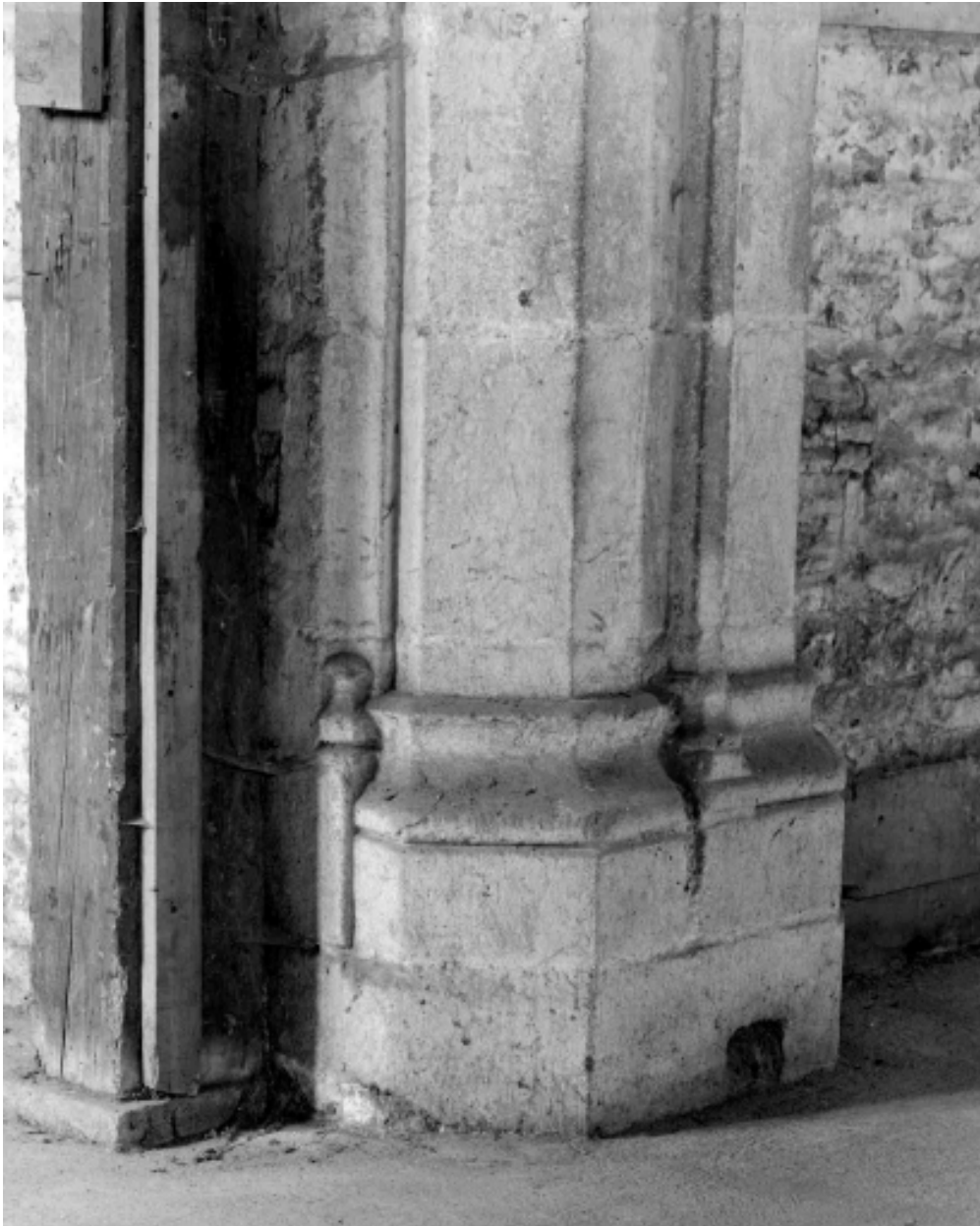
Détail d'une pile du collatéral sud
