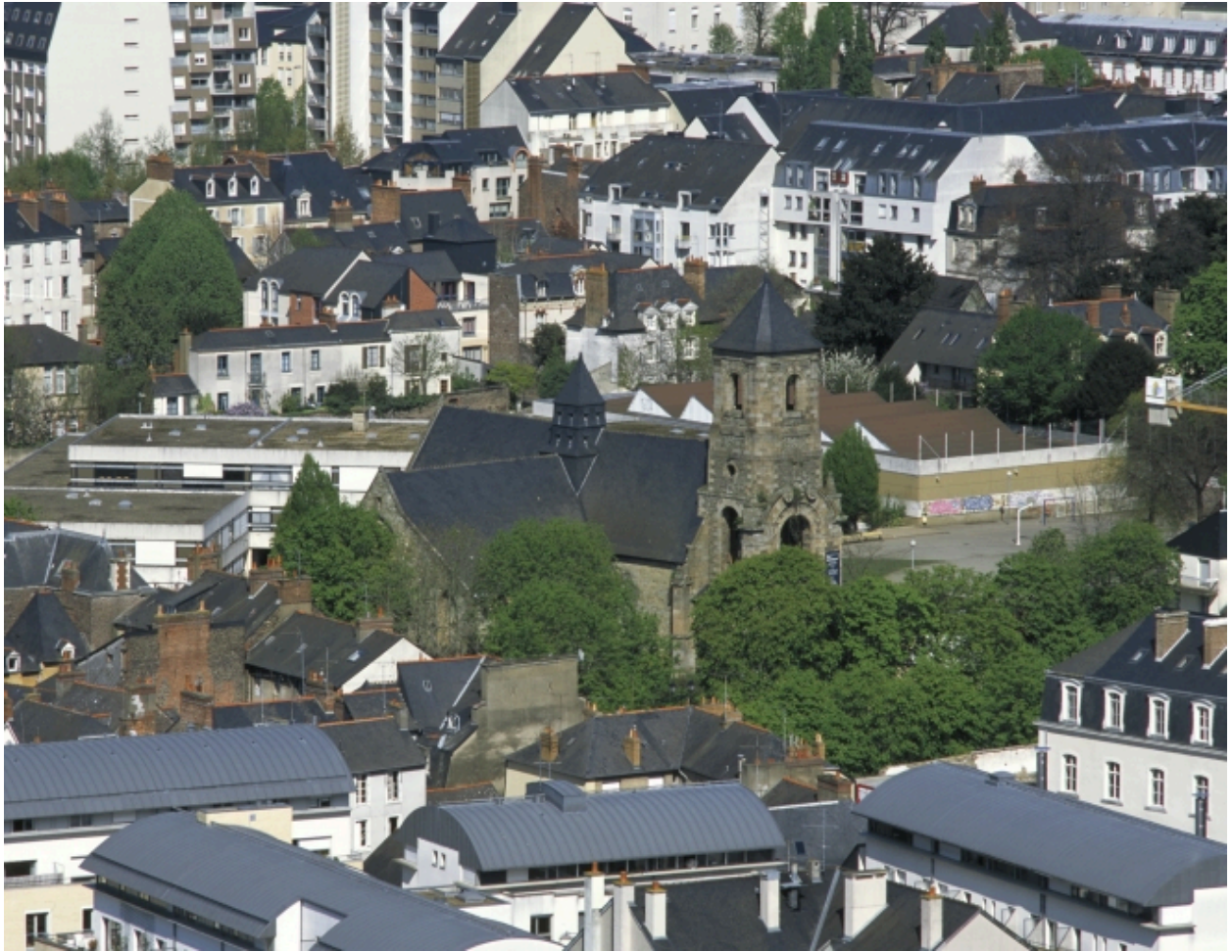
Vue de situation prise du sud-ouest
