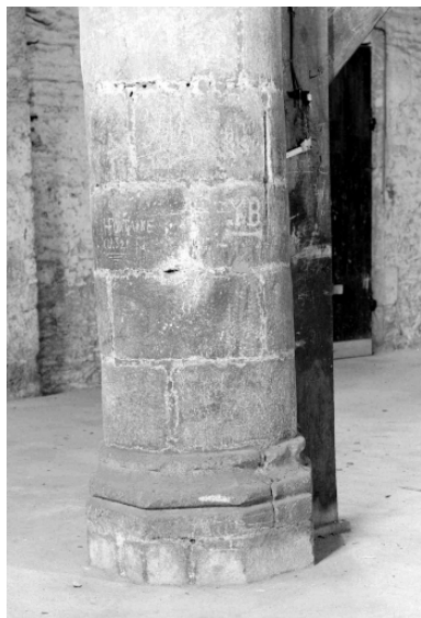
Détail d'une pile de la nef Phot. Isabelle Barbedor IVR53_19693500076V
