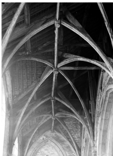
Charpente du collatéral sud Phot. Isabelle Barbedor IVR53_19693500081V
