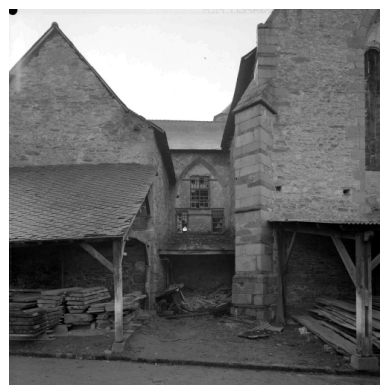
Elévation nord du transept et de la sacristie Phot. Isabelle Barbedor IVR53_19693500033V
