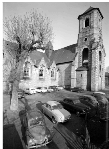
Vue depuis le sud-ouest Phot. Isabelle Barbedor IVR53_19693500028V
