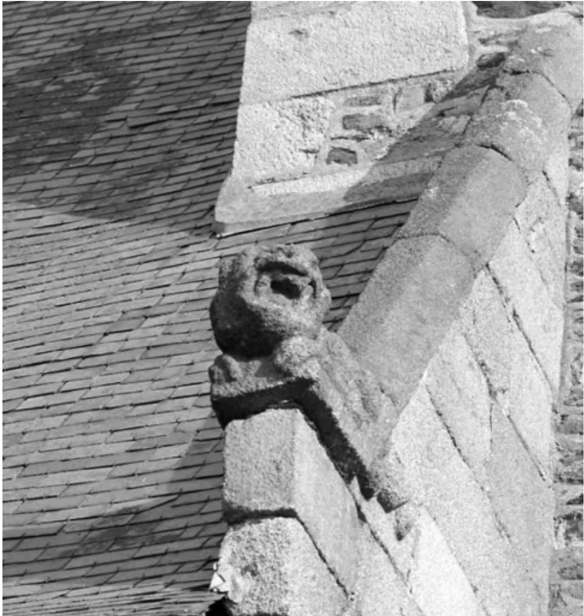
Détail sur une crossette
