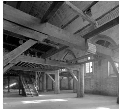
Vue de la nef Phot. Isabelle Barbedor IVR53_19693500064V
