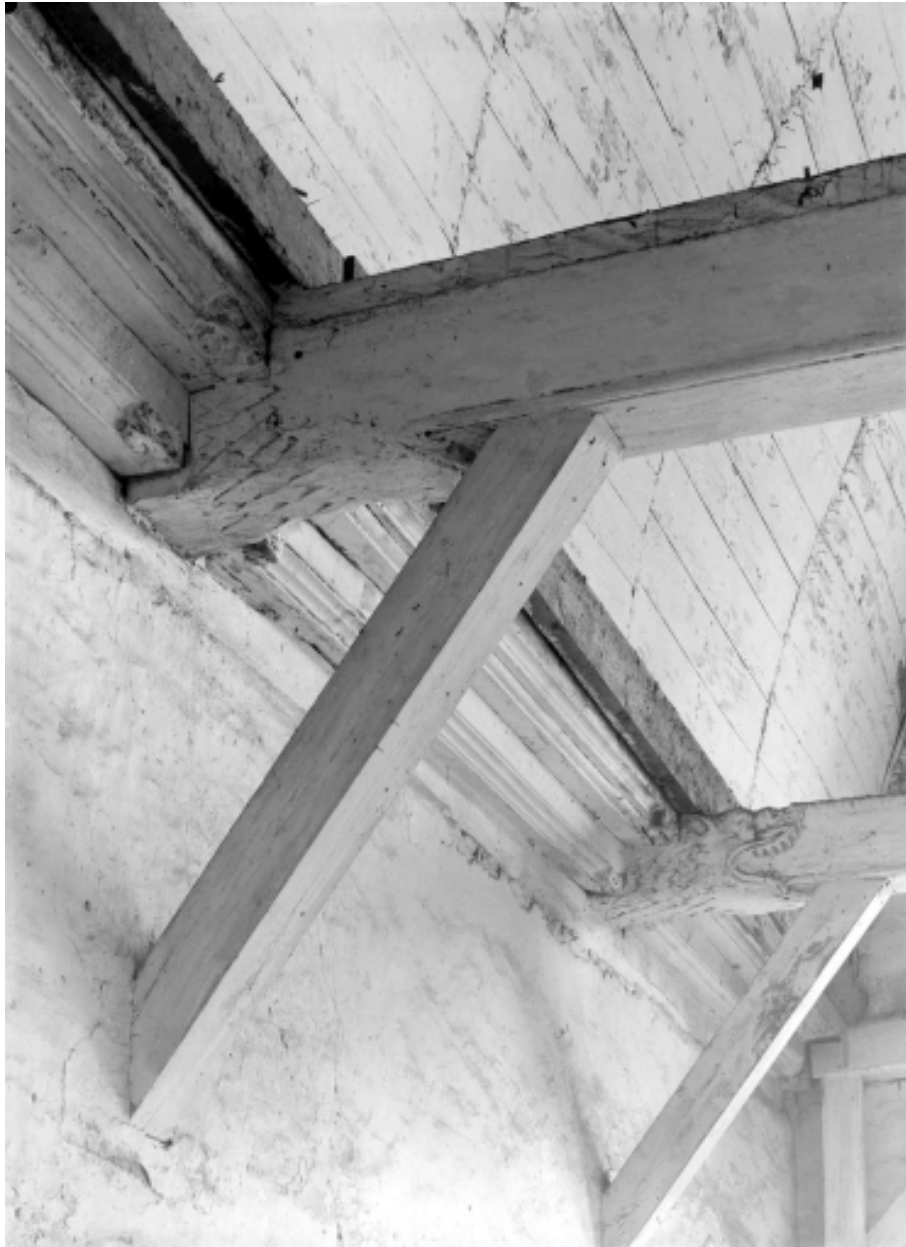
Bras nord du transept : détail des engoulants
