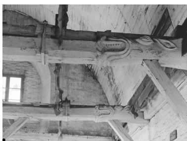
Transept : détail des engoulants Phot. Isabelle Barbedor IVR53_19693500092V
