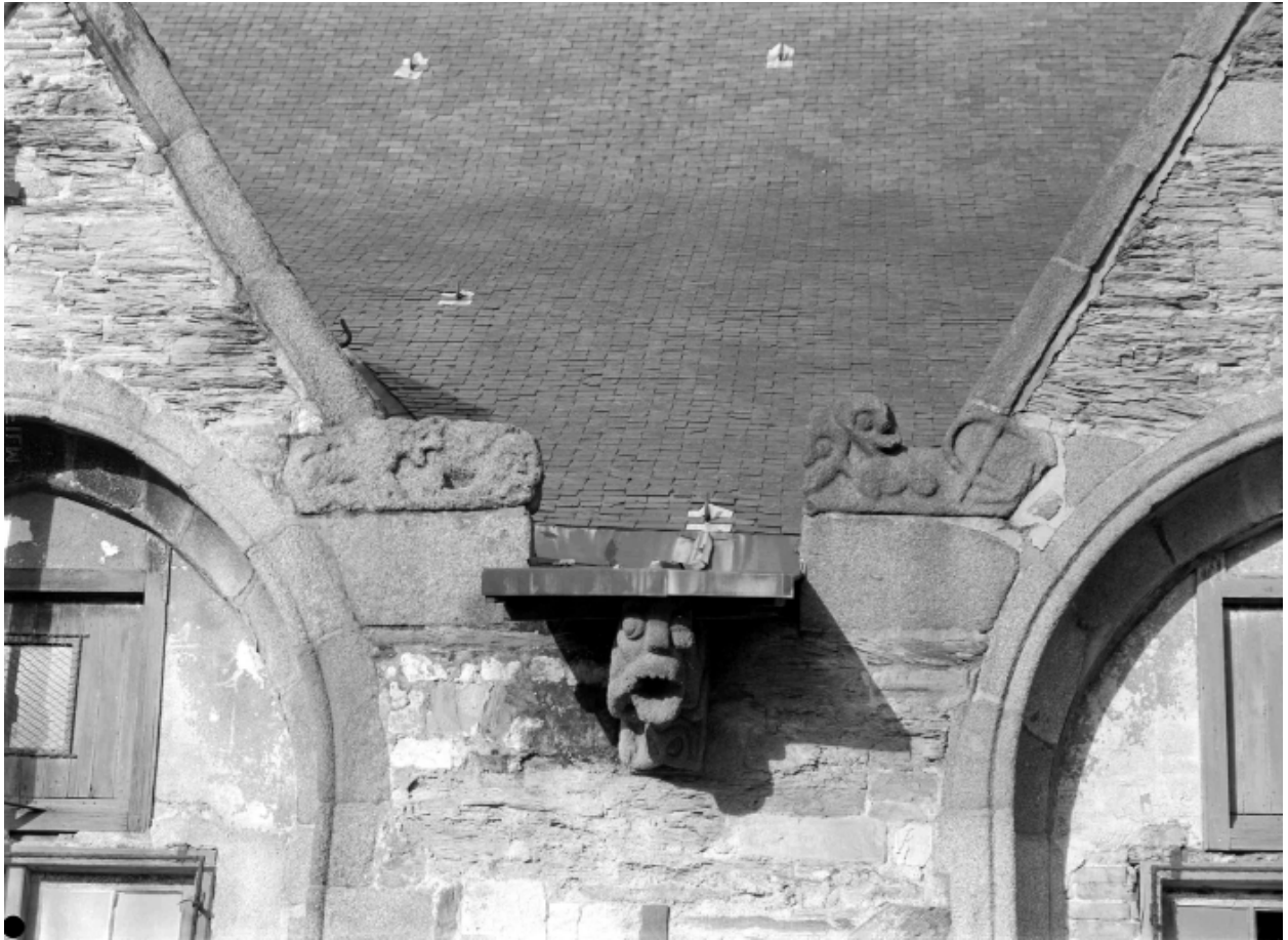
Elévation sud, détail sur une gargouille et une crossette
