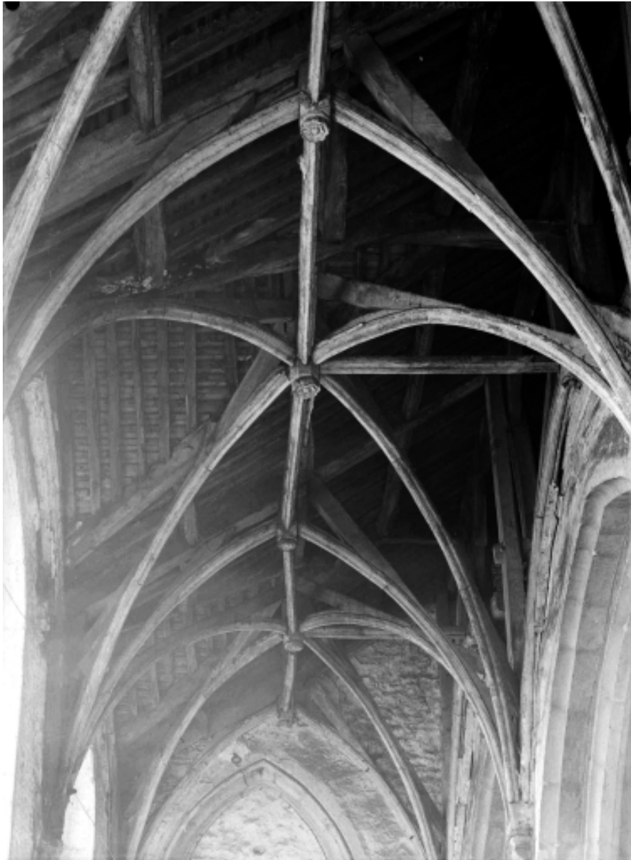
Charpente du collatéral sud
