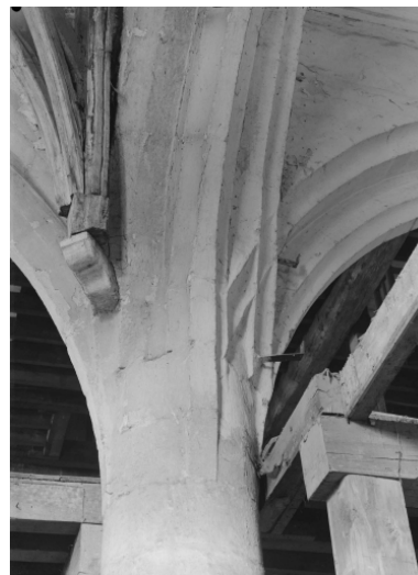
Détail de la pénétration des arcs du transept et du collatéral sud Phot. Isabelle Barbedor IVR53_19693500090V
