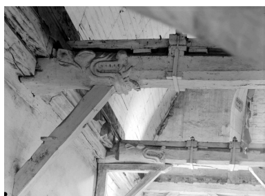
Bras sud du transept : détail des engoulants Phot. Isabelle Barbedor IVR53_19693500082V
