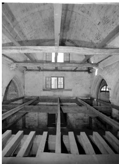
Charpente de la nef Phot. Isabelle Barbedor IVR53_19693500078V
