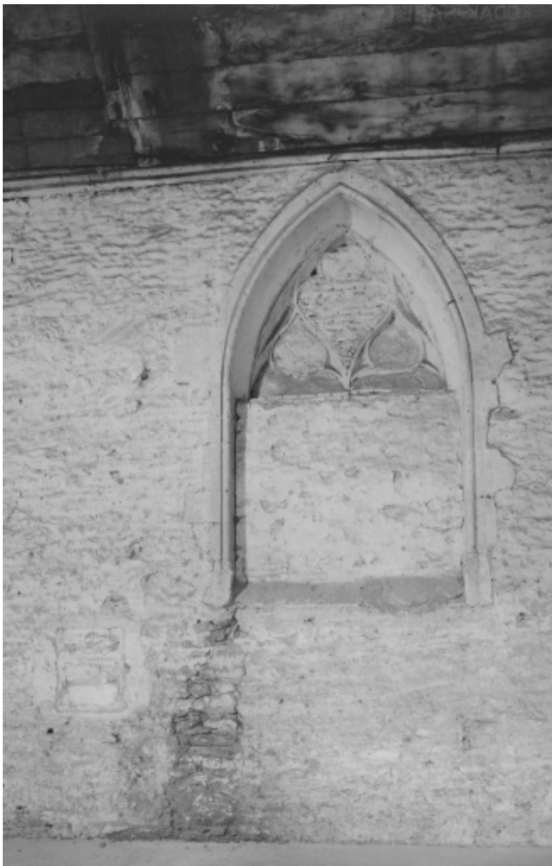
Fenêtre obstruée dans le mur nord du collatéral nord
