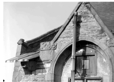
Détail sur l'assise sculptée d'une pierre Phot. Isabelle Barbedor IVR53_19693500037V
