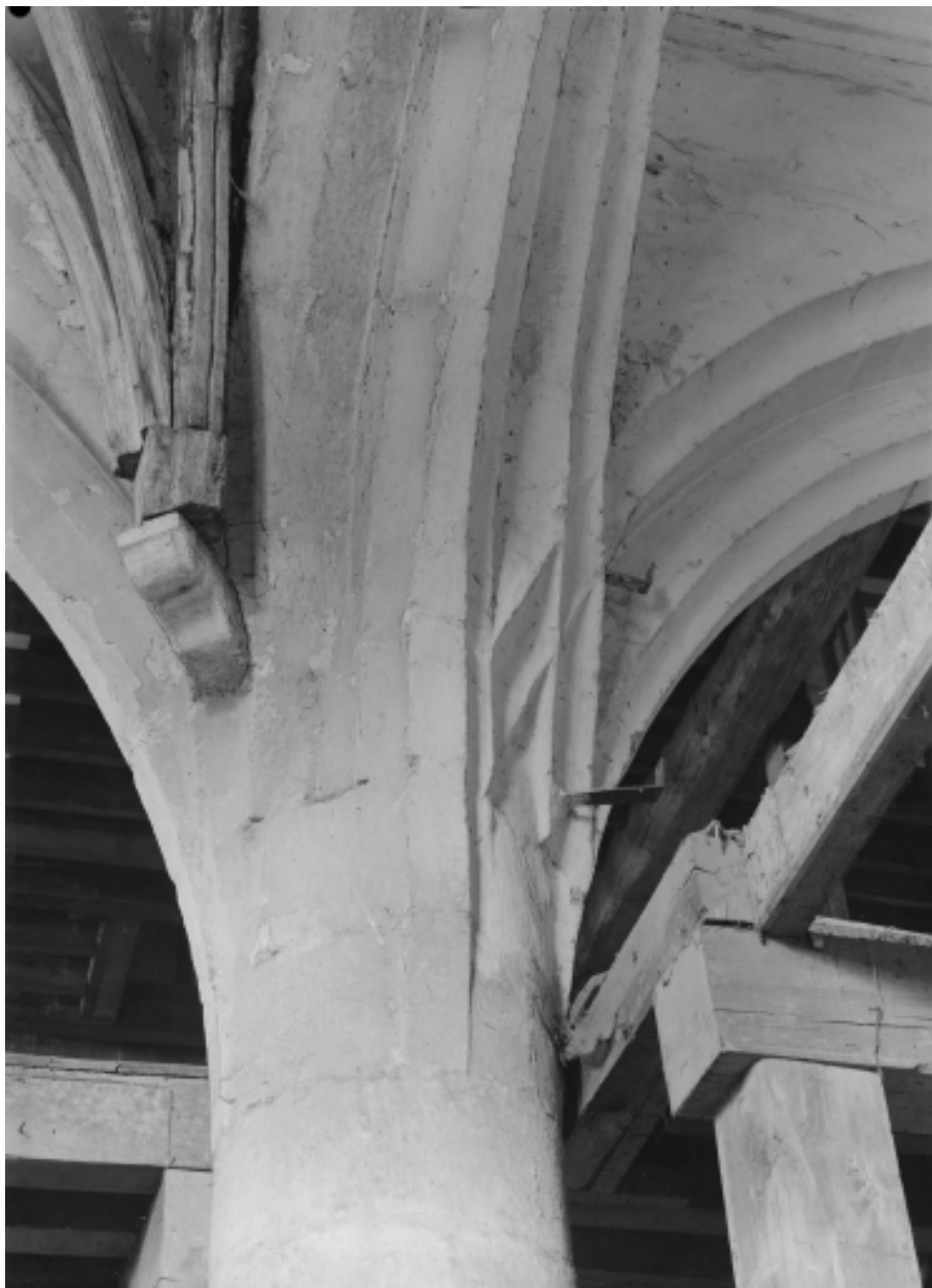
Détail de la pénétration des arcs du transept et du collatéral sud
