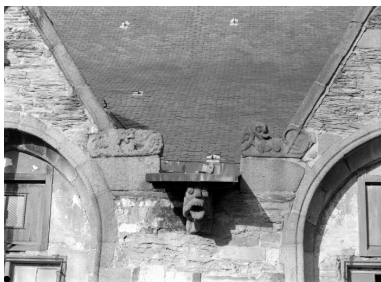
Elévation sud, détail sur une gargouille et une crossette Phot. Isabelle Barbedor IVR53_19693500036V
