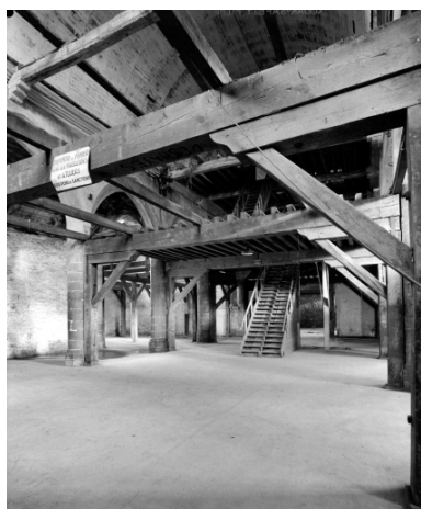
Vue de la nef Phot. Isabelle Barbedor IVR53_19693500063V
