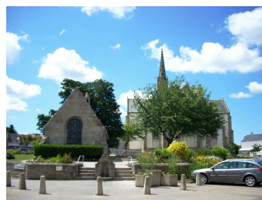
Plouguin, église paroissiale : vue générale est Phot. Gwénaél Fauchille IVR53_20082906147NUCA
