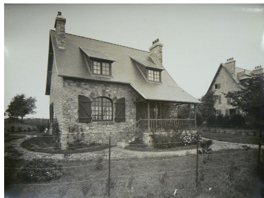
Vue ancienne de la villa Kermor Phot. Archives municipales de Brest IVR53_20072908678NUC
