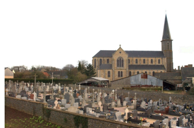
Vue générale nord-ouest Phot. Guy Artur, Phot. Norbert Lambart IVR53_20023502543NUCA
