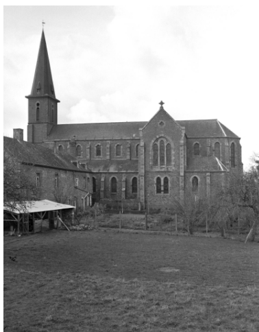
Vue générale sud-est Phot. Guy Artur, Phot. Norbert Lambart IVR53_19943500762X
