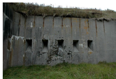
Vue du coffre de contrescarpe de l'angle ouest/saillant IV depuis le fossé sec : il est pourvu d'ouvertures de tir pour fusil. Au-dessus, se trouve une grille défensive Phot. Guillaume Lécueillier IVR53_20062903440NUCA
