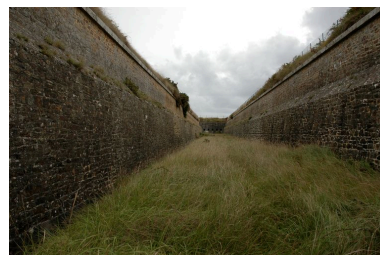
Vue du fossé sec du front sud-est. Au fond (angle est/saillant II), le coffre de contrescarpe pourvu d'ouvertures de tir pour fusil Phot. Guillaume Lécueillier IVR53_20062903445NUCA
