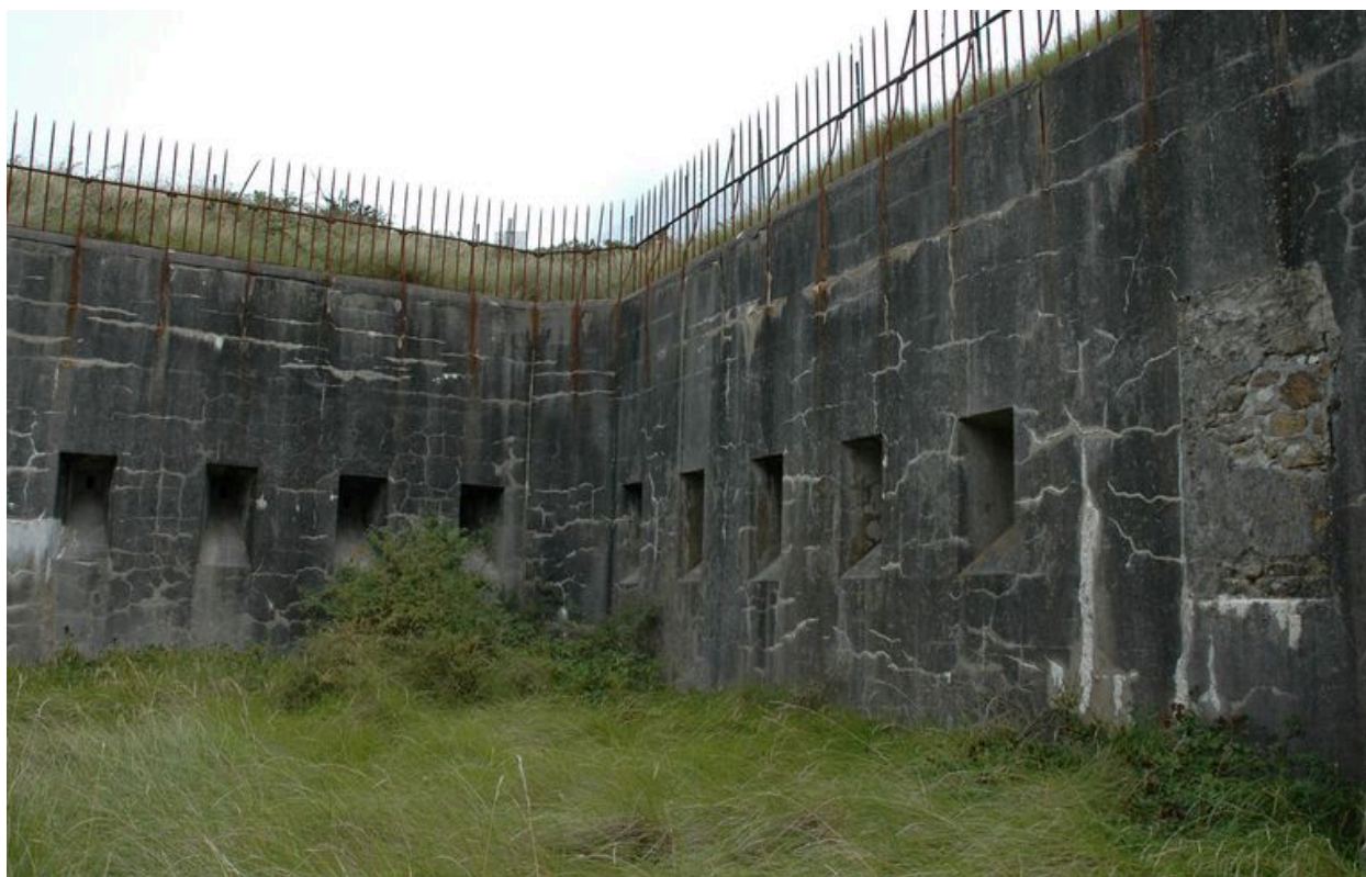
Vue du coffre de contrescarpe de l'angle est/saillant II depuis le fossé sec : il est pourvu d'ouvertures de tir pour fusil. Au-dessus, se trouve une grille défensive
