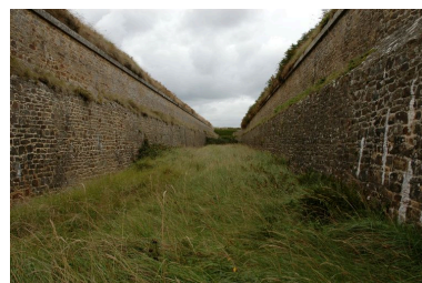
Vue du fossé sec du front sud-est. Au fond (angle est/saillant II), le coffre de contrescarpe pourvu d'ouvertures de tir pour fusil Phot. Guillaume Lécueillier IVR53_20062903442NUCA
