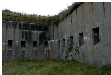
Vue du coffre de contrescarpe de l'angle ouest/saillant IV depuis le fossé sec : il est pourvu d'ouvertures de tir pour fusil. Au-dessus, se trouve une grille défensive Phot. Guillaume Lécueillier IVR53_20062903437NUCA
