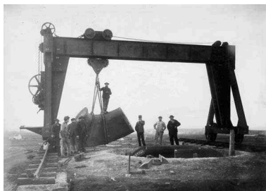
Vue du chantier de construction du réduit, vers 1902-1906 : portique mis en place au-dessus du puits de l'une des deux tourelles pour canons de 75 mm. Il s'agit de la manutention d'une avant-cuirasse (elle est en trois pièces)
