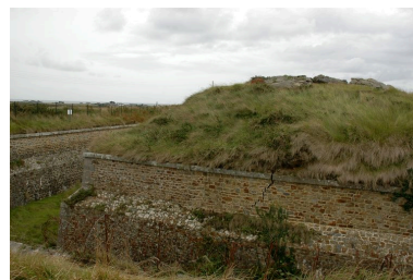
Vue générale de l'angle nord (saillant II) depuis le glacis. Ce saillant comprenant une tourelle de canon de 75 mm et un observatoire blindé a été bouleversé par une explosion dont on observe les effets (amas de béton armé et lézarde de l'escarpe)
