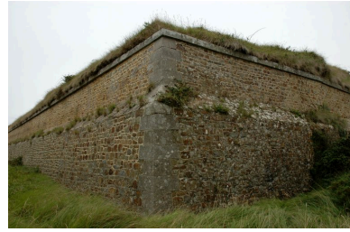
Vue du de l'angle est/saillant II depuis le fossé sec. Ce saillant comprenant une tourelle de canon de 75 mm et un observatoire blindé a été bouleversé par une explosion dont on observe les effets (lézarde de l'escarpe à droite)
