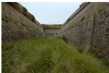
Vue du fossé sec du front sud-est. Au fond (angle est/saillant II), le coffre de contrescarpe pourvu d'ouvertures de tir pour fusil Phot. Guillaume Lécueillier IVR53_20062903444NUCA
