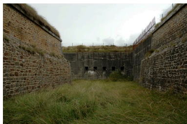
Vue du coffre de contrescarpe de l'angle est/saillant II depuis le fossé sec : il est pourvu d'ouvertures de tir pour fusil. Au-dessus, se trouve une grille défensive Phot. Guillaume Lécueillier
