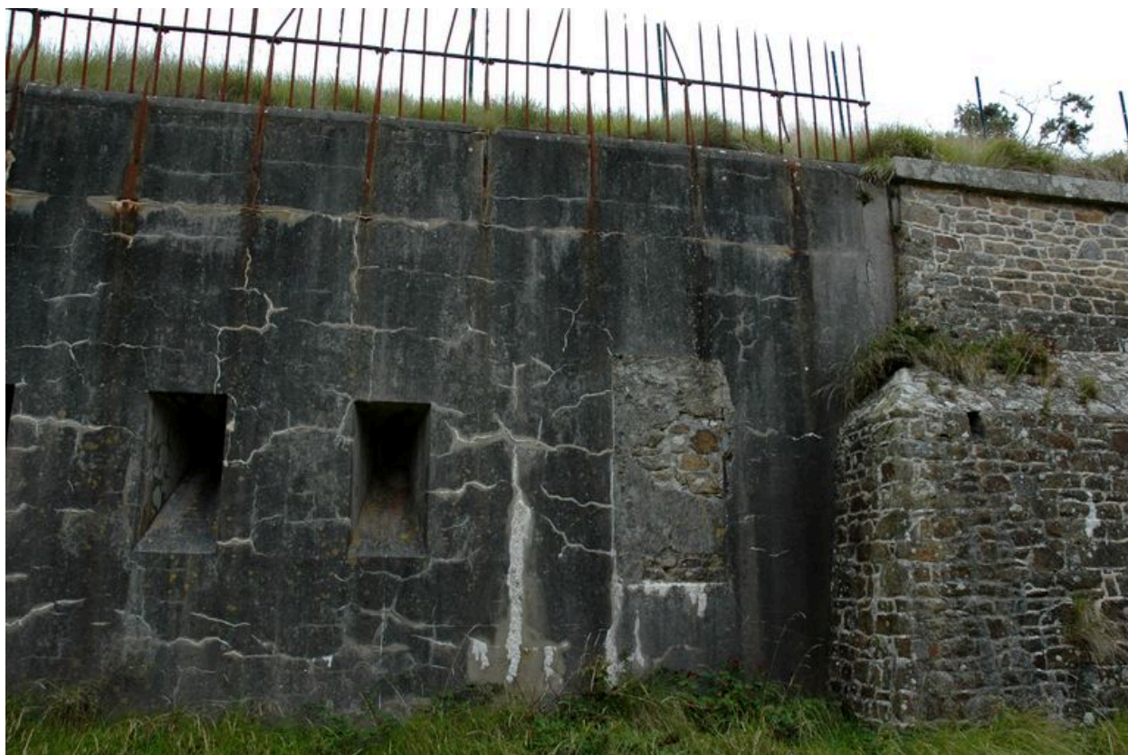
Vue du coffre de contrescarpe de l'angle est/saillant II depuis le fossé sec : il est pourvu d'ouvertures de tir pour fusil. Au-dessus, se trouve une grille défensive
