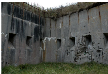
Vue du coffre de contrescarpe de l'angle ouest/saillant IV depuis le fossé sec : il est pourvu d'ouvertures de tir pour fusil. Au-dessus, se trouve une grille défensive Phot. Guillaume Lécueillier IVR53_20062903439NUCA
