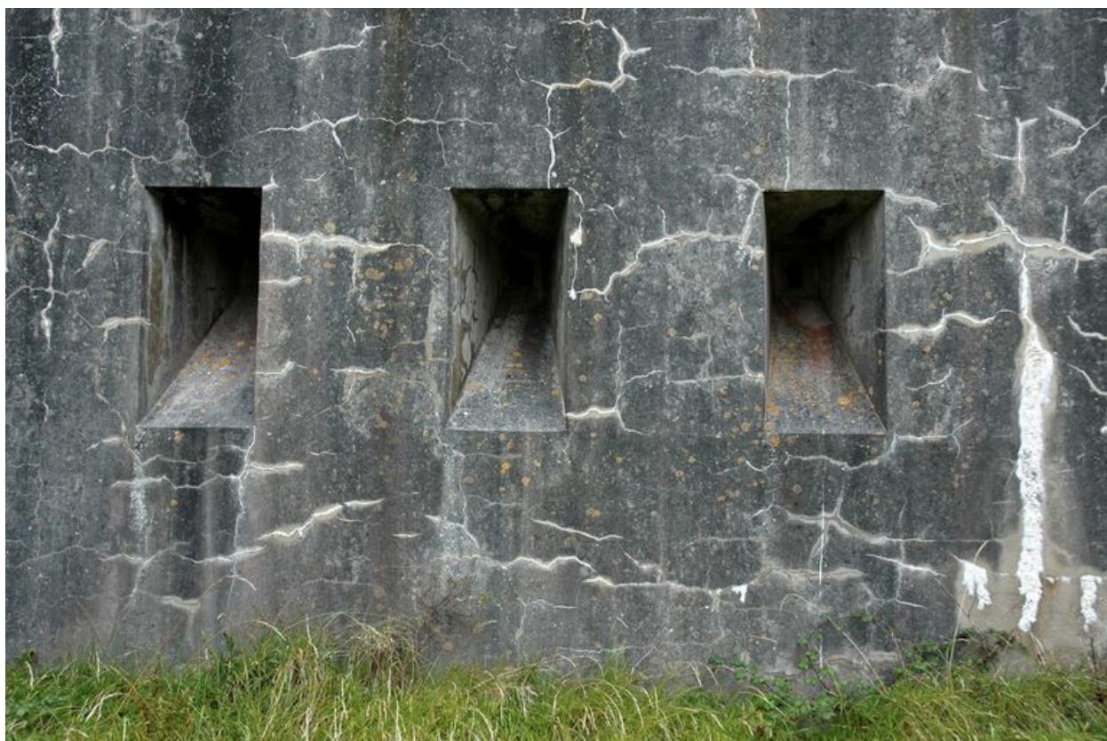
Vue de détail de trois ouvertures de tir pour fusil du coffre de contrescarpe
