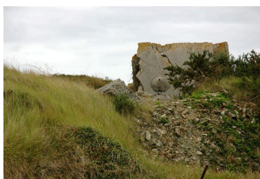
Vue générale de l'angle nord (saillant II) depuis le glacis. Ce saillant comprenant une tourelle de canon de 75 mm et un observatoire blindé a été bouleversée par une explosion dont on observe les effets (amas de béton armé et lézarde de l'escarpe)
