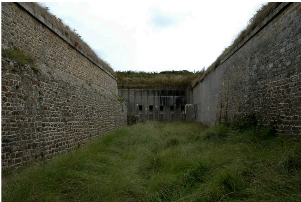
Vue du fossé sec du front nord-ouest : au fond (angle ouest/saillant IV), le coffre de contrescarpe pourvu d'ouvertures de tir pour fusil
