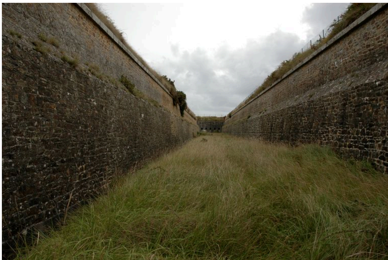
Vue du fossé sec du front sud-est. Au fond (angle est/saillant II), le coffre de contrescarpe pourvu d'ouvertures de tir pour fusil
