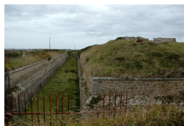
Vue générale de l'angle nord (saillant II) et du fossé du front sud-est depuis le glacis. A droite, on distingue l'observatoire blindé et l'emplacement de la tourelle pour canon de 75 mm. Au premier plan se dresse une grille défensive
