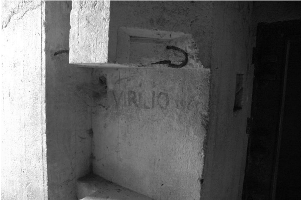
Vue de l'intérieur du poste de direction de tir de la batterie de Longues-sur-Mer : inscription VIRILIO 1960 (une trace de Paul Virilio ?)
