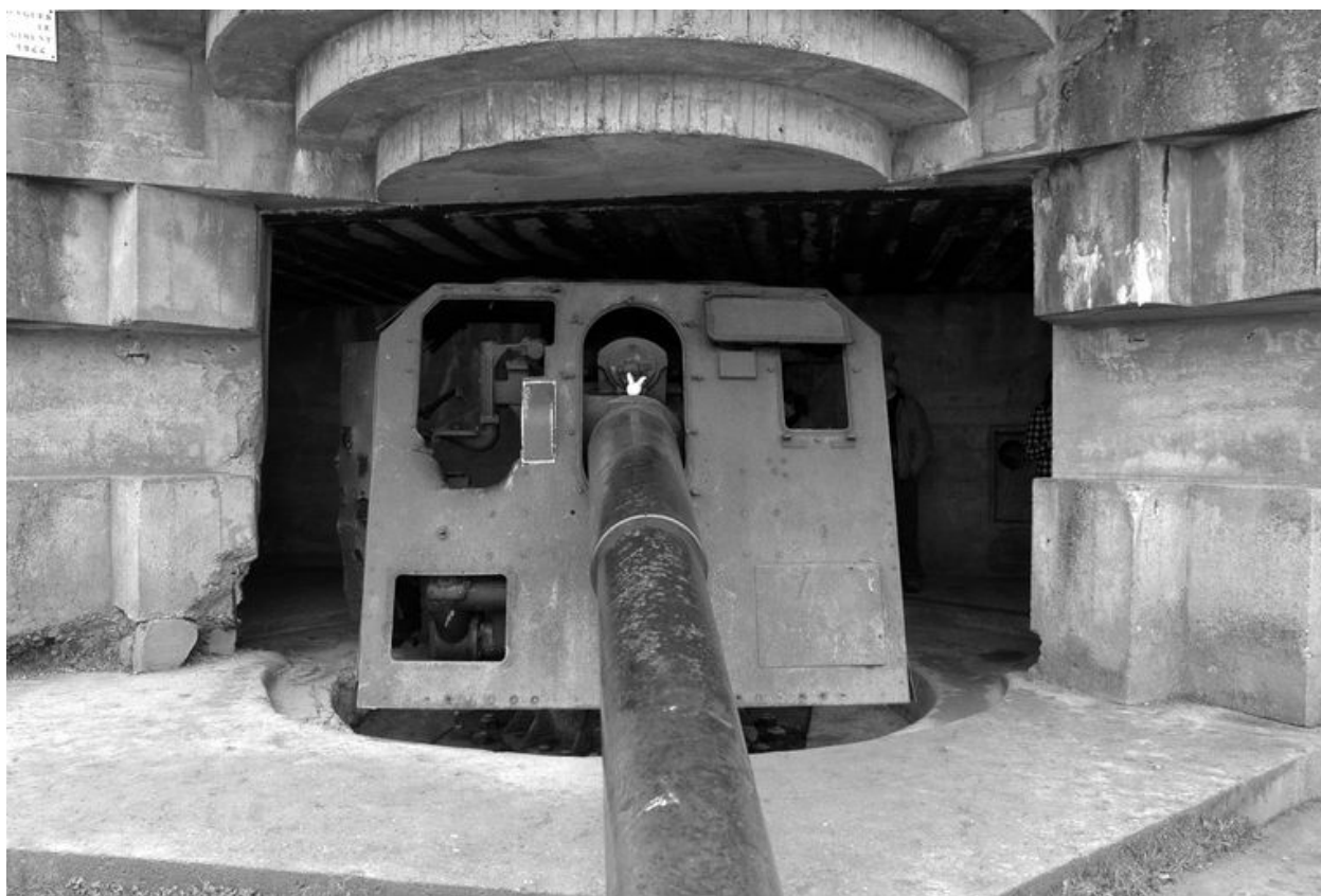
Vue de la tourelle de canon de l'une des quatre casemates de la batterie de Longues-sur-Mer (casemate n° 2 depuis l'est)
