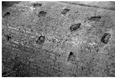
Vue du poste de direction de tir de la batterie de Longues-sur-Mer : détail du traitement du béton Phot. Guillaume Lécueillier IVR53_20051400011NUCA
