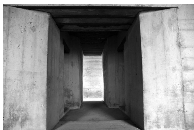
Vue de l'intérieur de l'une des quatre casemates de la batterie de Longues-sur-Mer (casemate n° 4 depuis l'est) Phot. Guillaume Lécueillier IVR53_20051400078NUCA
