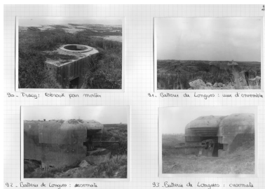
Photographies de la batterie de Longues-sur-Mer (n° 91, 92, 93), rapport Pinczon du Sel, vers 1946-1947, Service Historique de la Marine, Vincennes Phot. Guilio Padovani IVR53_20051400058NUCA
