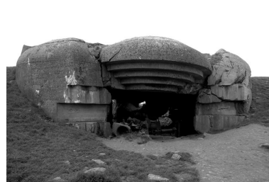
Vue générale de l'une des quatre casemates de la batterie de Longues-sur-Mer (casemate est en partie ruinée) Phot. Guillaume Lécueillier IVR53_20051400111NUCA
