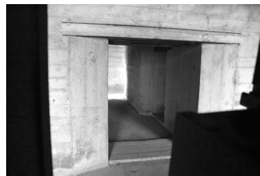
Vue de l'intérieur de l'une des quatre casemates de la batterie de Longues-sur-Mer (casemate n° 4 depuis l'est) Phot. Guillaume Lécueillier IVR53_20051400087NUCA
