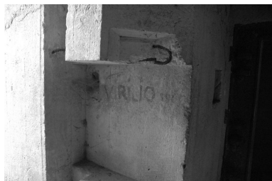
Vue de l'intérieur du poste de direction de tir de la batterie de Longues-sur-Mer : inscription VIRILIO 1960 (une trace de Paul Virilio ?) Phot. Guillaume Lécueillier IVR53_20051400095NUCA
