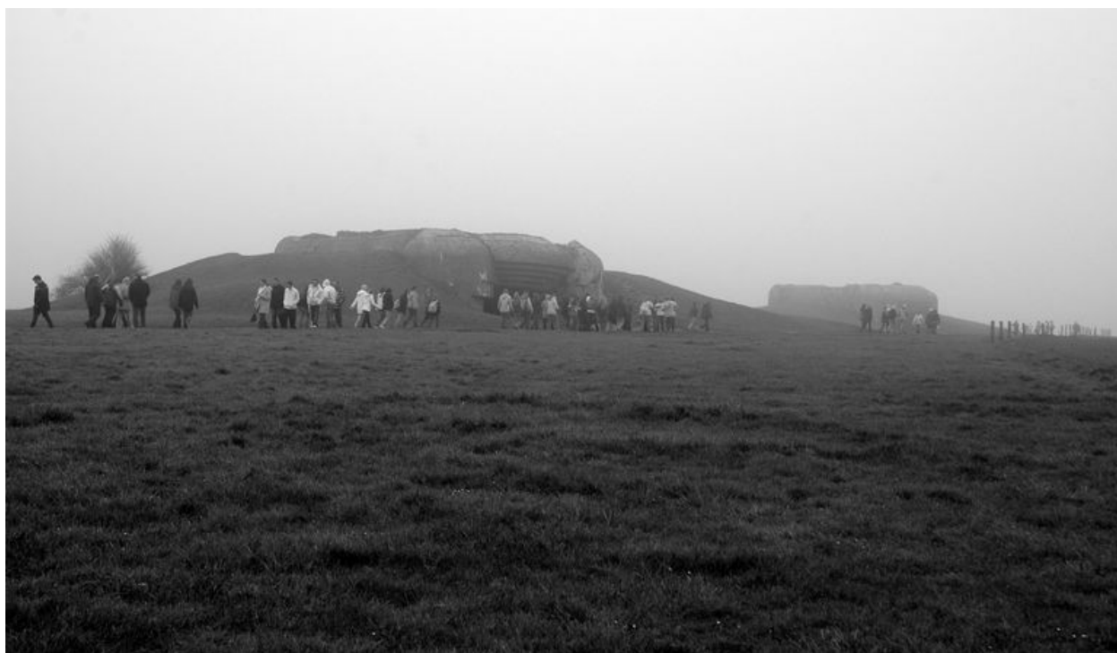
Vue générale de l'une des quatre casemates de la batterie de Longues-sur-Mer
