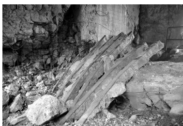
Vue intérieure de l'une des quatre casemates de la batterie de Longues-sur-Mer (casemate est en partie ruinée) Phot. Guillaume Lécueillier IVR53_20051400112NUCA
