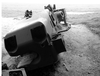
Vue du canon de l'une des quatre casemates de la batterie de Longues-sur-Mer (casemate est en partie ruinée) Phot. Guillaume Lécueillier IVR53_20051400113NUCA
