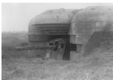
Casemate de la batterie de Longues- sur-Mer (n° 93), rapport Pinczon du Sel, vers 1946-1947, Service Historique de la Marine, Vincennes Phot. Guilio Padovani IVR53 20051400071NUCA
