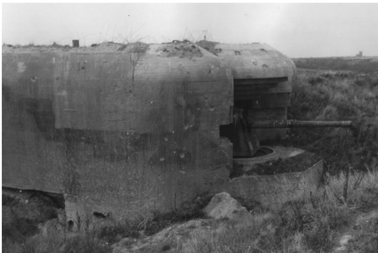
Casemate de la batterie de Longues-sur-Mer (n° 92), rapport Pinczon du Sel, vers 1946-1947, Service Historique de la Marine, Vincennes
