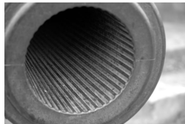
Vue du tube rayé du canon de l'une des quatre casemates de la batterie de Longues-sur- Mer (casemate n° 2 depuis l'est) Phot. Guillaume Lécueillier IVR53_20051400080NUCA
