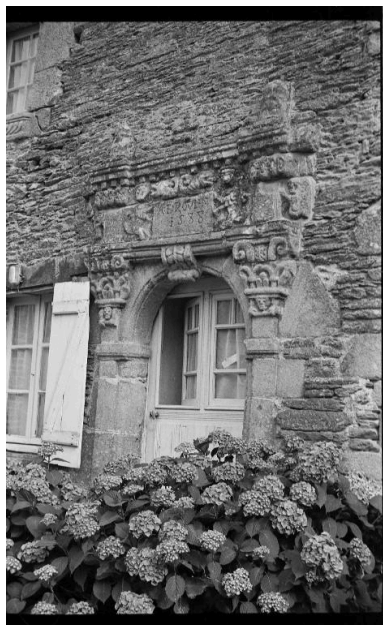
Maison : porte d'entrée (état en 1985) Phot. Auteur inconnu IVR53_19745606754Z
