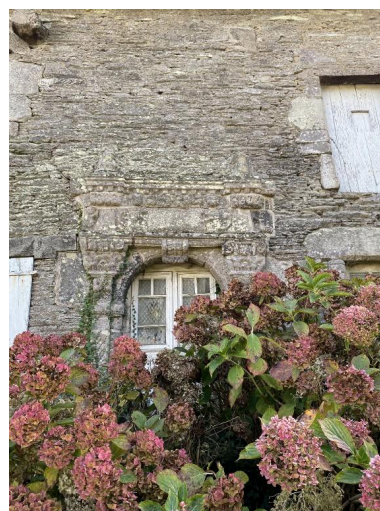
Porte, élévation sud, détail Phot. Baptiste Oligo IVR53_20265610939NUCA
