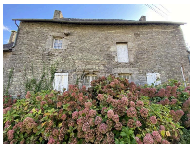
Élévation sud, vue générale Phot. Baptiste Oligo IVR53_20265610940NUCA
