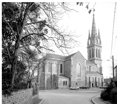
Elévation Nord : vue générale Phot. A. Boden IVR53_19933500666X
