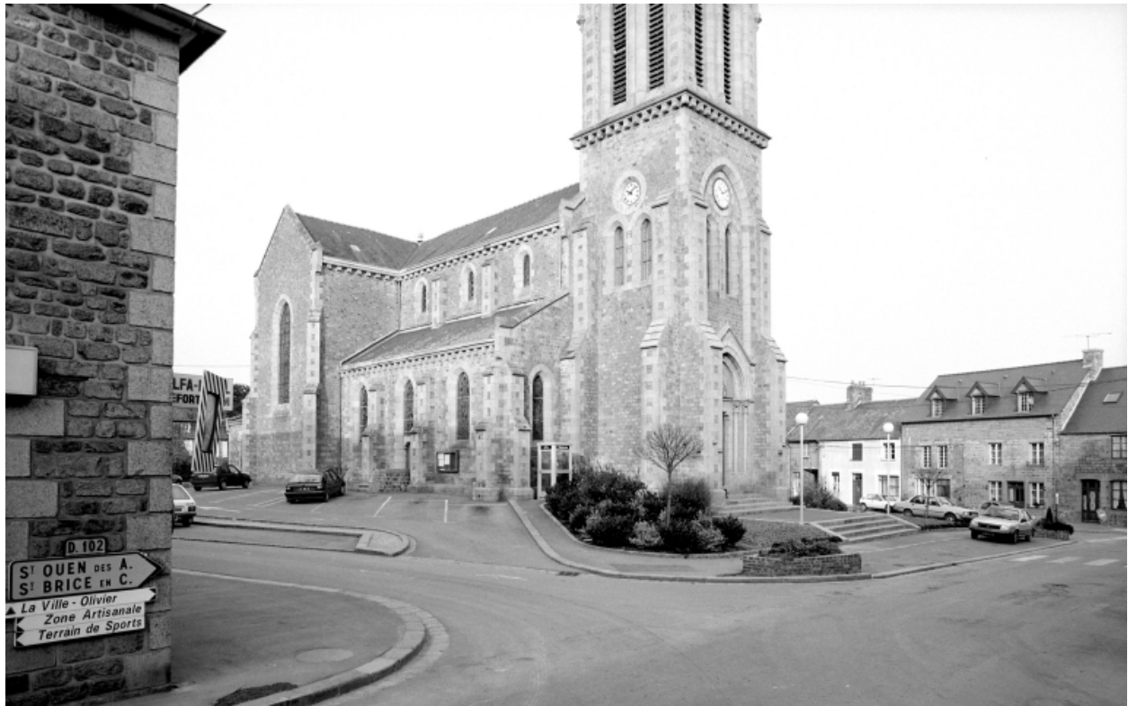
Elévation Nord-Ouest : vue générale
