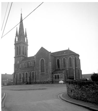
Elévation Sud : vue générale Phot. A. Boden IVR53_19933500664X
