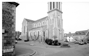
Elévation Nord-Ouest : vue générale Phot. A. Boden IVR53_19933500665X
