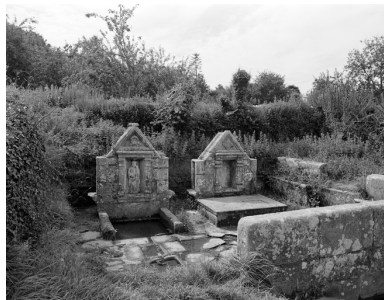
Vue générale Phot. Guy Artur IVR53_19742200300X
