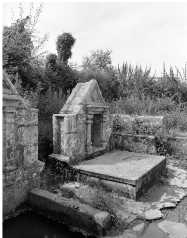
Vue oblique Phot. Guy Artur IVR53_19742200301X
