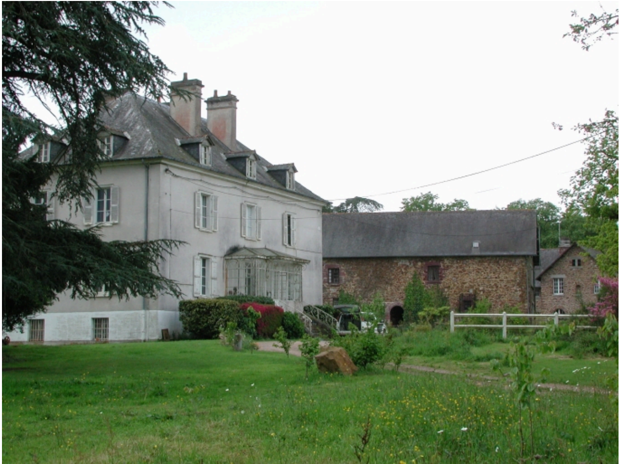
Vue générale nord-est
