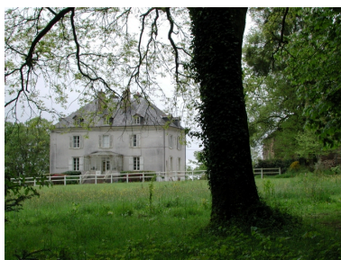
Château ; vue de situation nord Phot. Claude Quillivic IVR53_20023509052NUCA
