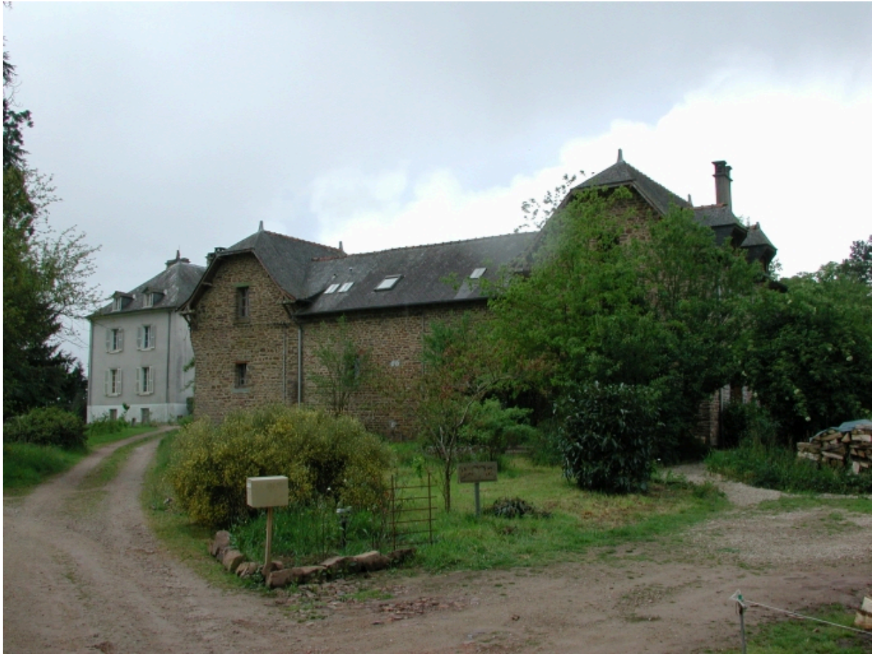
Vue de situation nord-est
