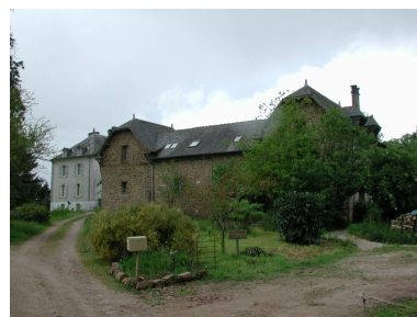
Vue de situation nord-est Phot. Claude Quillivic IVR53_20023509049NUCA
