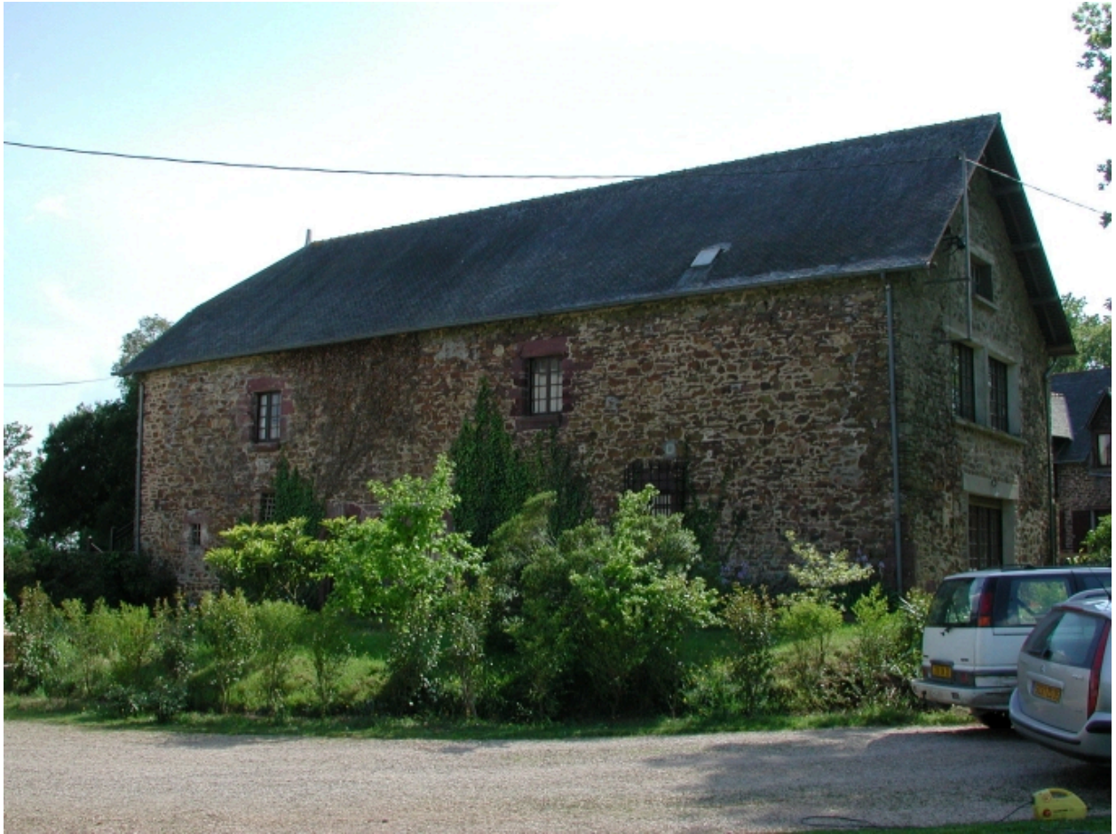
Vestige du manoir ; vue générale nord-est
