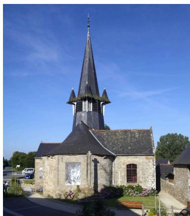
Elévation est : vue générale Phot. Norbert Lambart IVR53_20123501140NUCA
