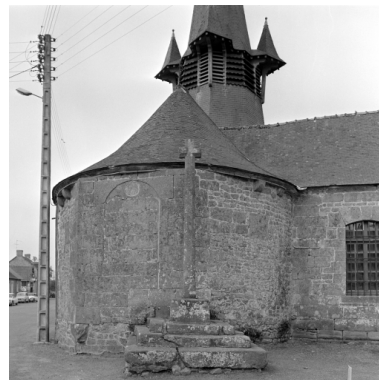
Elévation est : vue générale Phot. Guy Artur, Phot. Norbert Lambart IVR53_19773500159X
