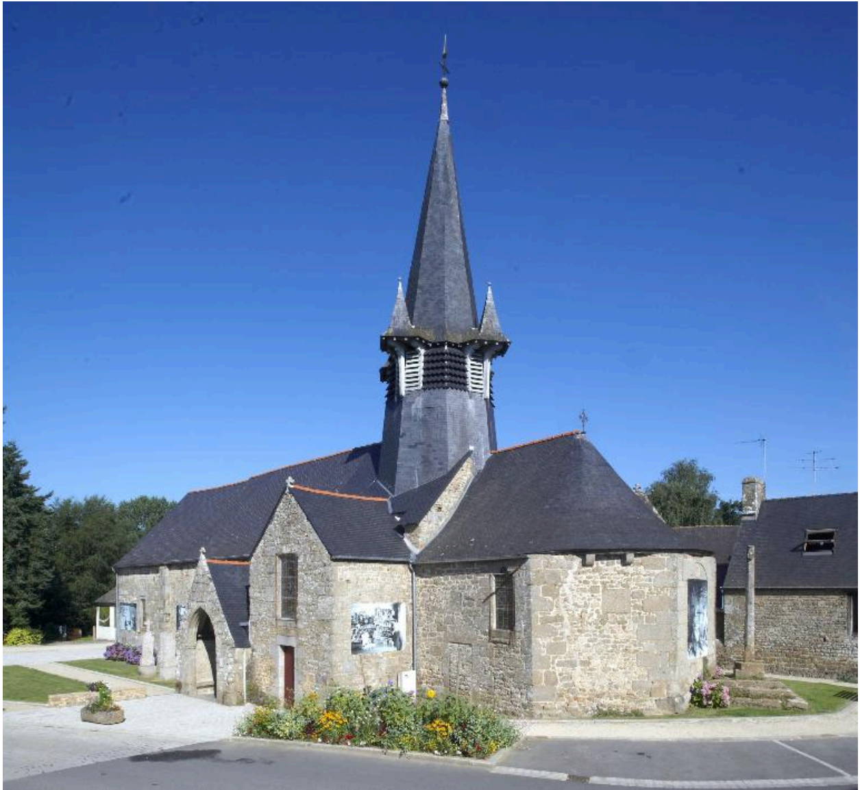
Elévation sud : vue générale
