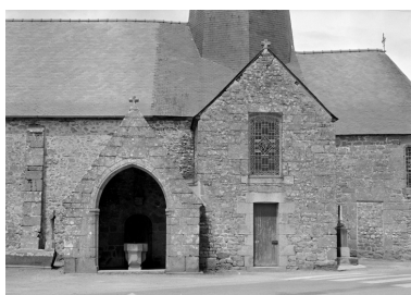
Elévation sud, partie centrale, porte sud : vue générale Phot. Guy Artur, Phot. Norbert Lambart IVR53_19943501278X
