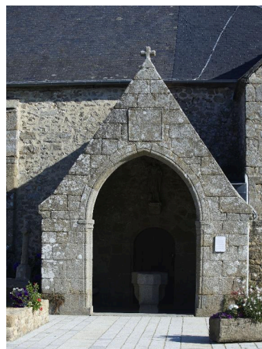
Entrée latérale sud Phot. Norbert Lambart IVR53_20123501179NUCA
