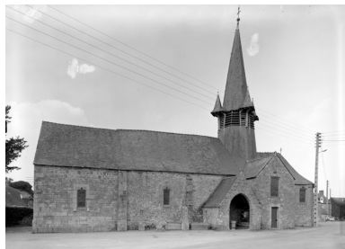
Elévation sud : vue générale Phot. Guy Artur, Phot. Norbert Lambart IVR53_19773500416V
