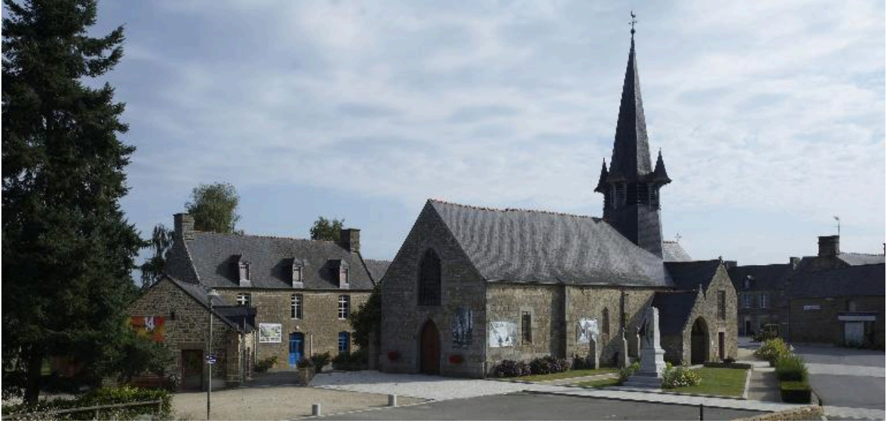
Vue sud-ouest de l'église
