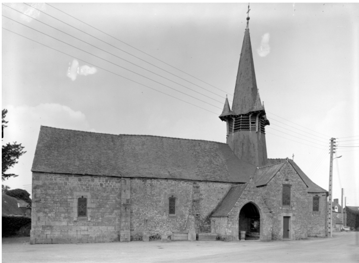
Elévation sud : vue générale
