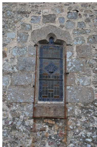
Fenêtre de la nef à arc trilobé Phot. Maëleonn Lestrat, Phot. Marion Morin, Phot. Priskilla Sechet, Phot. Emilie Tubaud IVR53_20123505968NUCA
