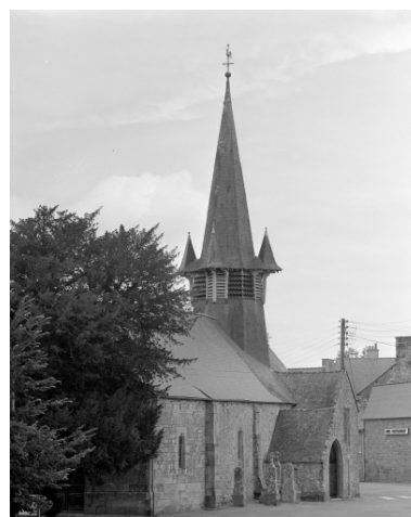
Elévation sud-ouest : vue générale Phot. Guy Artur, Phot. Norbert Lambart IVR53_19943501280X
