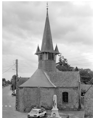
Elévation est : vue générale Phot. Guy Artur, Phot. Norbert Lambart IVR53_19943501279X
