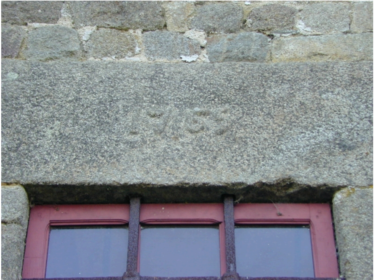
Longère nord, linteau de la baie du choeur gravé d'une date : détail
