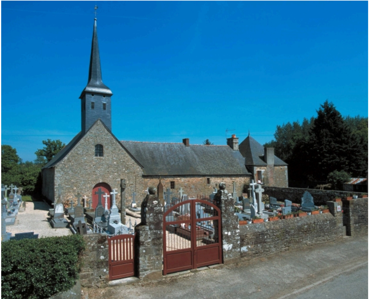
Vue générale nord-ouest
