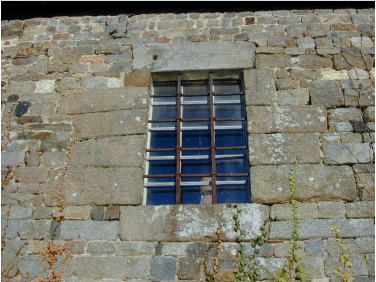
Longère sud, baie du choeur : vue générale
