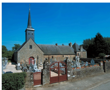
Vue générale nord-ouest Phot. Guy Artur, Phot. Norbert Lambart IVR53_20013524205XA
