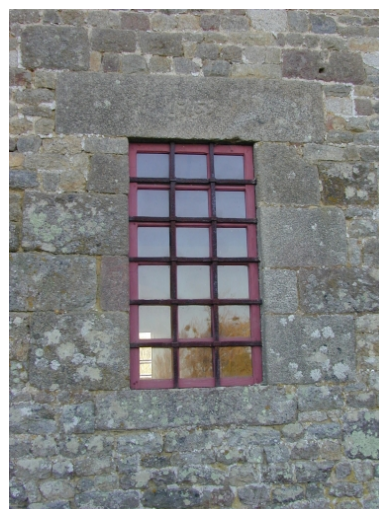
Longère nord : baie du chœur : vue générale Phot. Xavier Gilbert IVR53_20013516958NUCA
