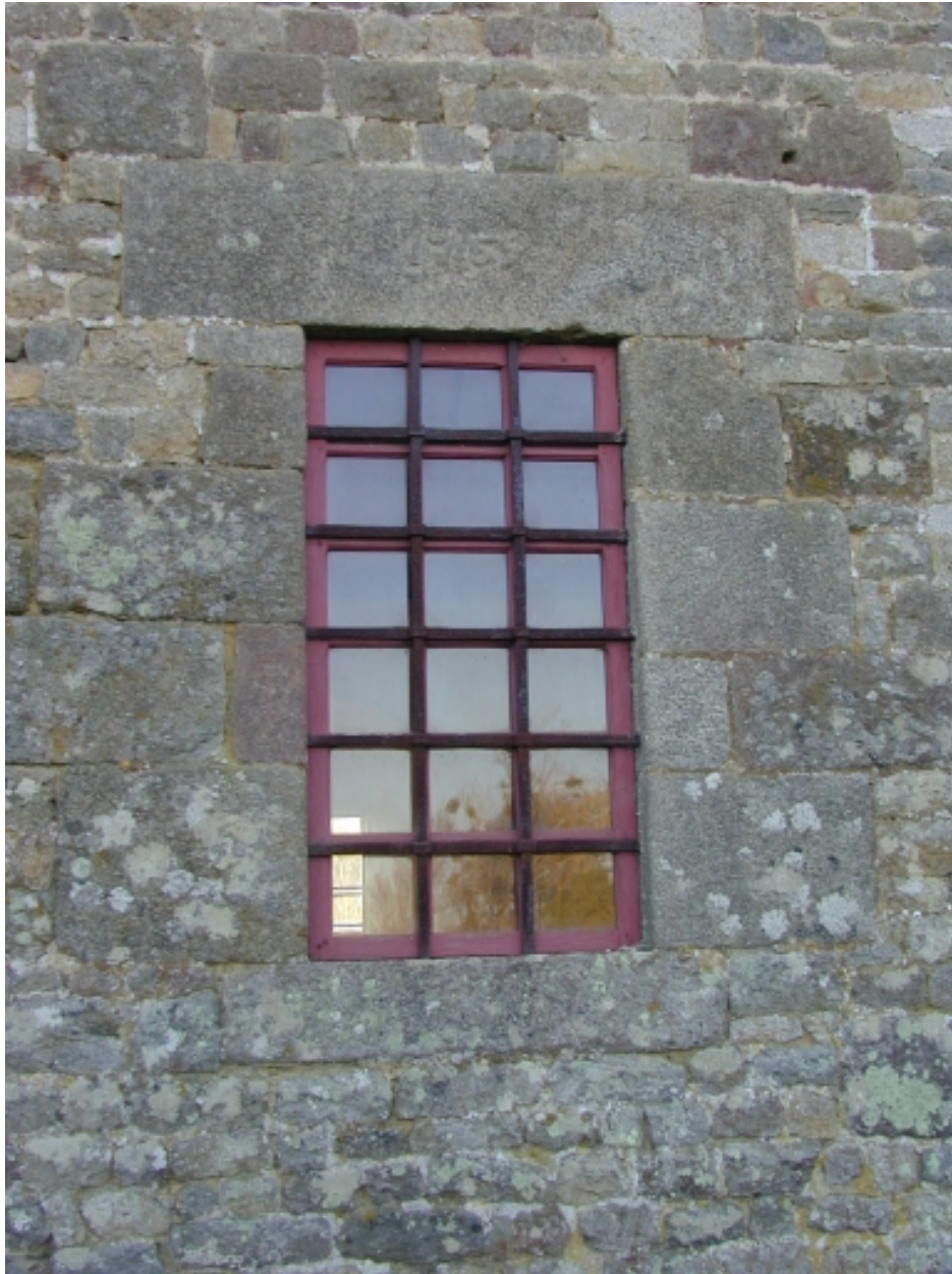
Longère nord : baie du choeur : vue générale
