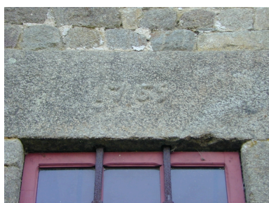
Longère nord, linteau de la baie du chœur gravé d'une date : détail Phot. Xavier Gilbert IVR53_20013516959NUCA
