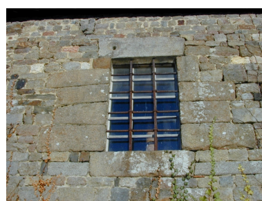
Longère sud, baie du choeur : vue générale Phot. Xavier Gilbert IVR53_20013516957NUCA
