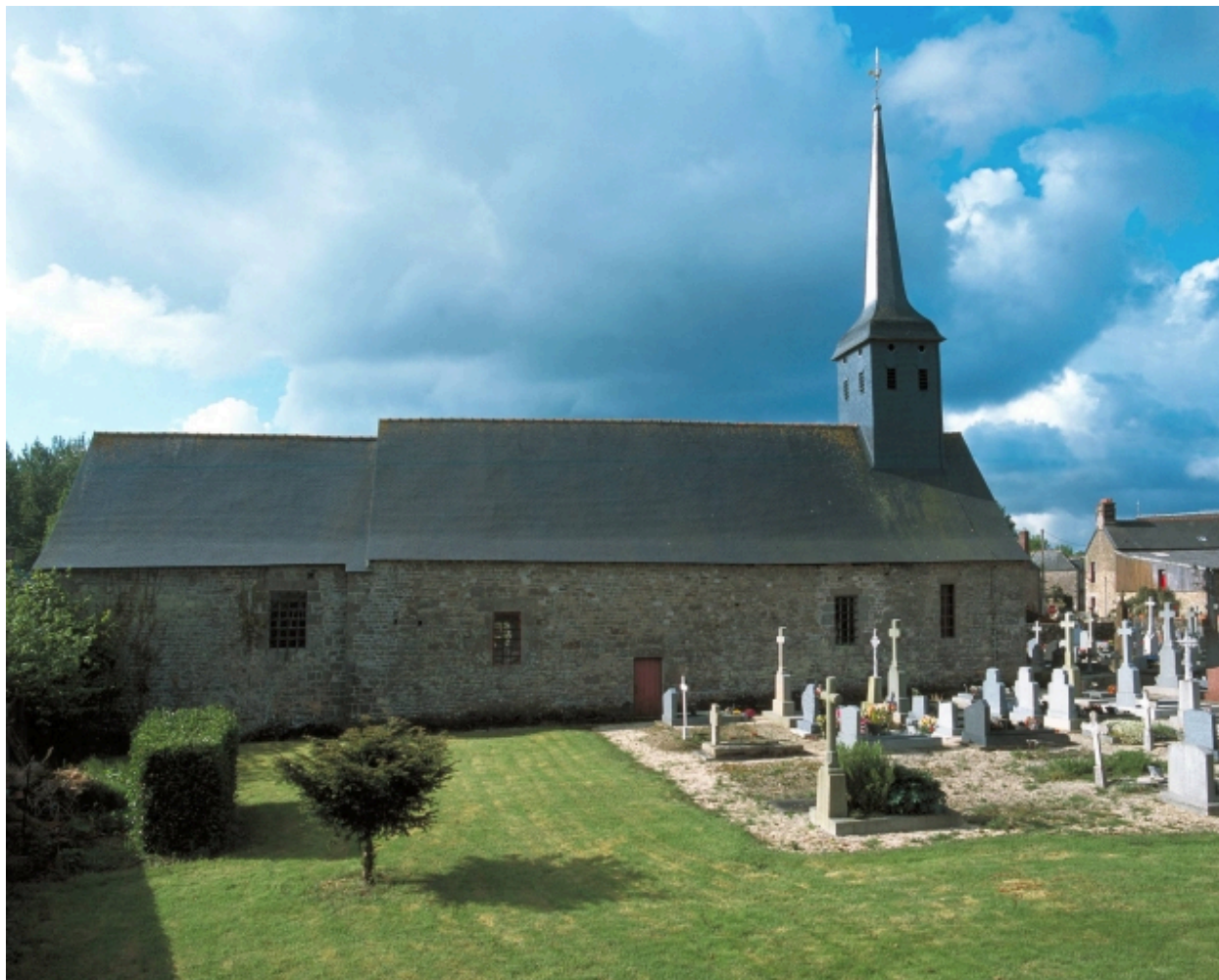
Vue générale nord
