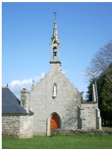
Chapelle de Plas-Caër et Notre-Dame : élévation ouest Phot. Gwénaél Fauchille IVR53_20082905518NUCA
