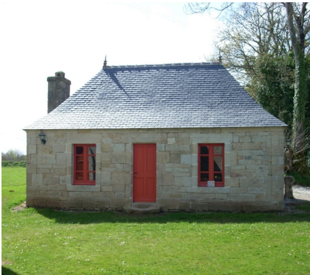
Chapelle de Plas-Caër et Notre-Dame : sacristie : vue générale est
