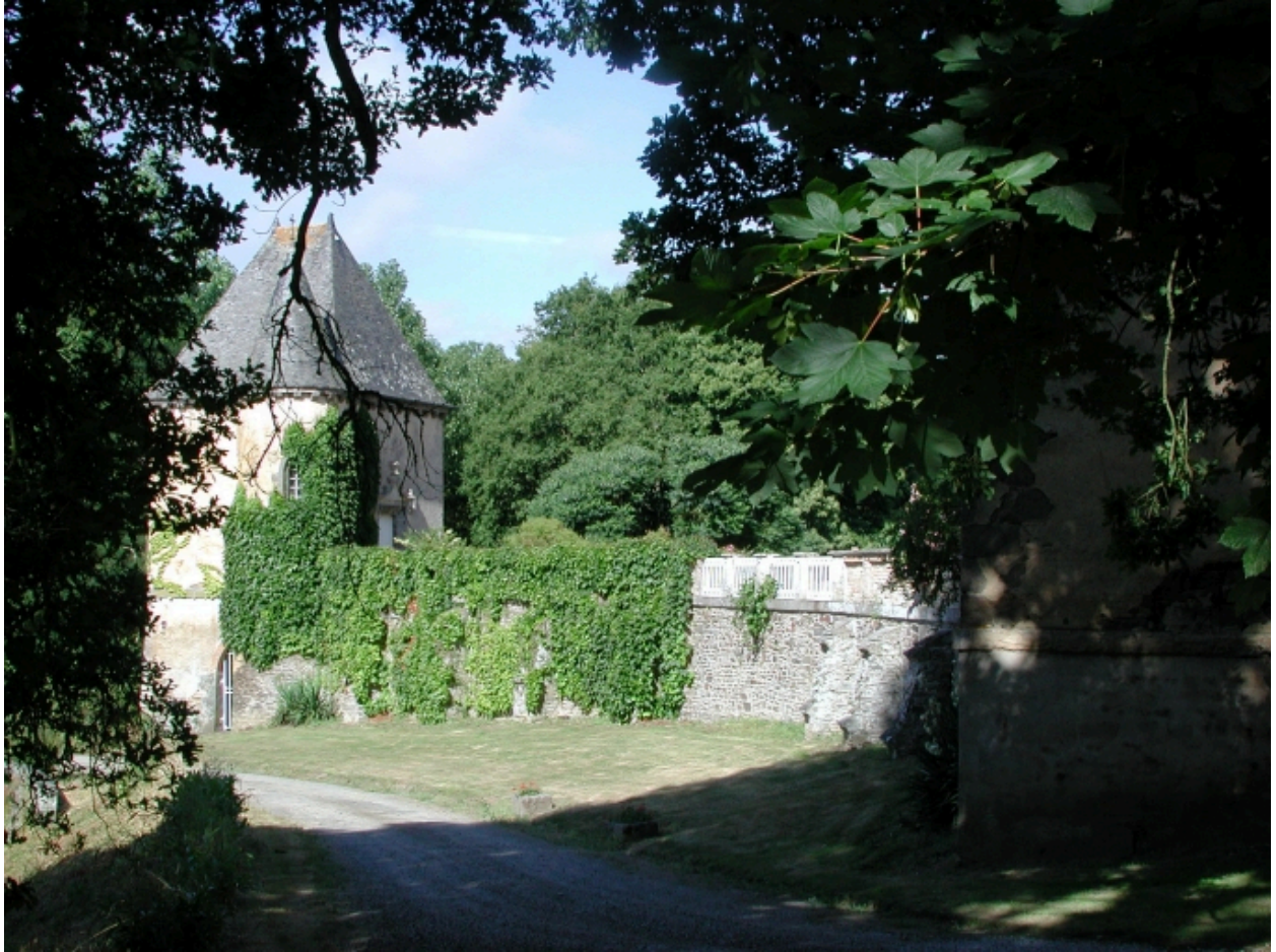
Vue partielle est
