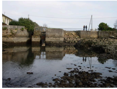
Ecluse du Sillon Phot. Guillaume Marie IVR53_20062908569NUCA
