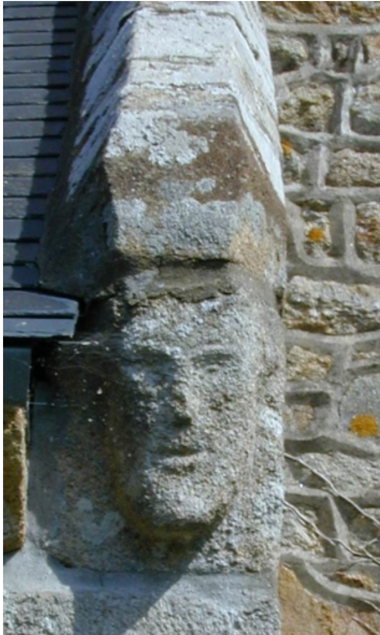
Rédené, église paroissiale Notre-Dame-de-Lorette : ancien ossuaire, partie est, crossette sculptée, état en 2004
