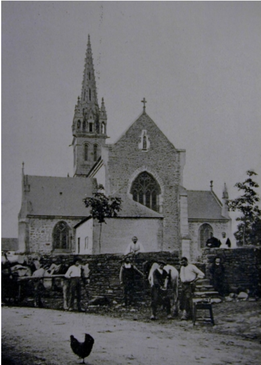
Rédené, église paroissiale Notre-Dame-de-Lorette : partie orientale, état après reconstruction, vers 1905, reproduction de 2004
