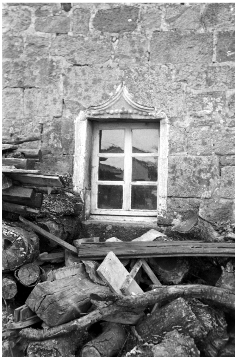
Façade sud, 1er niveau : détail de la fenêtre à l'est
