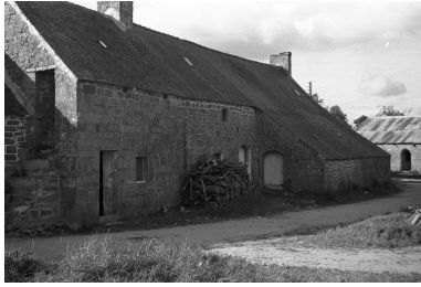
Façade sud : vue d'ensemble Phot. Brulon IVR53_19662200503Z
