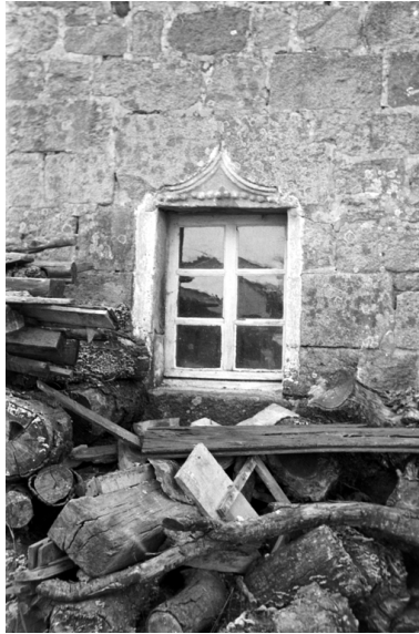
Façade sud, 1er niveau : détail de la fenêtre à l'est Phot. Brulon IVR53_19662200502Z
