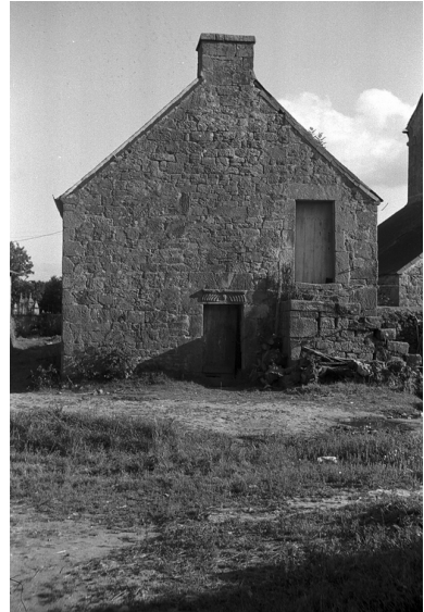
Bâtiment accolé à l'étable : vue d'ensemble du pignon Phot. Brulon IVR53_19662200504Z
