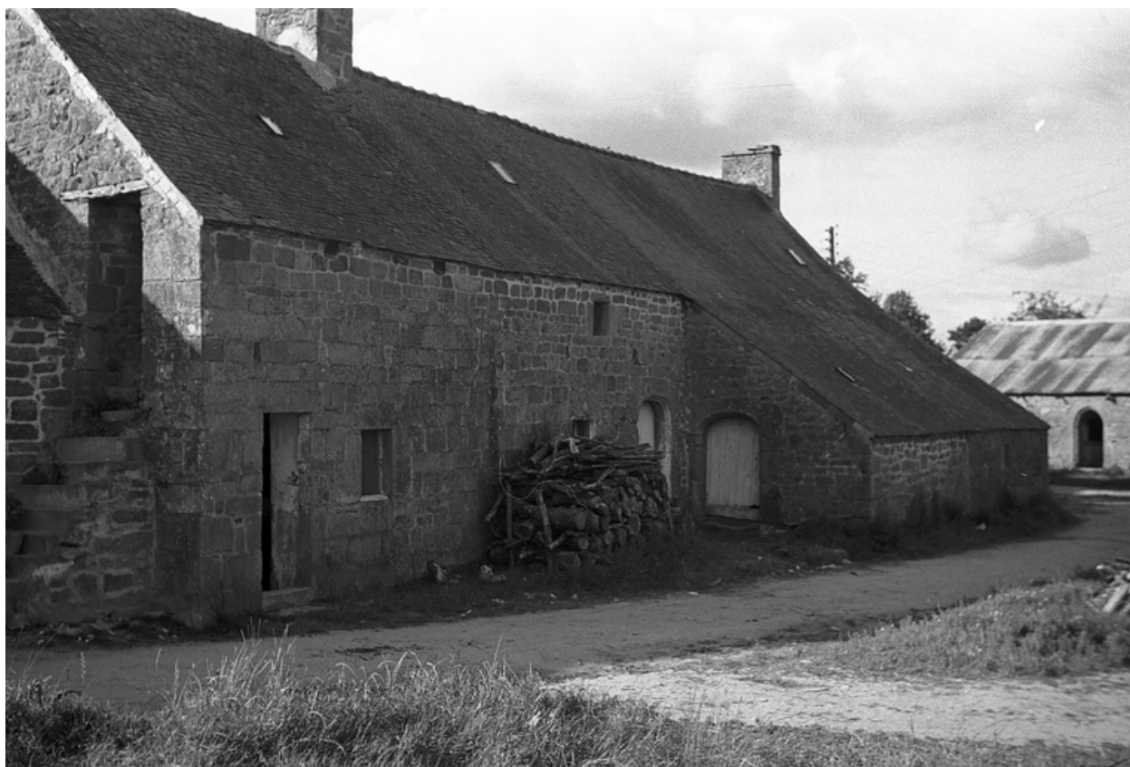
Façade sud : vue d'ensemble
