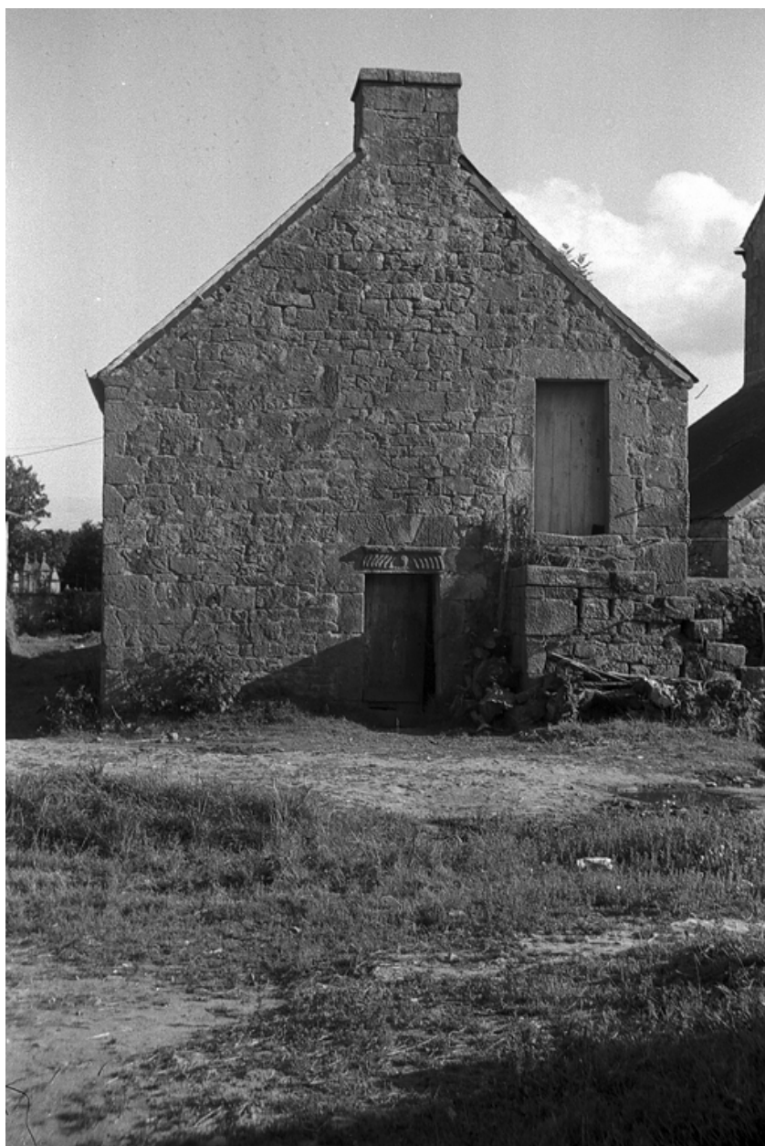
Bâtiment accolé à l'étable : vue d'ensemble du pignon
