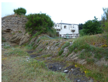
Locmaria, Port Andro, ancienne batterie et tour crénelée. Phot. Patrick Jadé IVR53_20175607189NUCA
