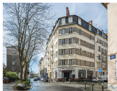
Immeubles, 12 et 14 rue du Docteur-Francis-Joly. Vue d'ensemble vers le sud. Phot. Charlotte Barraud IVR53_20243500451NUCA
