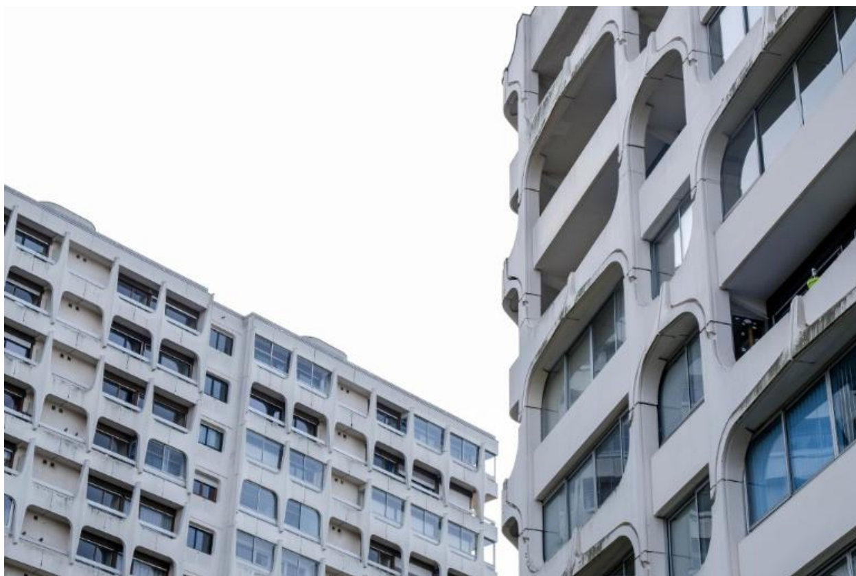
Vues de façades d'immeubles du Colombier.
