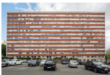
Grand ensemble, dit les Cloteaux. Elévation ouest du bâtiment B. Phot. Charlotte Barraud IVR53_20243500436NUCA
