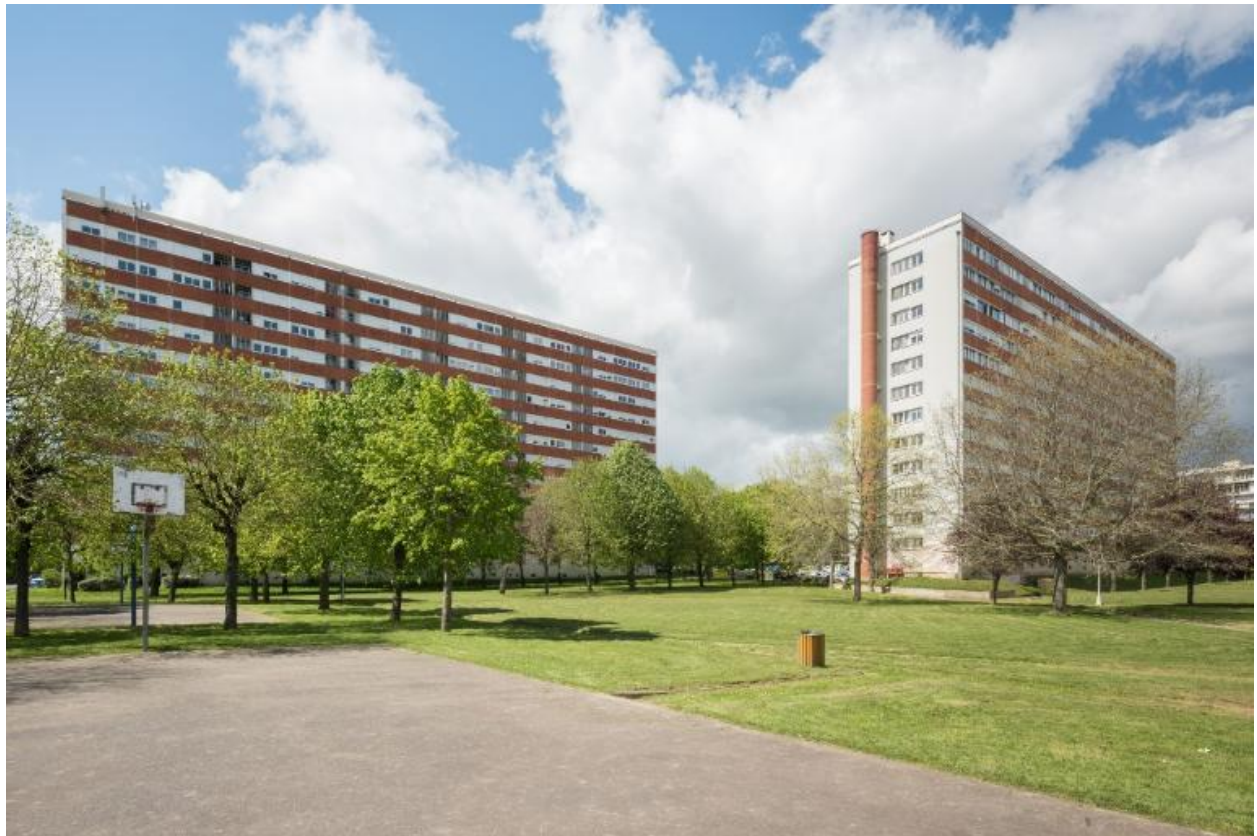
Grand ensemble, dit les Cloteaux. Vue des bâtiments A et B.
