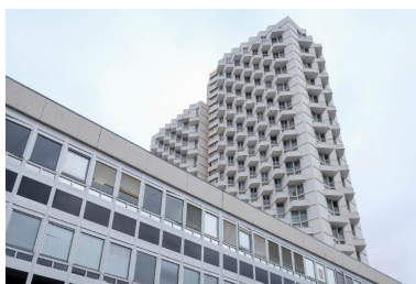
L'Eperon, vue de la façade ouest. Phot. Candice Hazouard IVR53_20193506328NUCA
