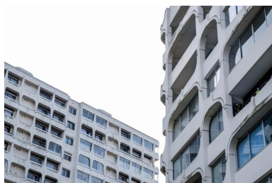
Vues de façades d'immeubles du Colombier. Phot. Candice Hazouard IVR53_20193506301NUCA
