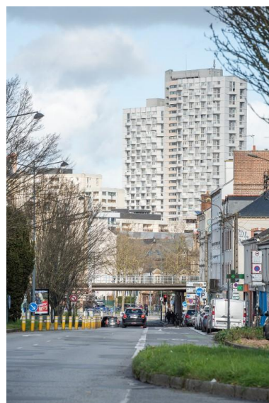
Vue du pont de Nantes vers le nord. En arrière-plan, l'immeuble de grande hauteur dit l'Eperon. Phot. Léna Leroy IVR53_20253500341NUCA
