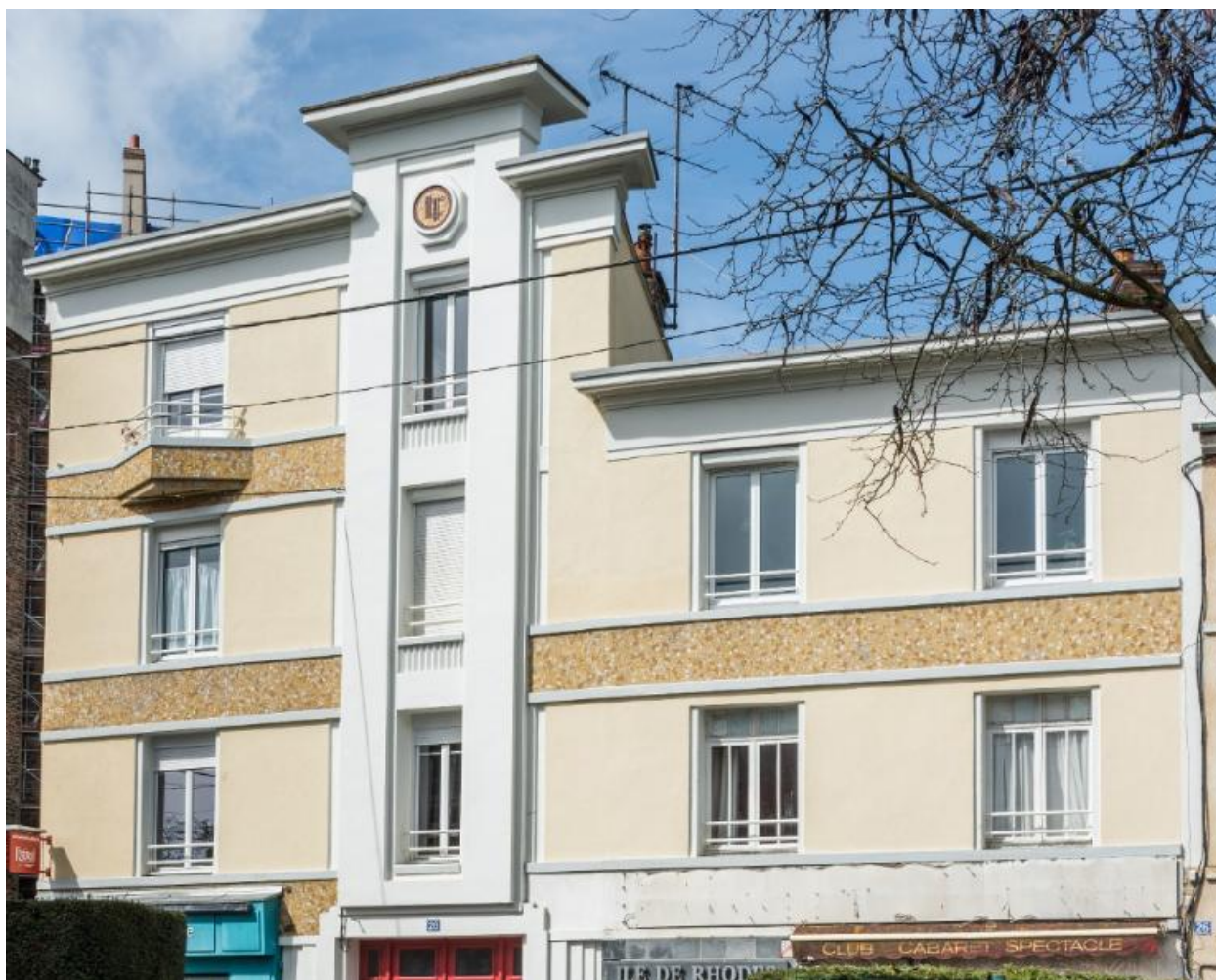
Immeuble de rapport, 26b et 28 rue du Docteur-Francis-Joly. Elévation antérieure orientée vers l'est.
