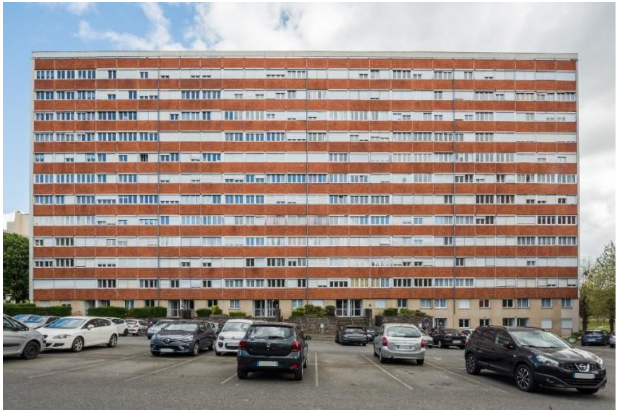
Grand ensemble, dit les Cloteaux. Elévation ouest du bâtiment B.
