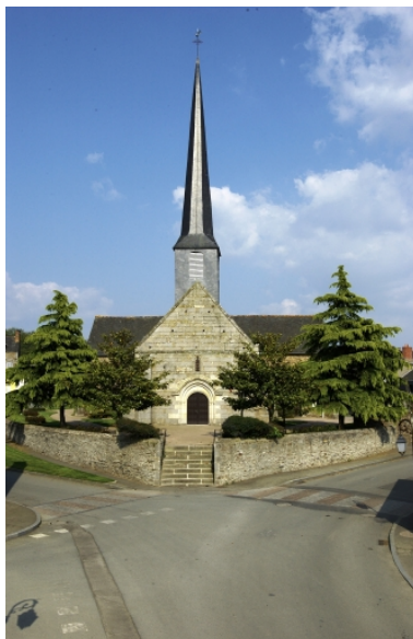
Vue générale ouest Phot. Norbert Lambart IVR53_20063500955NUCA
