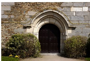
Porte sud Phot. Bernard Bègne IVR53_20063500820NUCA
