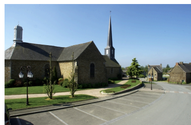
Vue de situation nord est Phot. Norbert Lambart IVR53_20063518278NUCA
