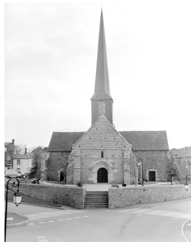
Vue générale ouest Phot. Guy Artur, Phot. Norbert Lambart IVR53_19943500741X
