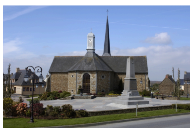
Vue générale est Phot. Bernard Bègne IVR53_20063500818NUCA
