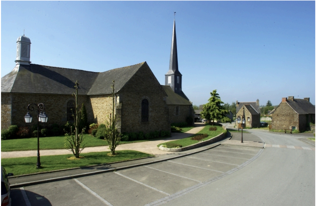
Vue de situation nord est
