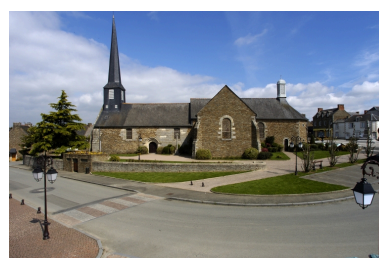
Vue générale sud Phot. Bernard Bègne IVR53_20063500819NUCA
