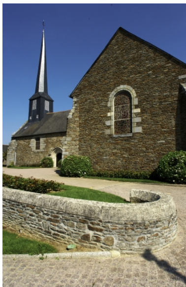
Vue partielle sud est Phot. Norbert Lambart IVR53_20063500885NUCA
