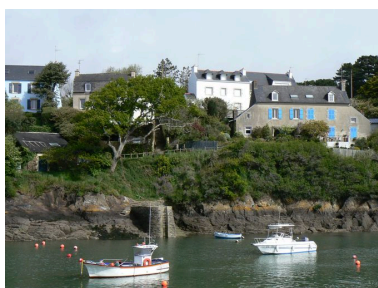
Vue générale de la zone d'activité portuaire artisanale 'Joseph Tonnerre' Phot. Julien Amghar IVR53_20082908569NUCA
