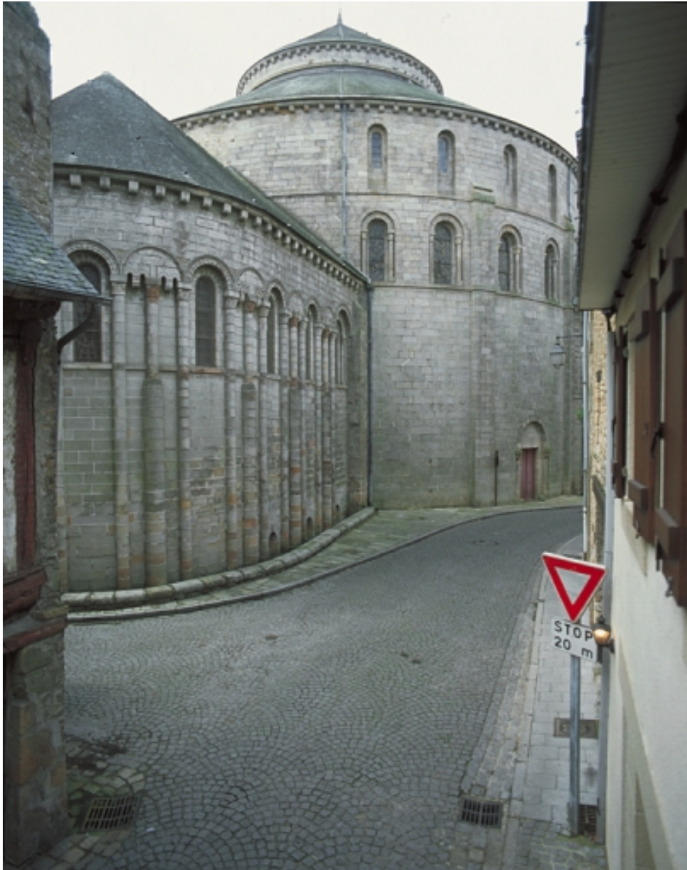
Vue générale nord-est
