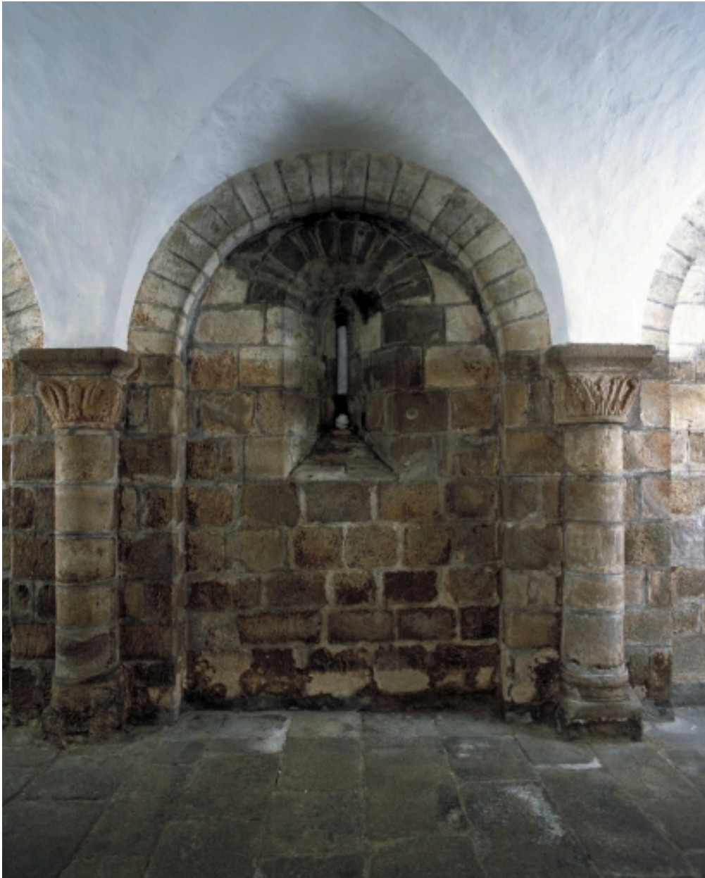
Crypte, mur sud, partie centrale
