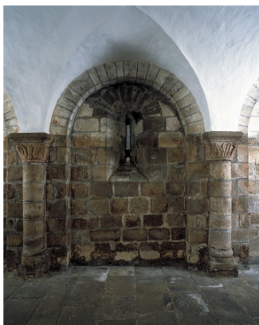
Crypte, mur sud, partie centrale Phot. Bernard Bègne IVR53_20022900170XA
