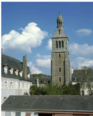
Clocher isolé, élévation sud Phot. Bernard Bègne
