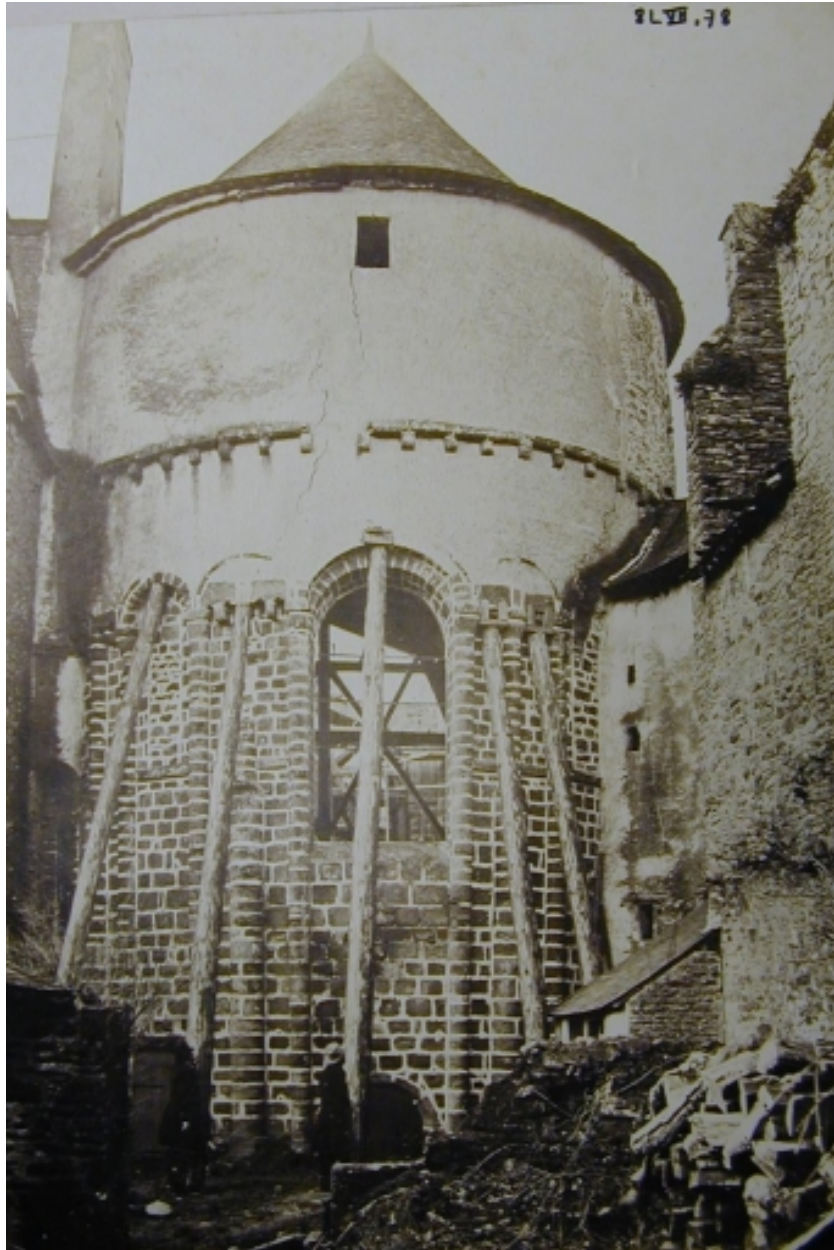
Elévation est de l'abside du choeur après le sinistre de 1862. Photographie de Villard (A.E. Quimper, Fonds Bigot)
