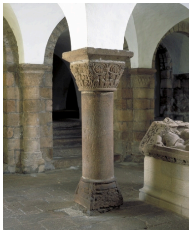
Crypte, travée sud, pilier ouest Phot. Bernard Bègne IVR53_20022900163XA
