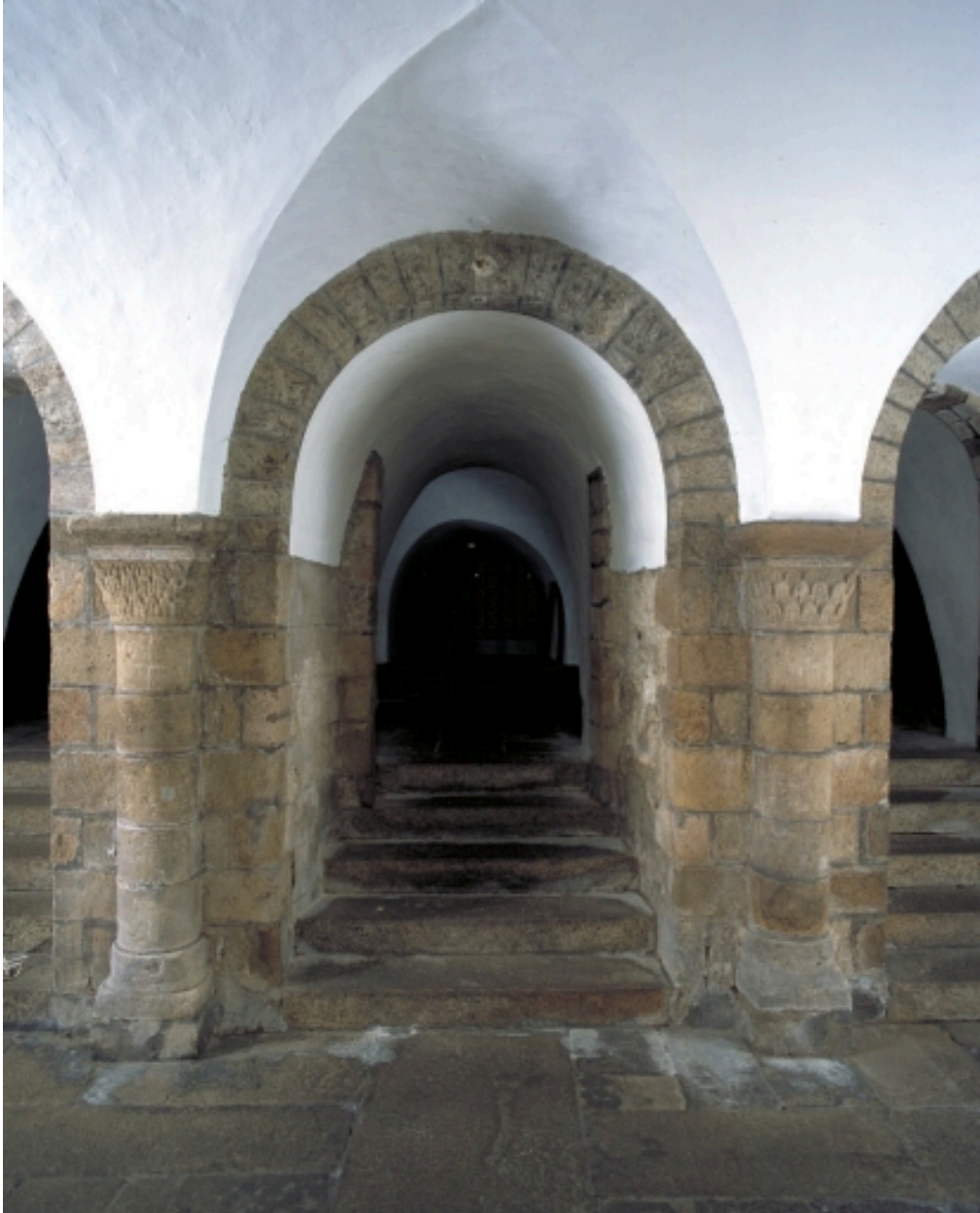
Crypte, travée centrale et mur ouest avec accès
