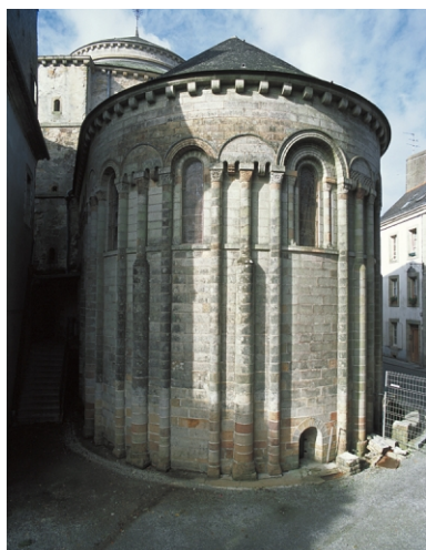
Vue de situation nord avec le clocher isolé Phot. Bernard Bègne IVR53_20022900359XA
