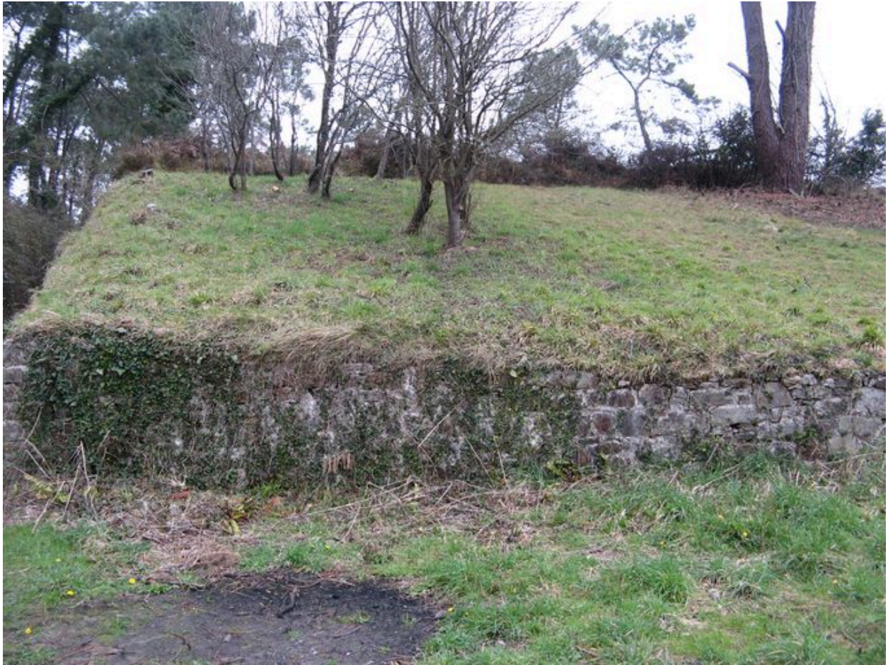
Vue du parapet en terre de la batterie basse du Kador
