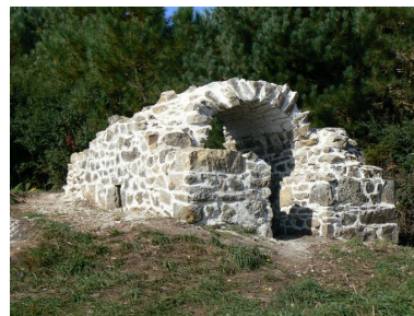
Vue du corps de garde restauré de la batterie haute du Kador Phot. Julien Amghar IVR53_20072908882NUCA
