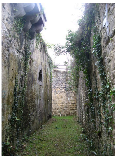
Vue de la tranchée de service de la batterie basse du Kador Phot. Guillaume Marie
