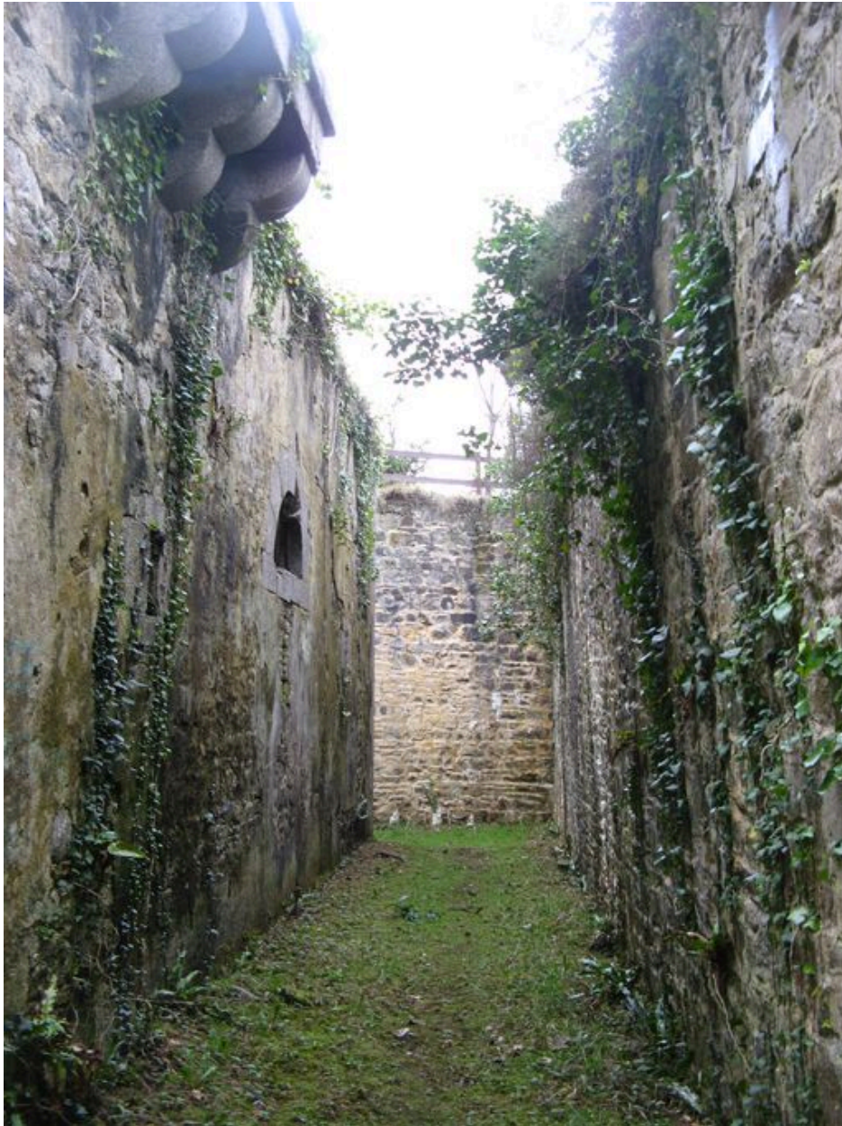
Vue de la tranchée de service de la batterie basse du Kador
