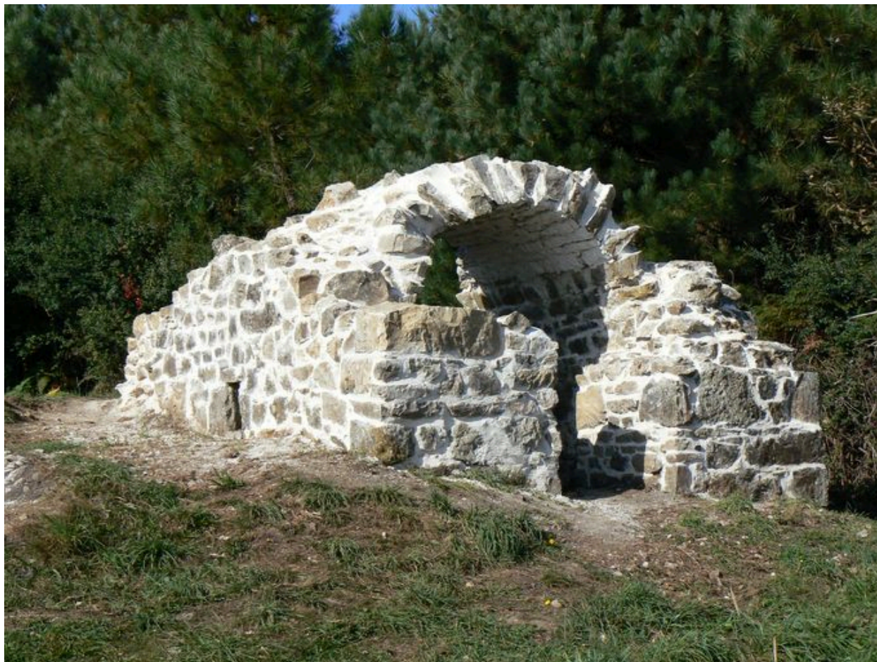
Vue du corps de garde restauré de la batterie haute du Kador
