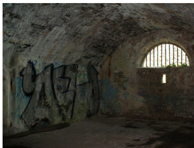
Vue intérieure du réduit de la batterie basse du Kador Phot. Julien Amghar IVR53_20072908881NUCA
