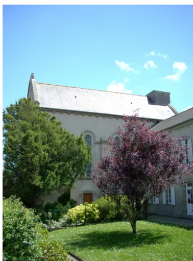
Saint-Renan, chapelle Saint-Yves : vue générale sud-ouest Phot. Gwénaél Fauchille IVR53_20082906265NUCA
