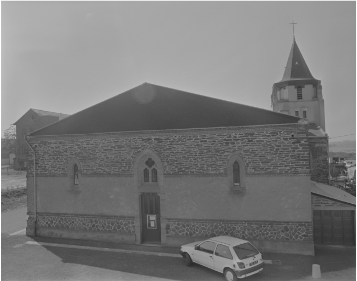
Elévation est : vue générale
