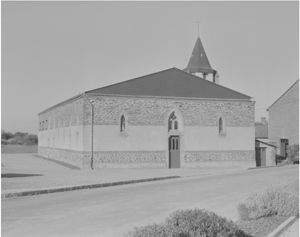
Elévation est : vue générale
