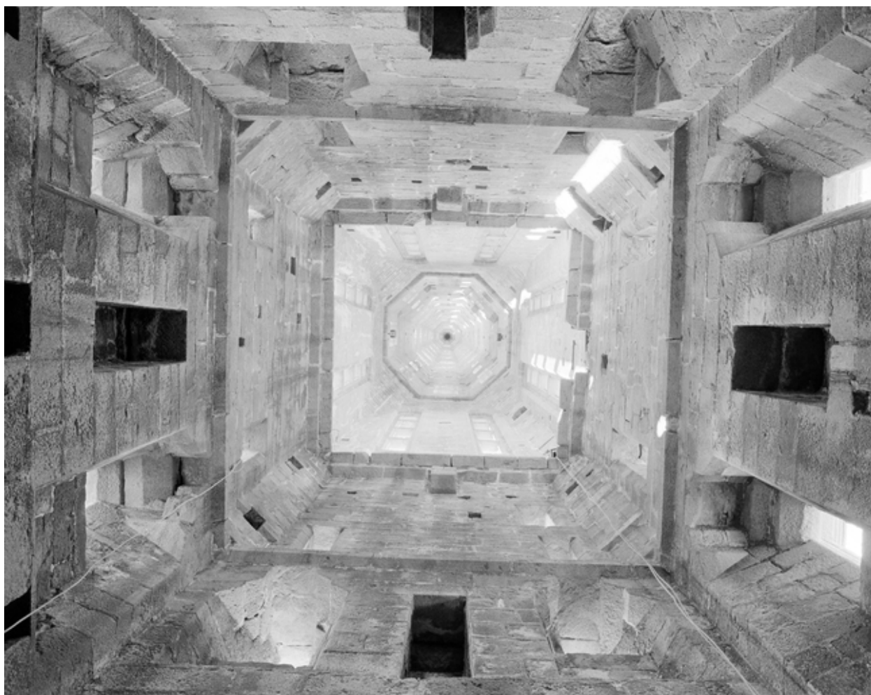
Accès au clocher, 1er niveau, flèche prise de l'intérieur
