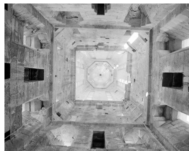
Accès au clocher, 1er niveau, flèche prise de l'intérieur Phot. Guy Artur, Phot. Norbert Lambart IVR53_19842900807X
