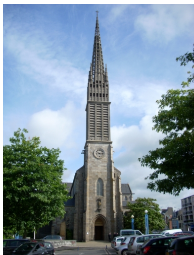
Eglise Saint-Laurent de Lambézellec : vue générale ouest Phot. Gwénaél Fauchille IVR53_20082906041NUCA
