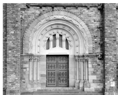
Elévation nord, porte : vue générale Phot. Guy Artur, Phot. Norbert Lambart IVR53_19943500924X
