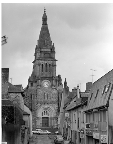
Elévation nord, partie ouest : vue générale Phot. Guy Artur, Phot. Norbert Lambart IVR53_19943500923X
