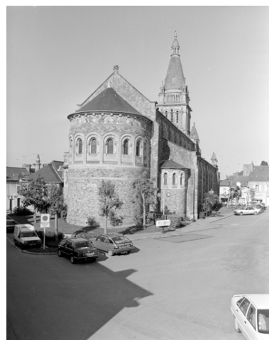
Elevation est : vue générale Phot. Guy Artur, Phot. Norbert Lambart IVR53_19943500951X
