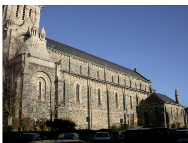
Vue sud Phot. Sabrina Dalibard IVR53_20053514678NUCA
