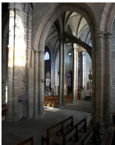
Intérieur, vue biaise du collatéral sud du chœur Phot. Norbert Lambart IVR53_20072200458NUCA
