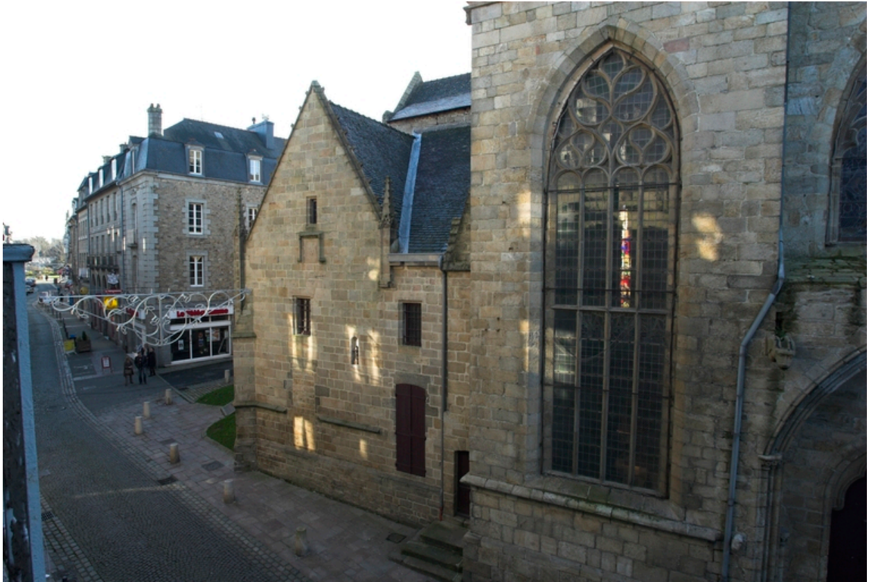
Vue de la sacristie depuis la rue Jean Le Moal
