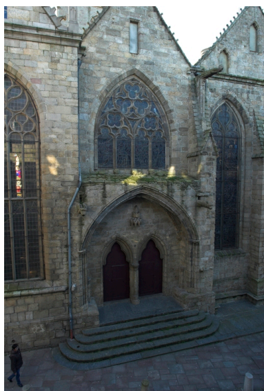
Vue du bras nord depuis la rue Jean Le Moal Phot. Norbert Lambart IVR53_20072200456NUCA
