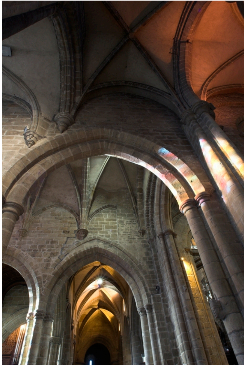
Bras sud, vue partielle des voûtes
