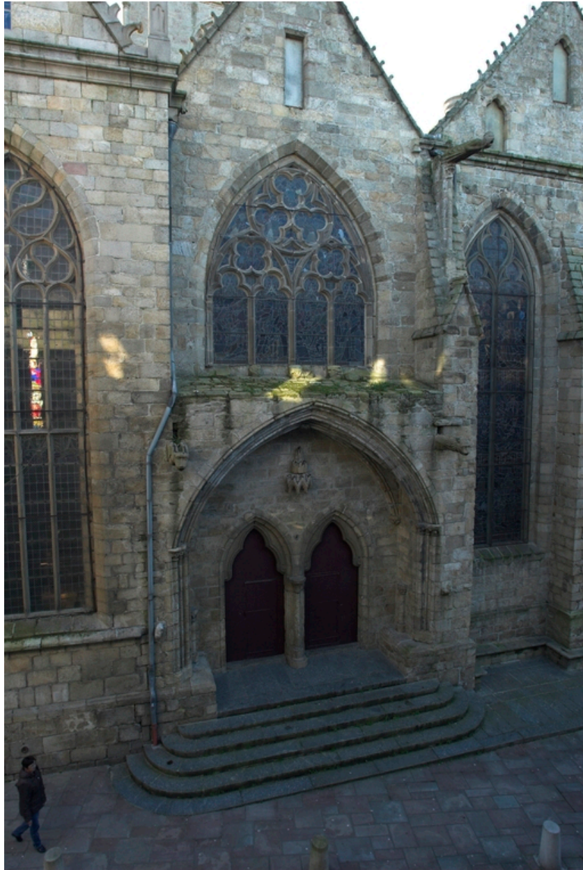
Vue du bras nord depuis la rue Jean Le Moal
