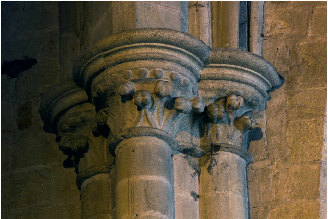
Chapiteaux des piles du choeur, collatéral sud
