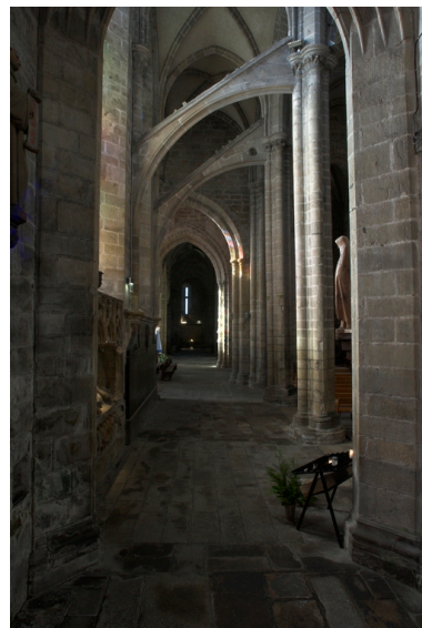
Collatéral sud du choeur, vue vers l'ouest Phot. Norbert Lambart IVR53_20072200462NUCA
