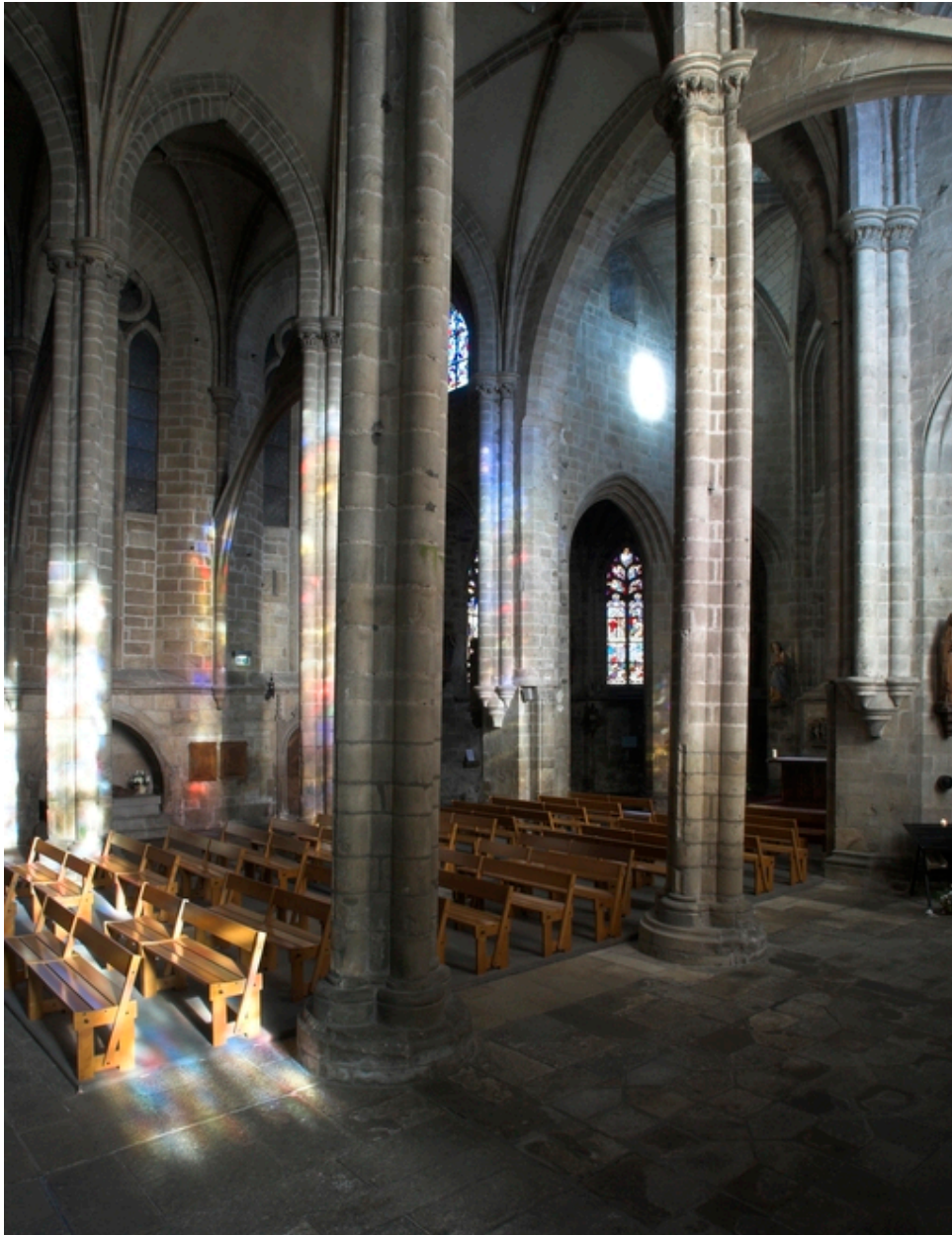
Intérieur, vue biaise du choeur depuis le collatéral sud
