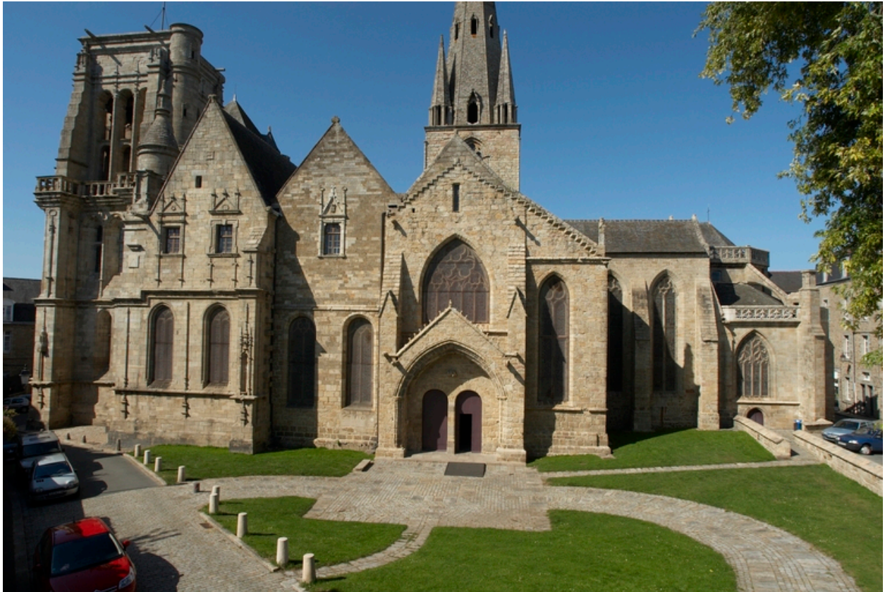
Elévation sud, vue générale
