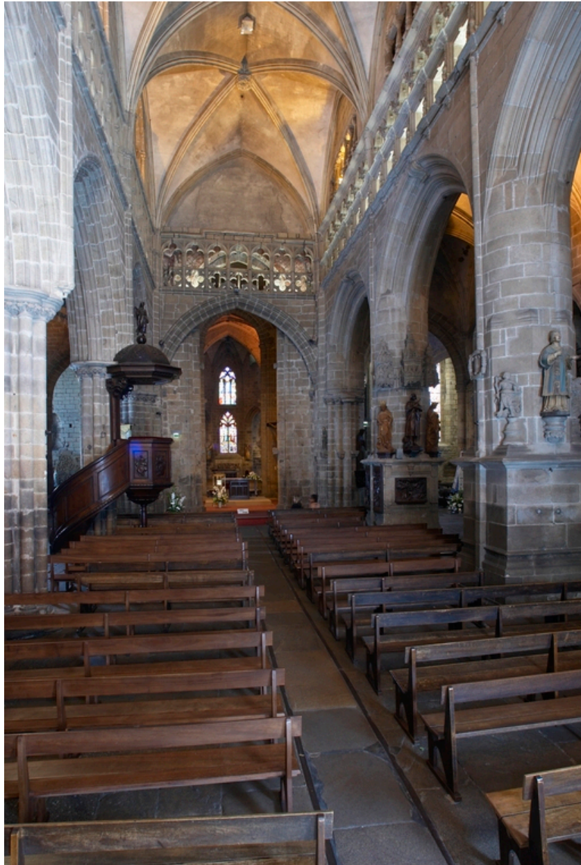
Intérieur, vue générale de la nef vers le chœur
