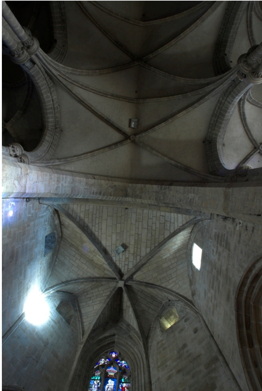
Choeur, vue des voûtes de l'abside
