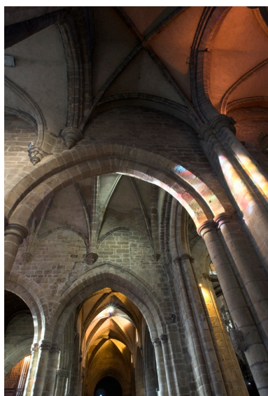
Bras sud, vue partielle des voûtes Phot. Norbert Lambart IVR53_20072200466NUCA
