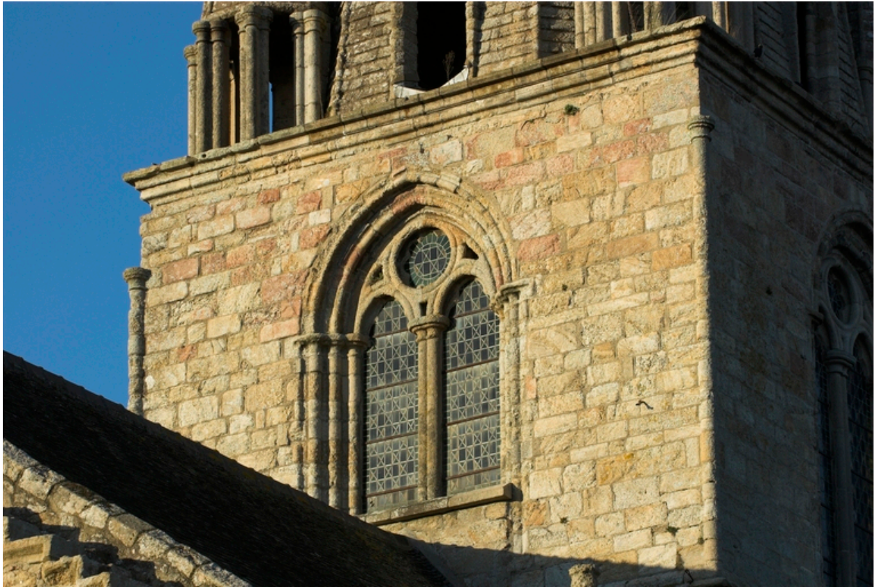
Détail face sud de la tour de croisée
