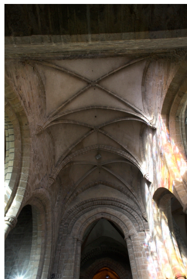
Vue des voûtes du bras sud Phot. Norbert Lambart IVR53_20072200465NUCA
