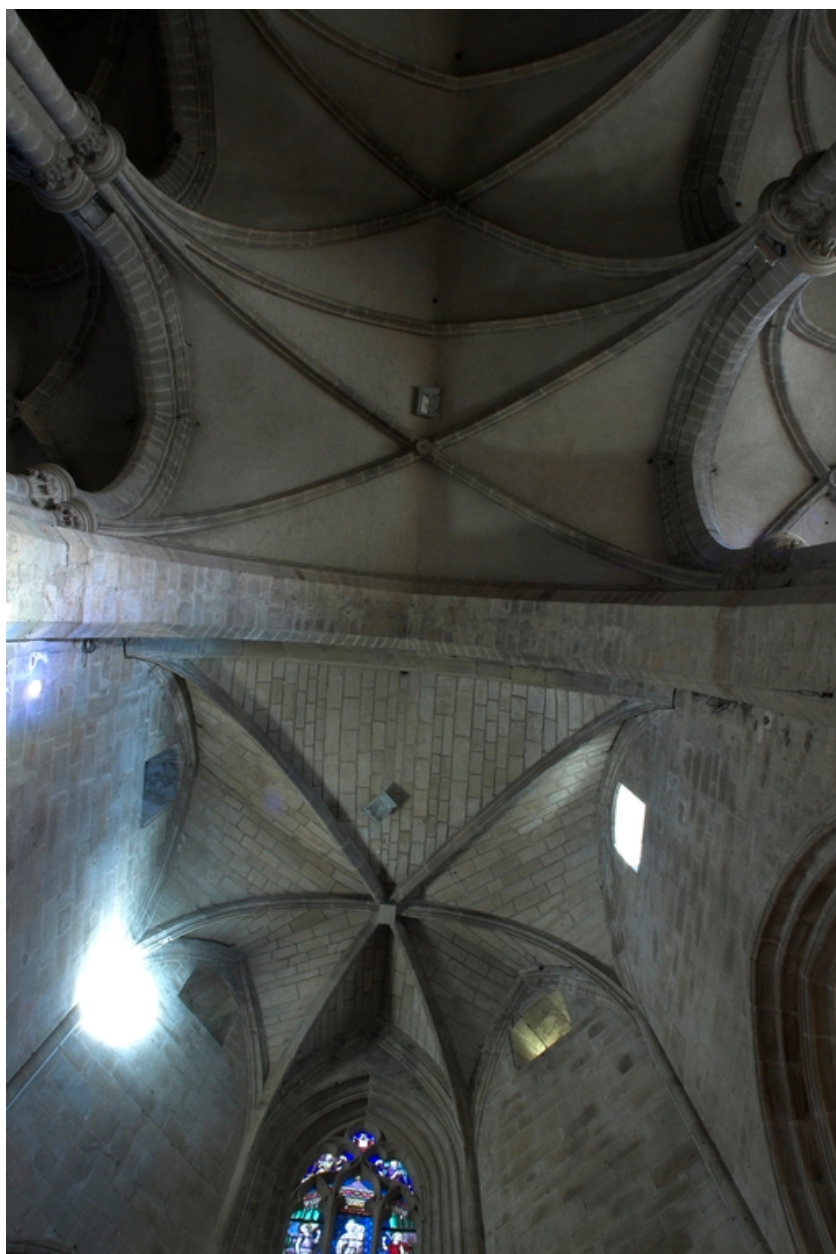
Choeur, vue des voûtes de l'abside
