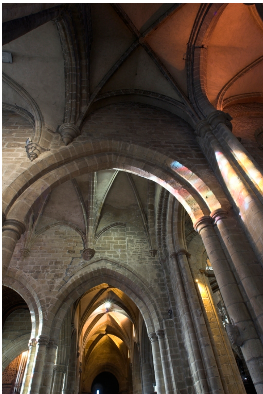
Bras sud, vue partielle des voûtes
