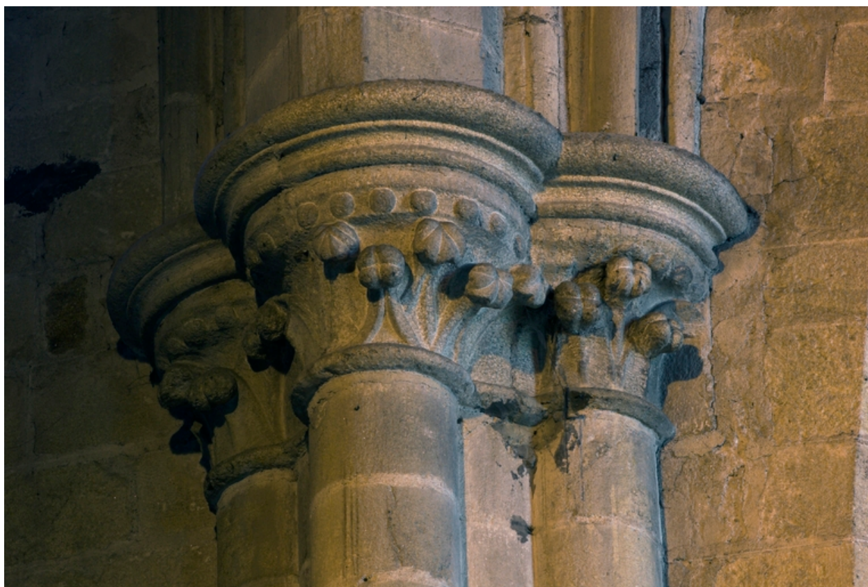
Chapiteaux des piles du choeur, collatéral sud
