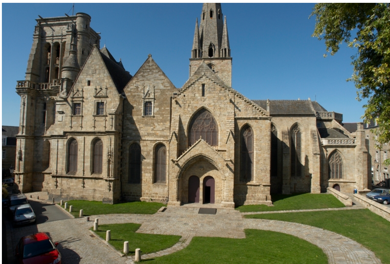
Elévation sud, vue générale
