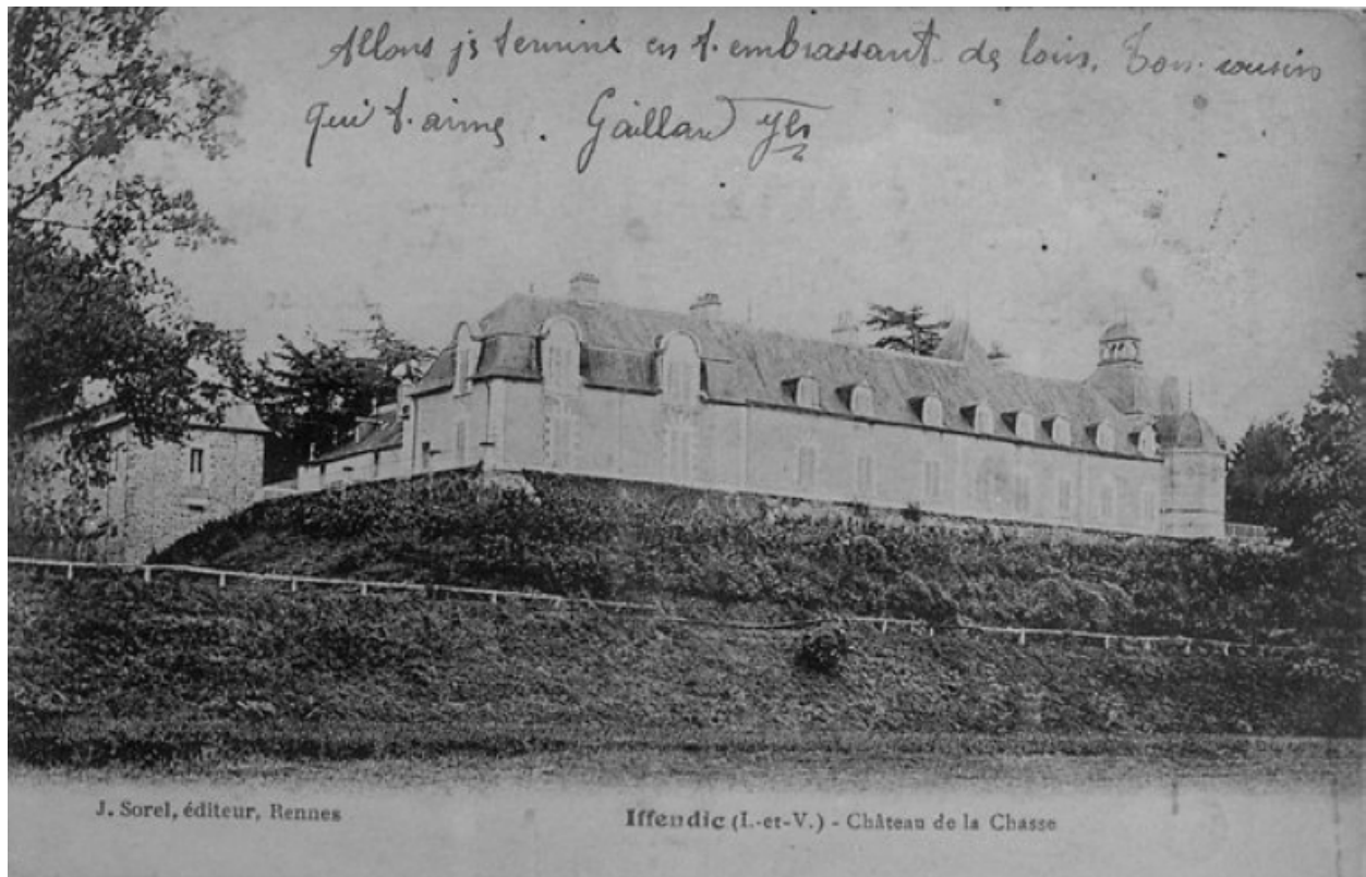
Vue générale de la façade arrière
