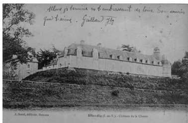
Vue générale de la façade arrière Phot. Auteur inconnu IVR53_19883500301XB
