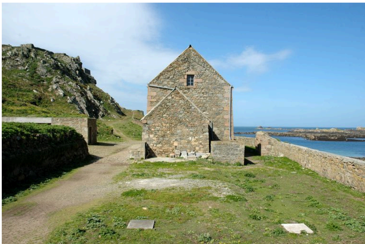
Vue générale (état en 2006). Le terre-plein accueille la caserne, un parapet et une porte commandant la cale
