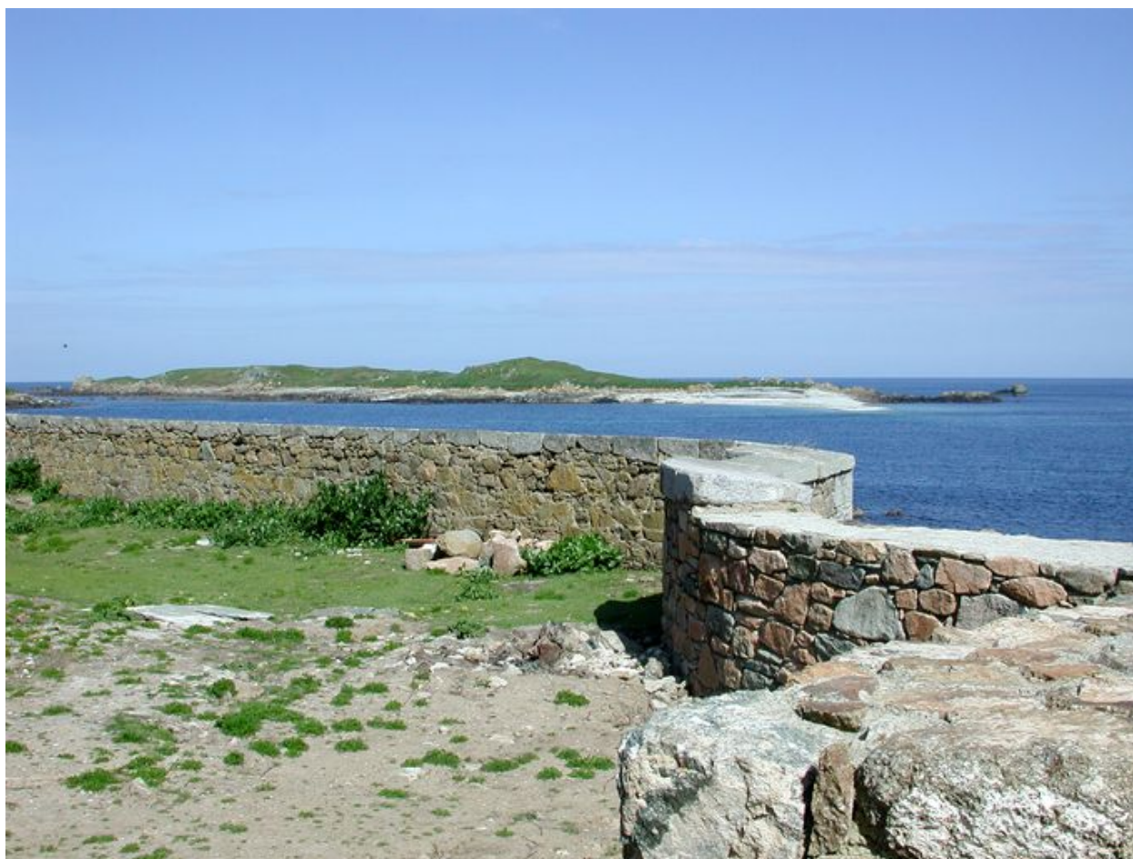
Vue d'une partie du parapet (état en 2006)
