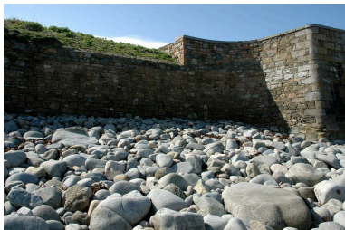
Vue générale depuis la grève (état en 2006) Phot. Guillaume Lécueillier IVR53_20062210050NUCA
