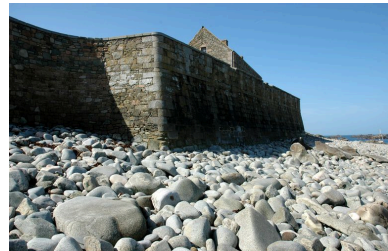
Vue générale depuis la grève (état en 2006) Phot. Guillaume Lécueillier IVR53_20062210051NUCA
