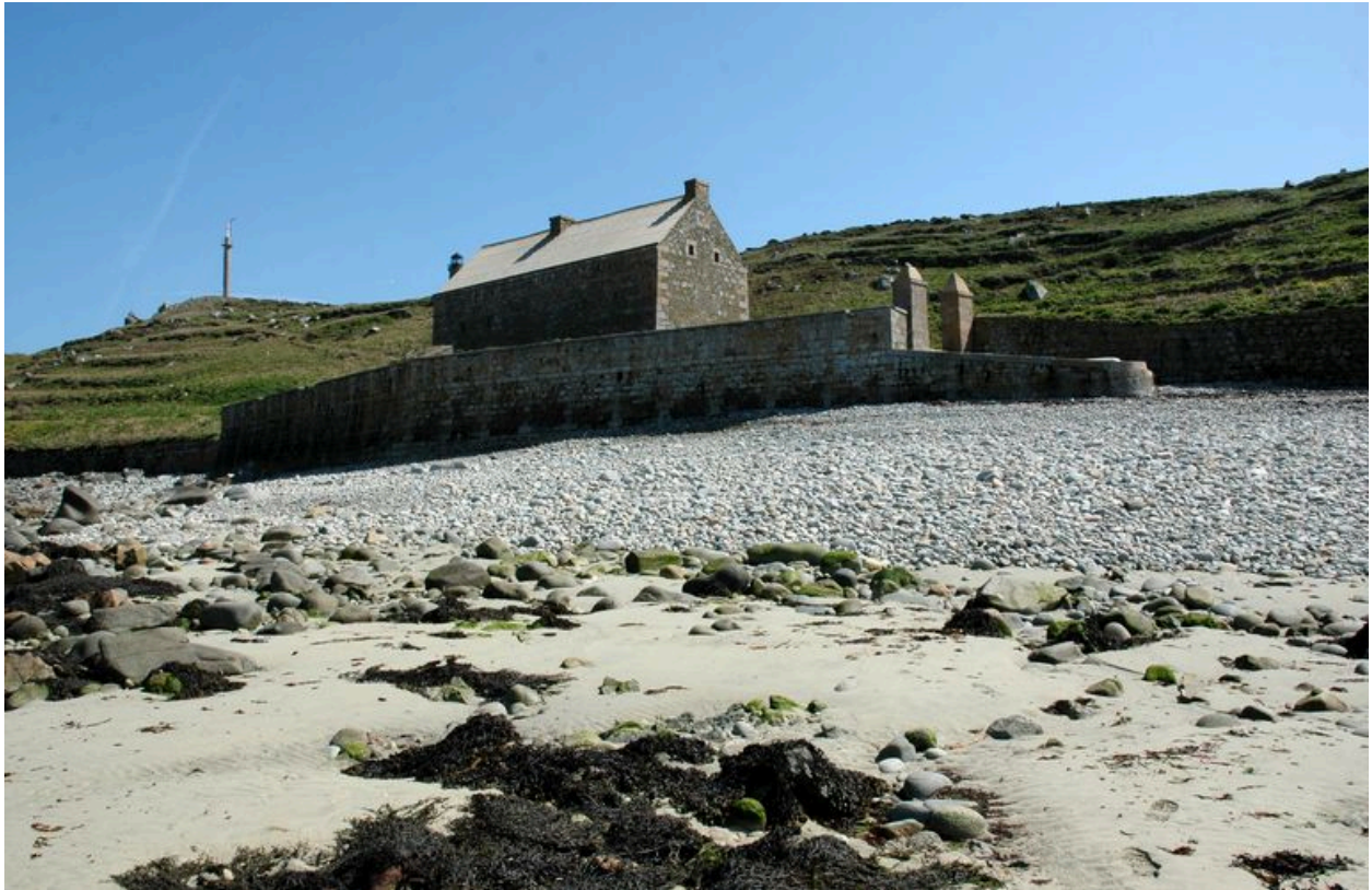
Vue de situation (état en 2006). Le terre-plein accueille la caserne, un parapet et une porte commandant la cale
