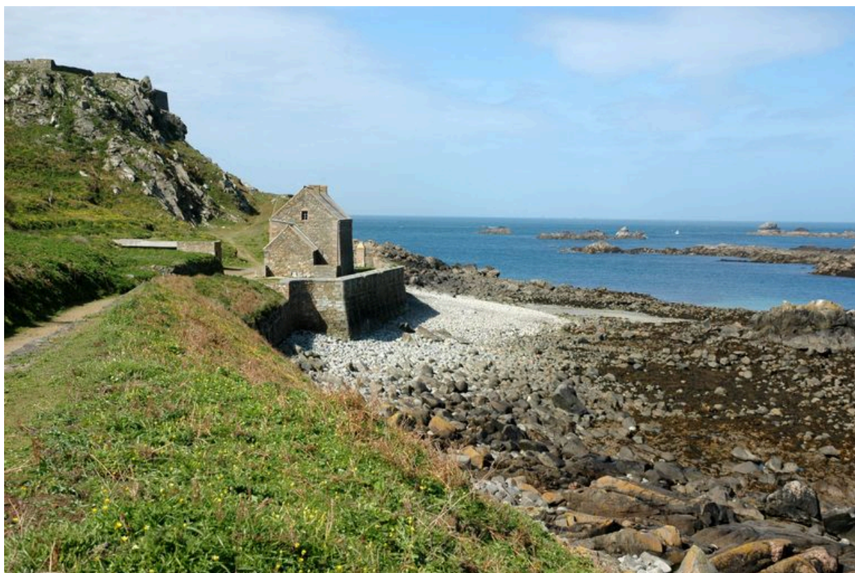
Vue de situation (état en 2006). Le terre-plein accueille la caserne, un parapet et une porte commandant la cale
