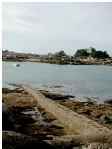
La forme rectiligne de la cale Phot. Guy Prigent IVR53_20062207755NUCA
