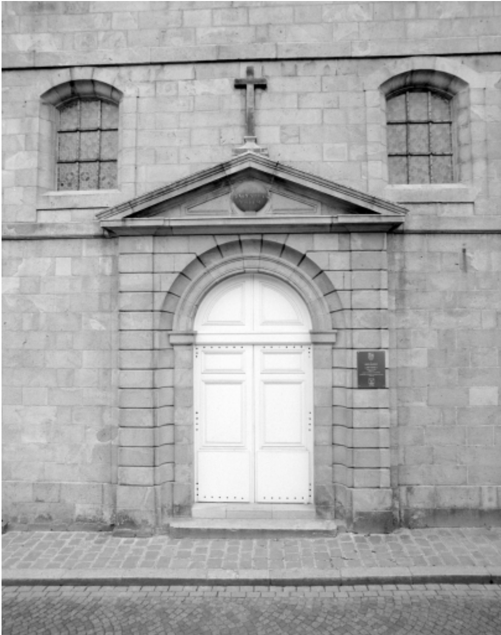
Elévation Nord, porte : vue générale
