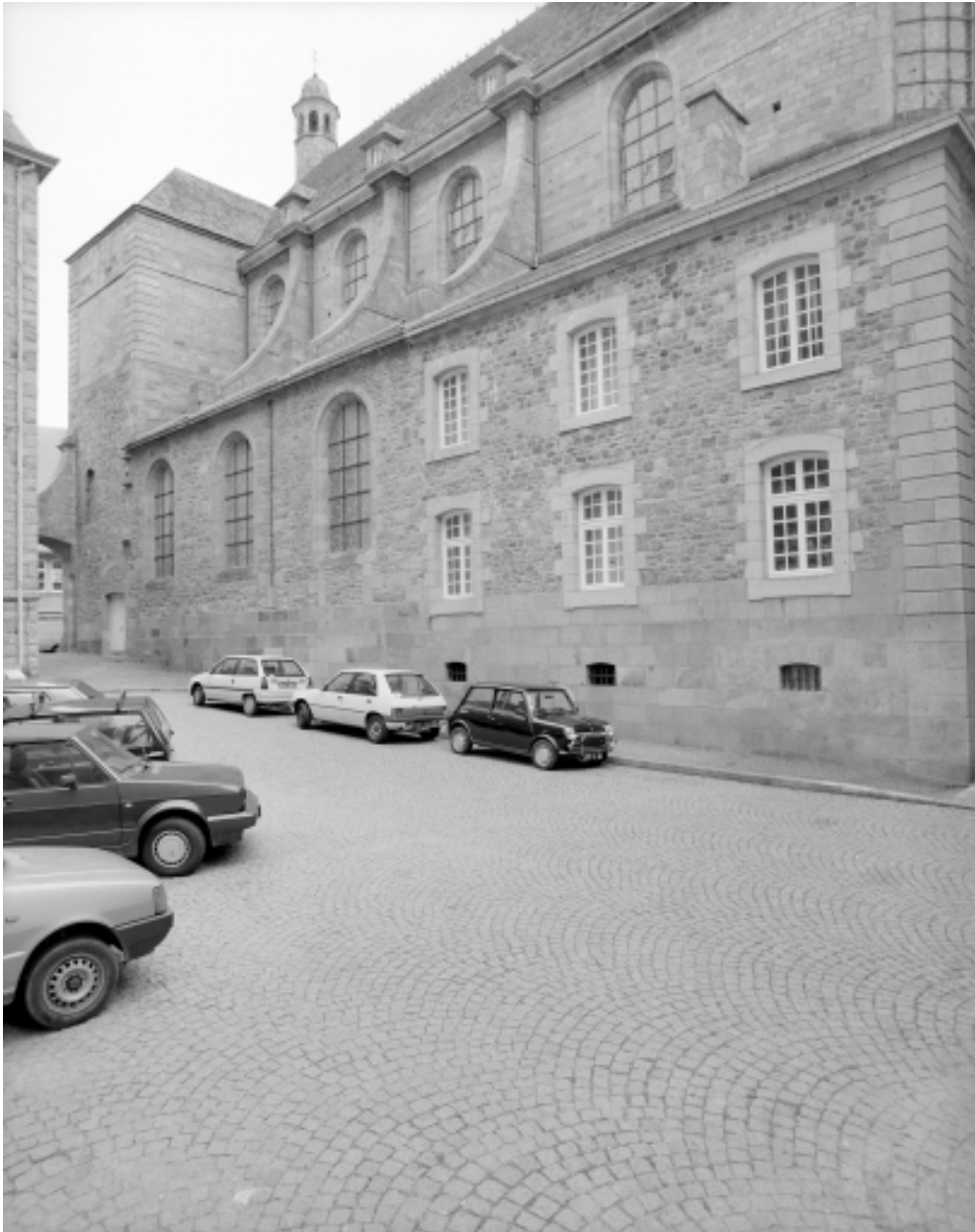
Elévation Ouest : vue générale
