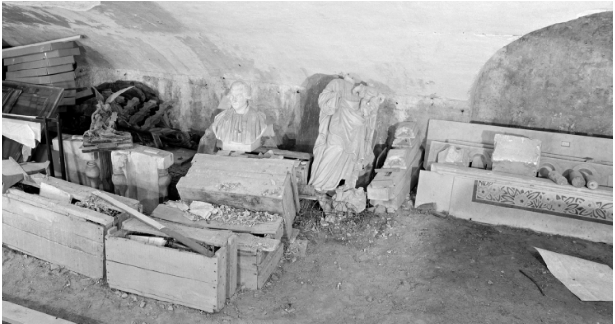
Crypte, mur : vue générale
