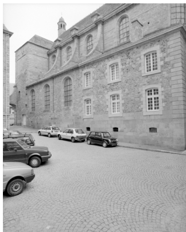
Elévation Ouest : vue générale
