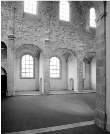
Intérieur, bras Ouest du transept : vue générale Phot. A. Boden IVR53_19943500158X
