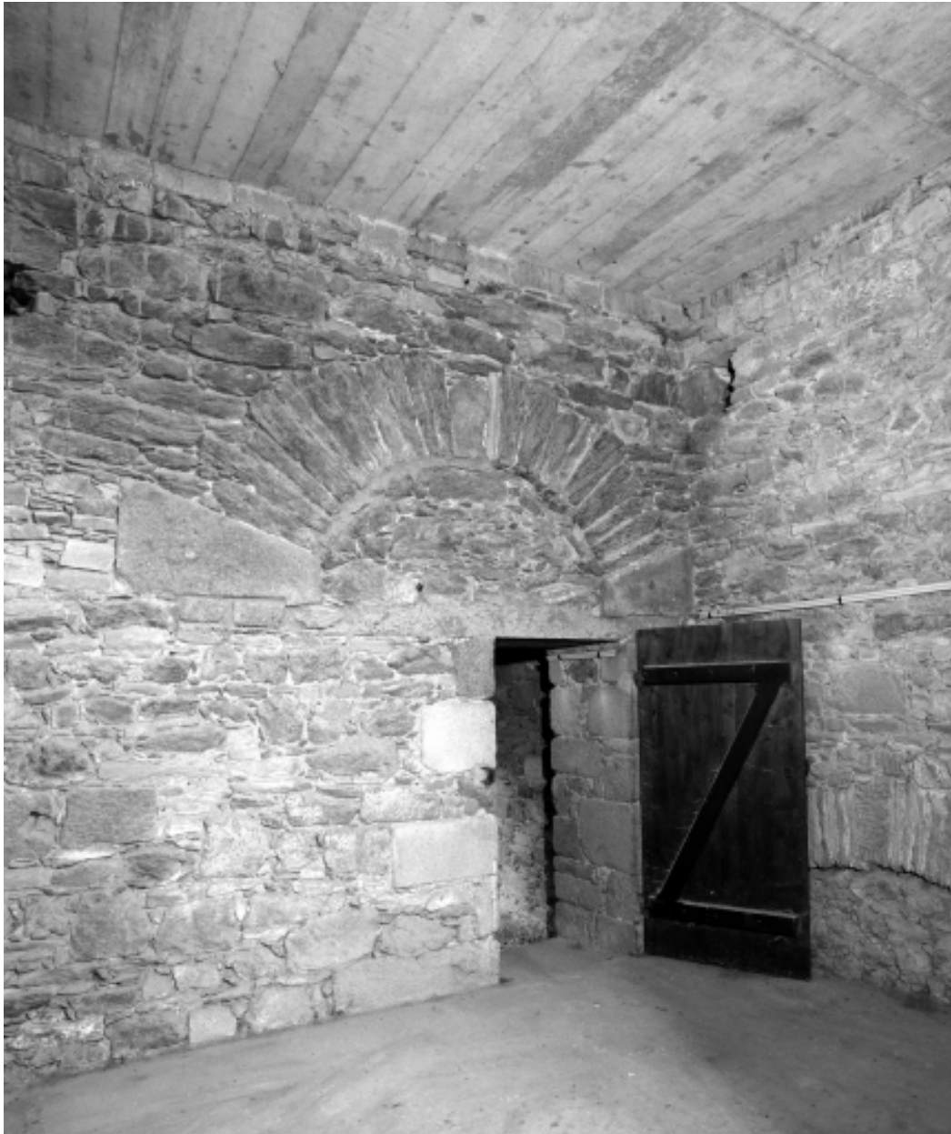
Intérieur, deuxième niveau, bas-coté, porte : vue générale
