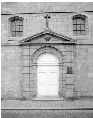
Elévation Nord, porte : vue générale
