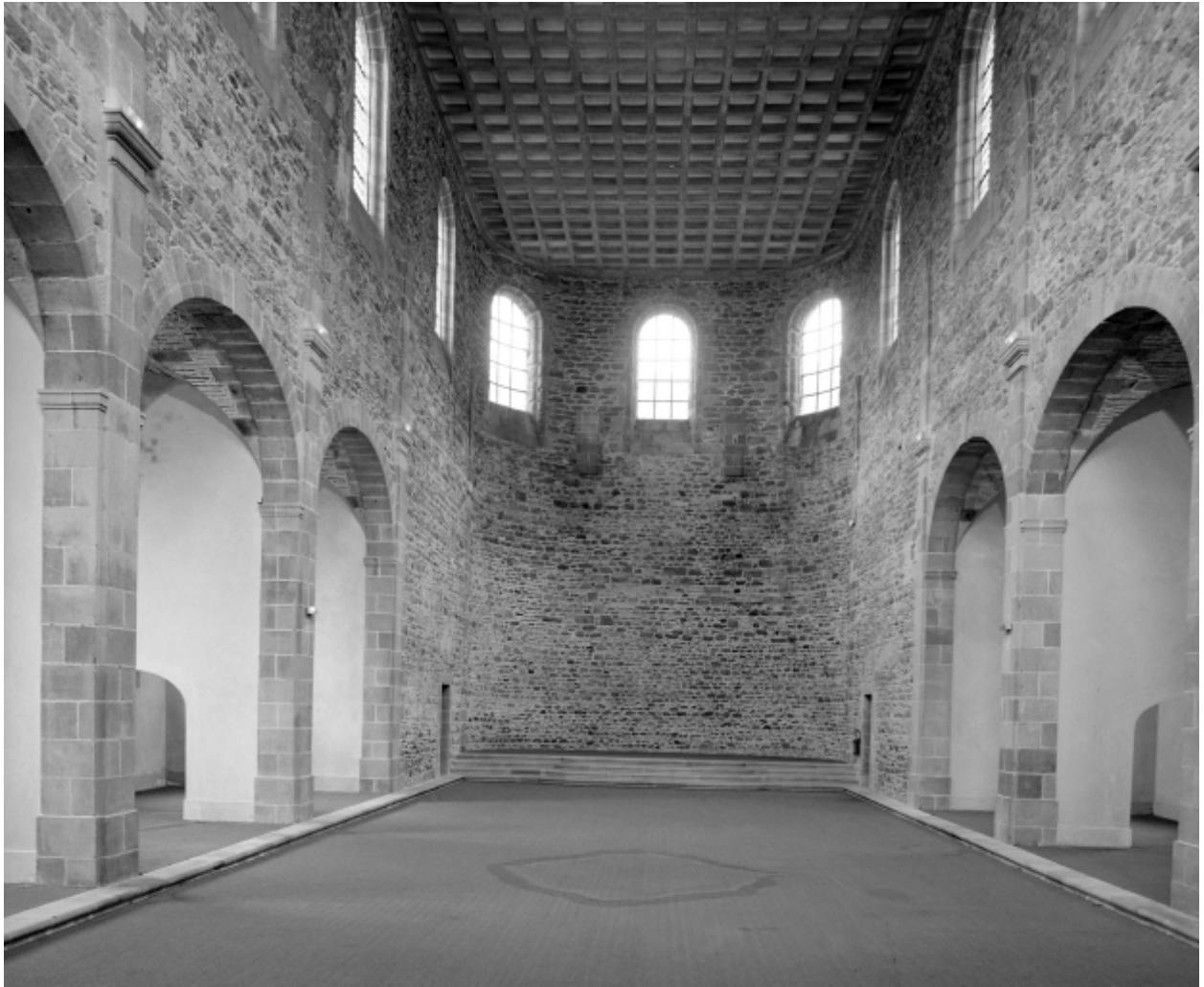
Intérieur : vue générale vers le chœur
