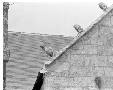
Première chapelle sud, rampant ouest Phot. Lanvéoc-Poulmic IVR53_19802900476X
