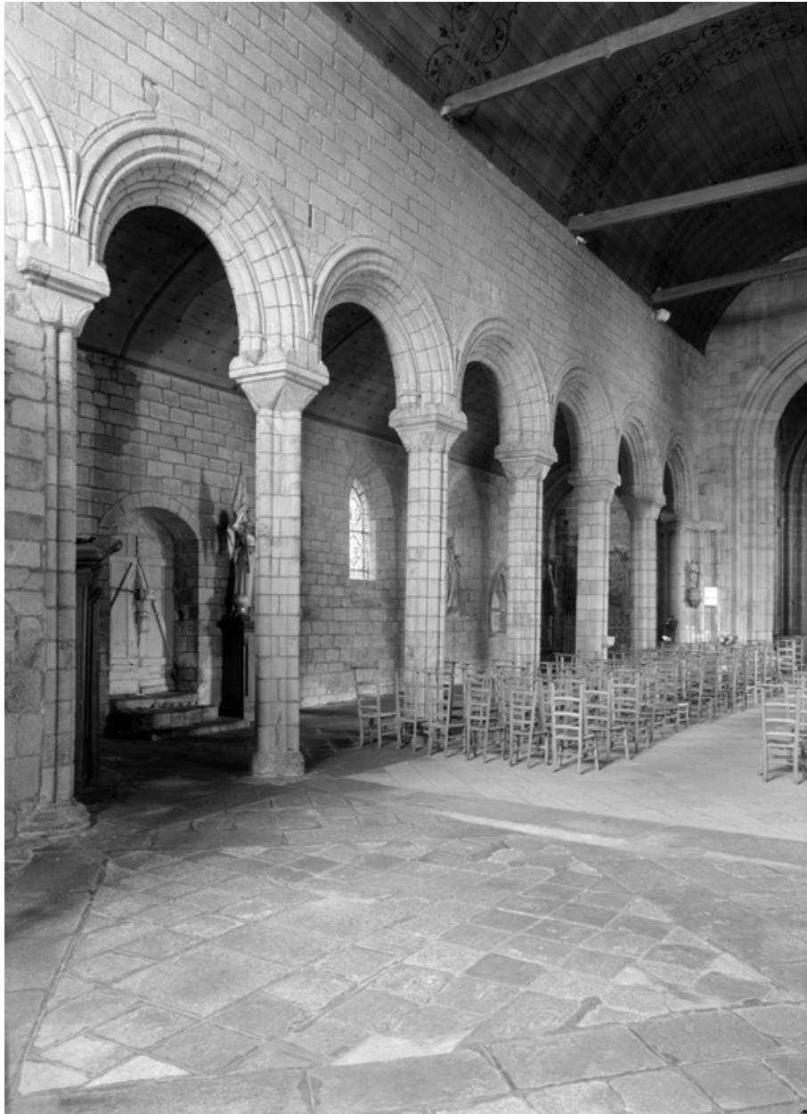
Nef, arcades nord, vue générale ouest
