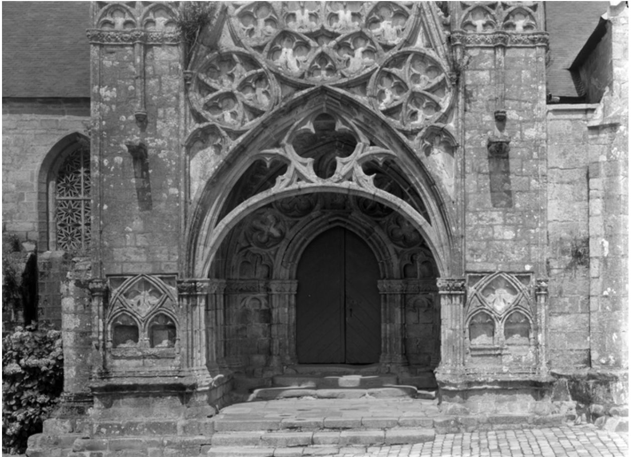
Porche sud, partie inférieure
