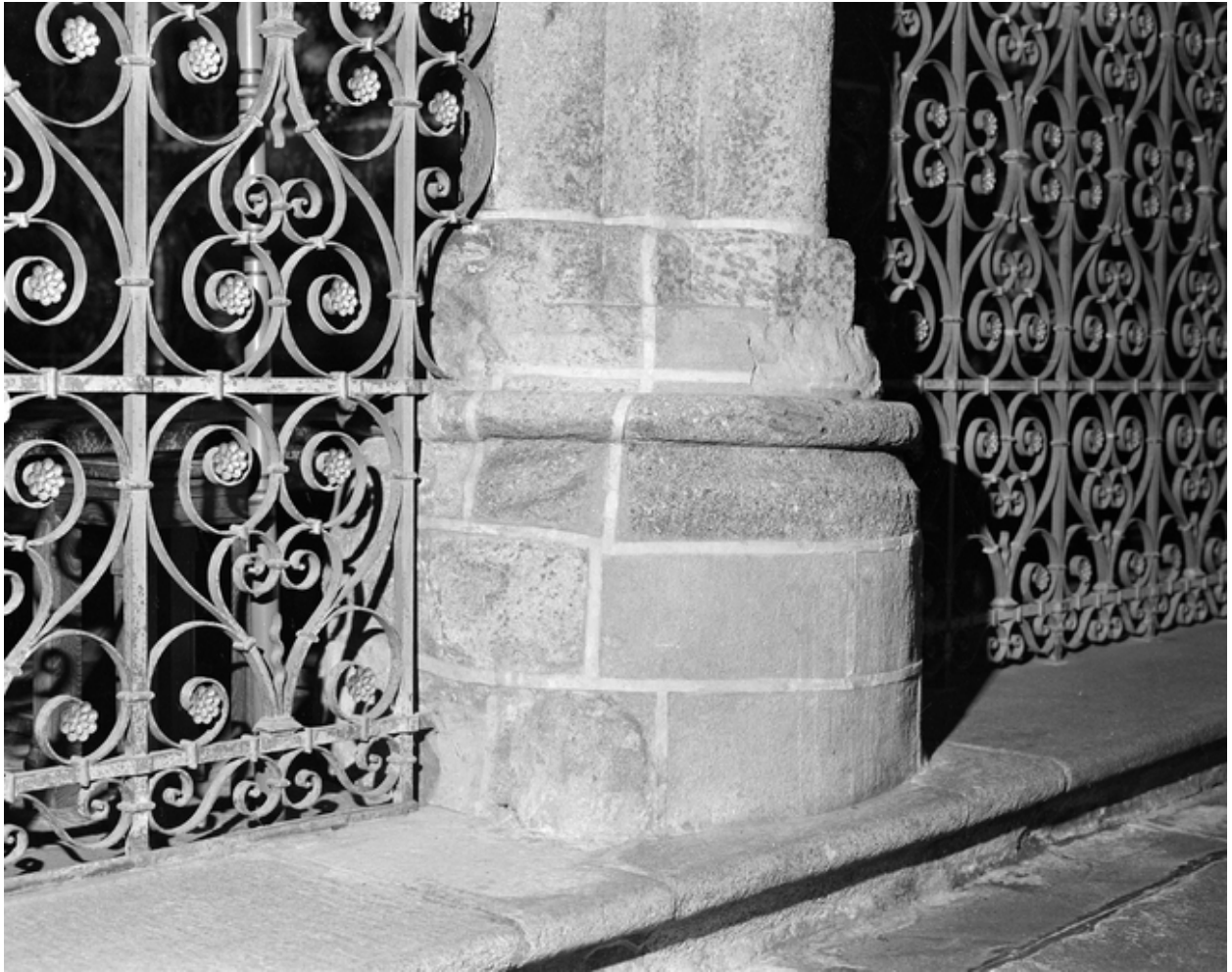
Choeur, partie est, 1ère pile sud, base
