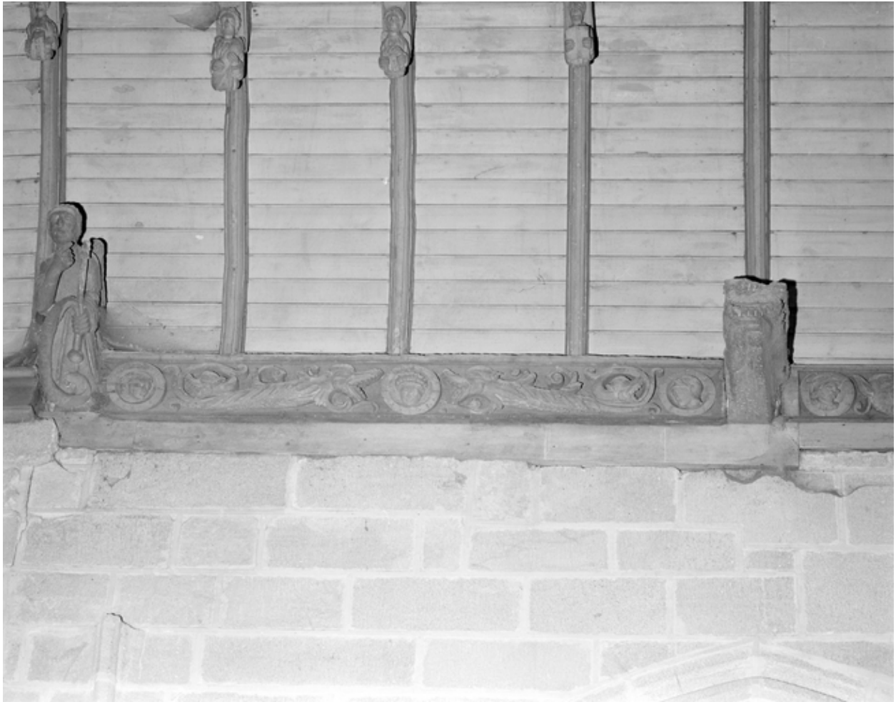
Sablière n°4, chœur, mur nord, partie gauche
