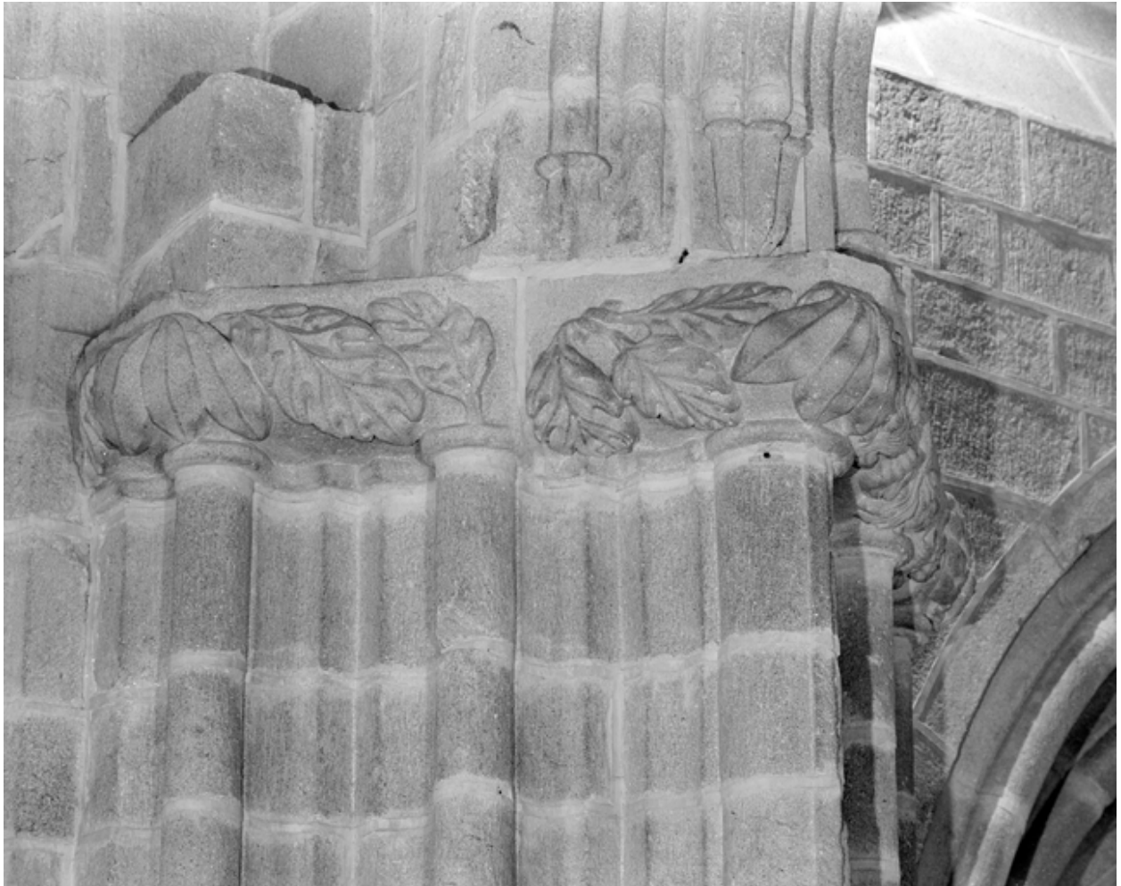
7e pile sud, face sud-est
