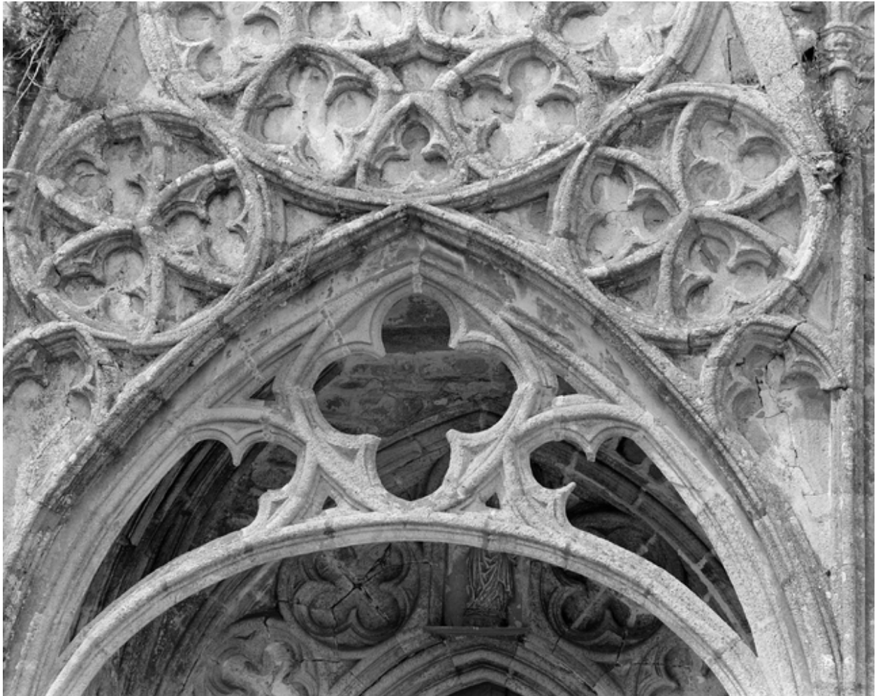
Porche sud, réseau
