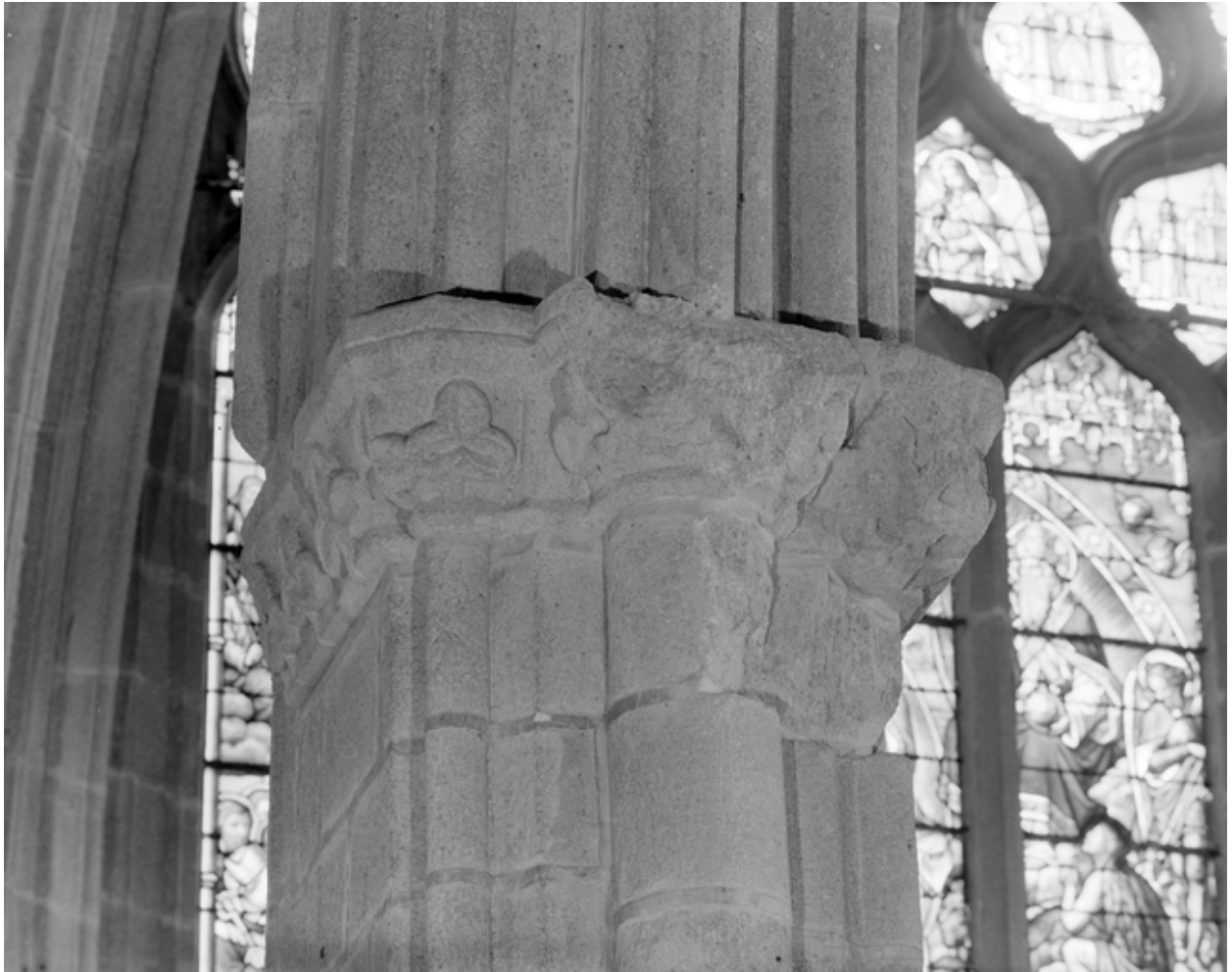
Choeur, partie est, dernière pile nord, chapiteau
