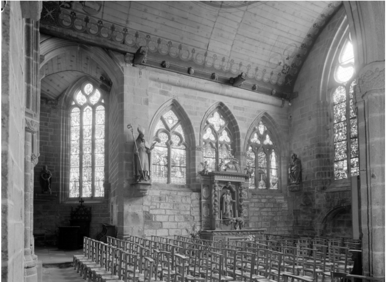
Chapelle sud du choeur, mur est
