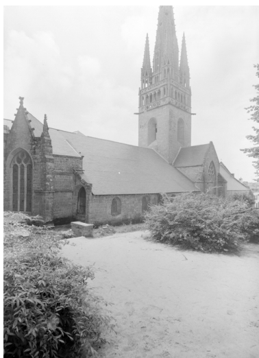
Vue générale nord-est Phot. Lanvéoc-Poulmic IVR53_19802900441V
