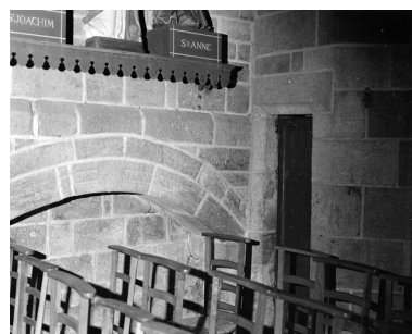
Choeur, partie est, bas-côté sud, enfeu Phot. Guy Artur, Phot. Norbert Lambart IVR53_19852900028X
