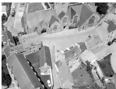
Vue aérienne, vue vers le sud Phot. Pascal Corbière IVR53_19842901360V
