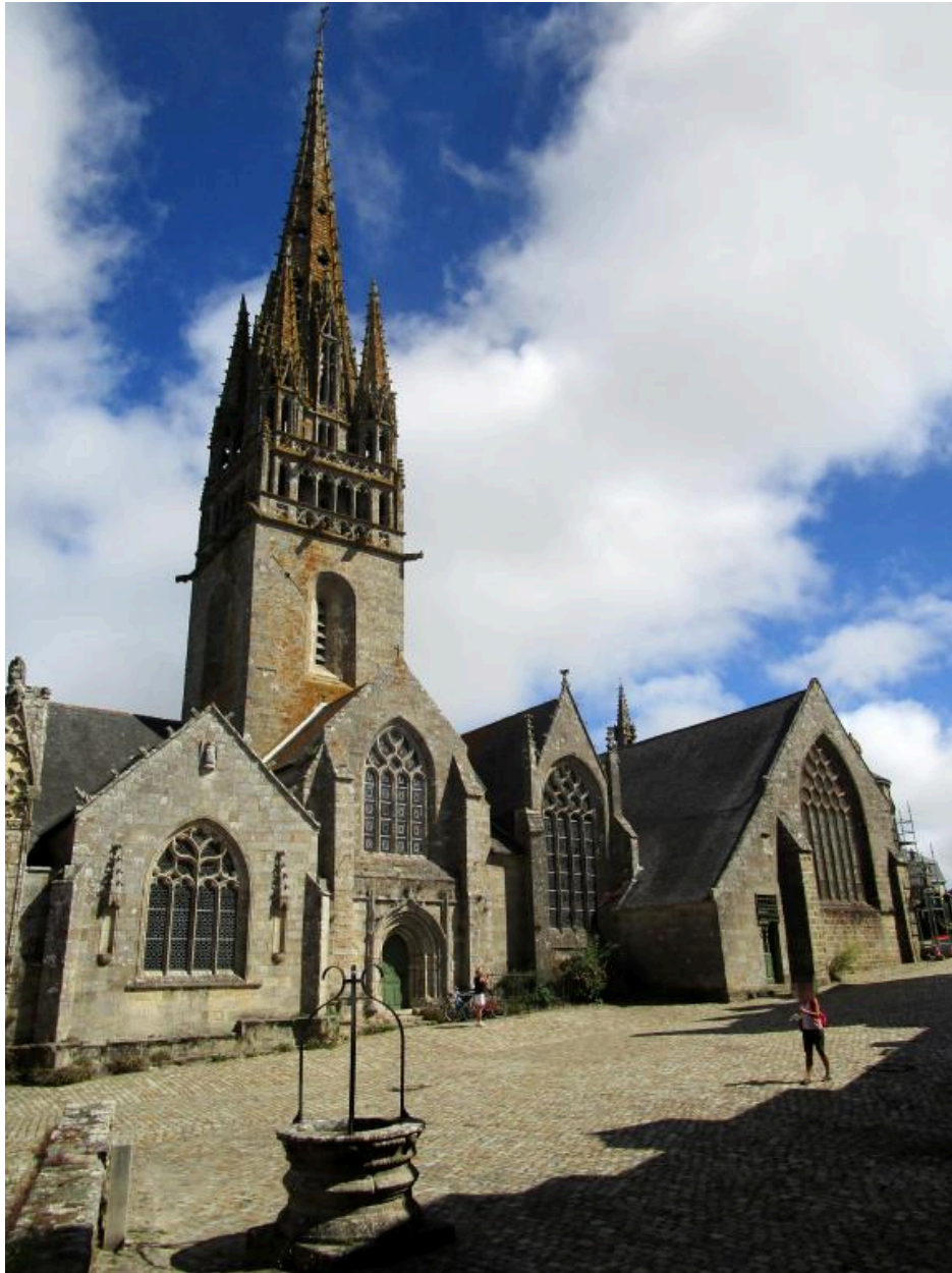
Elévation sud, partie médiane. (2022)
