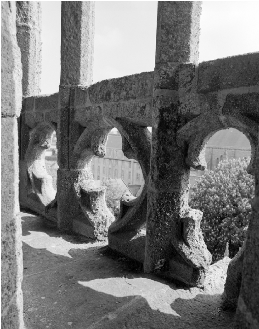
Détail de la balustrade trilobée
