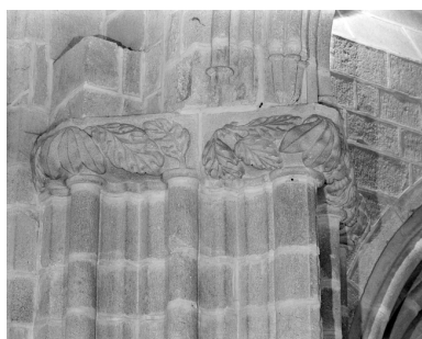
7e pile sud, face sud-est Phot. Guy Artur, Phot. Norbert Lambart IVR53_19852900040X
