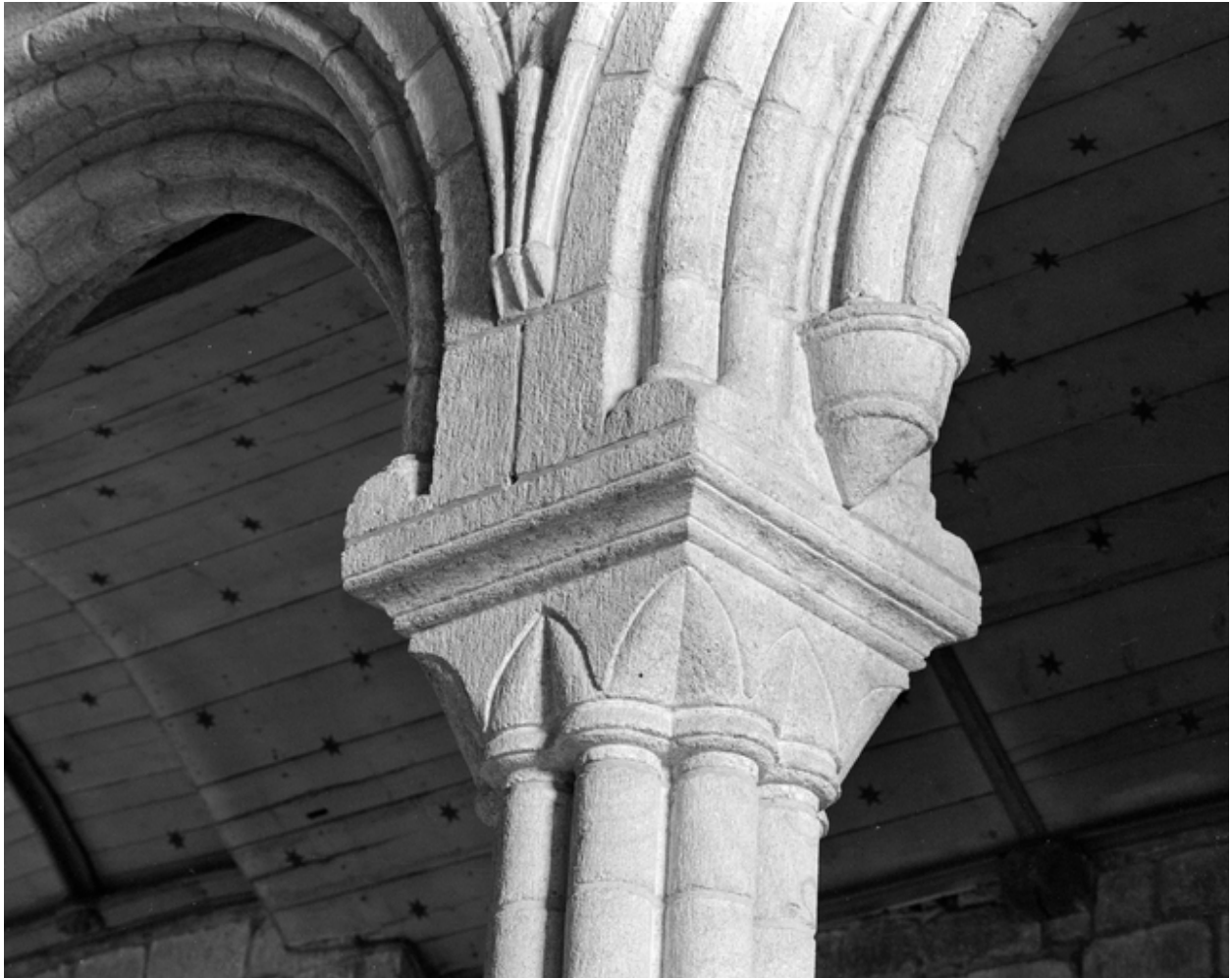
5e pile sud, vue nord-ouest
