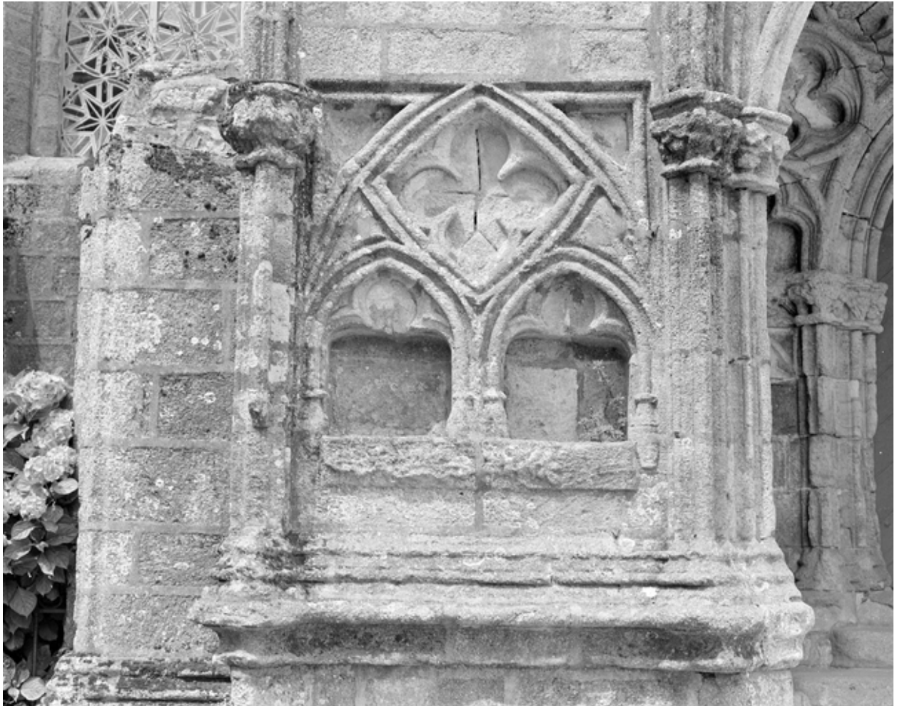
Porche sud, contrefort ouest, niche
