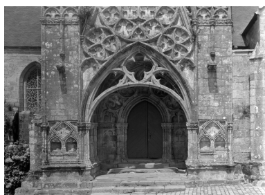
Porche sud, partie inférieure Phot. Marie Berthou, Phot. Marie-Madeleine Tugores IVR53_19802900437V
