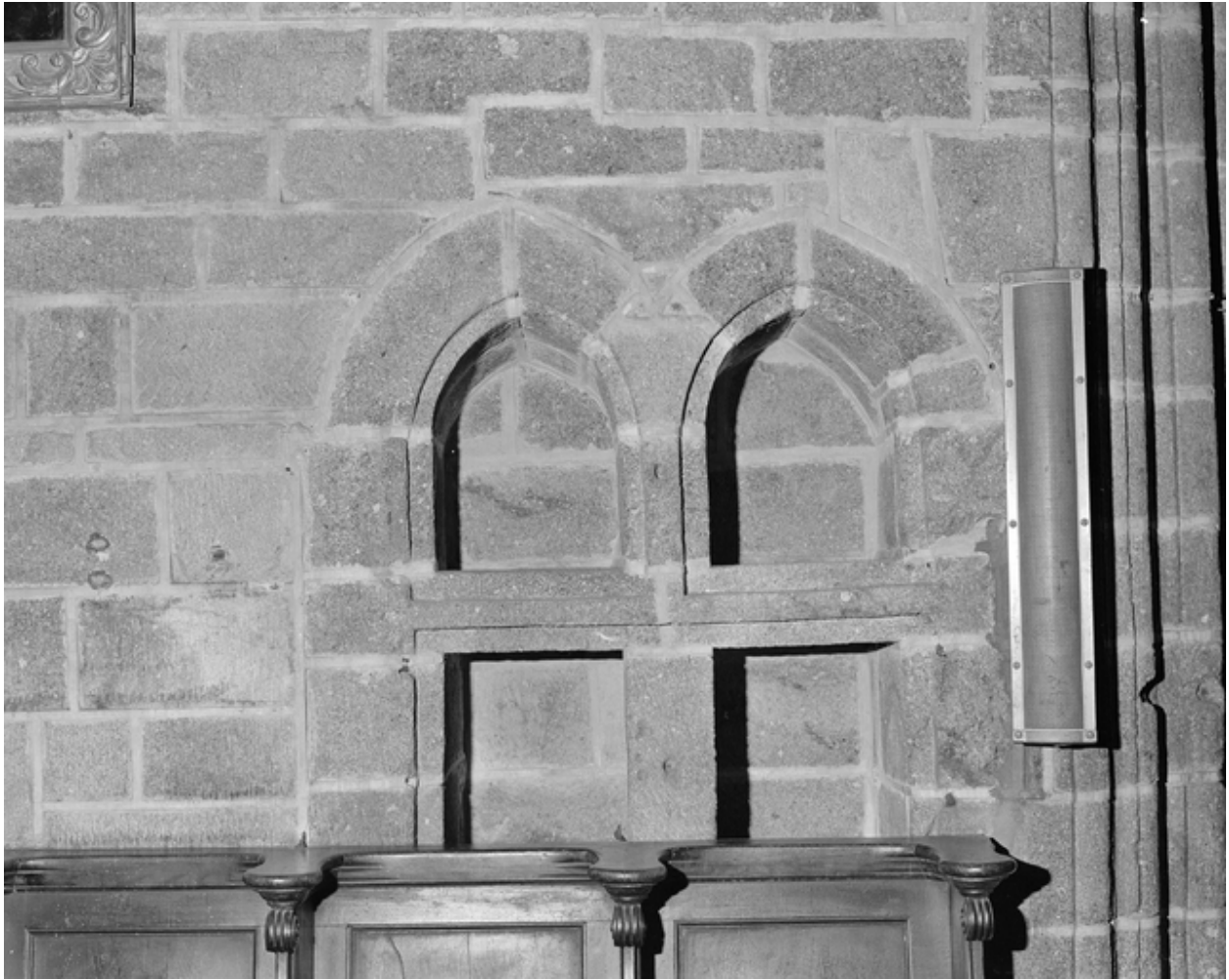
Chapelle sud du choeur, mur ouest, niche
