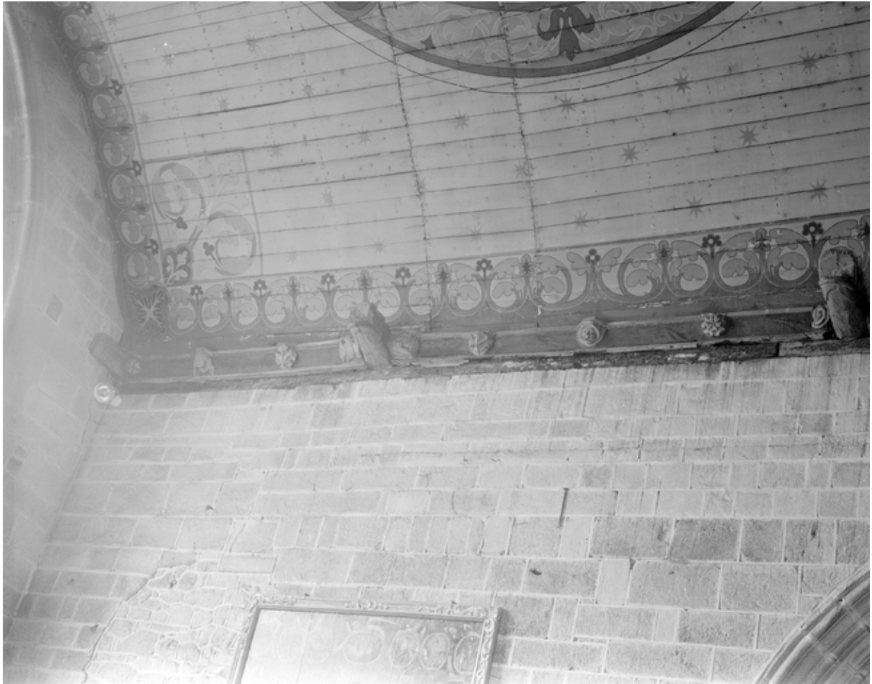
Sablère n°7, bras sud, mur ouest, partie gauche
