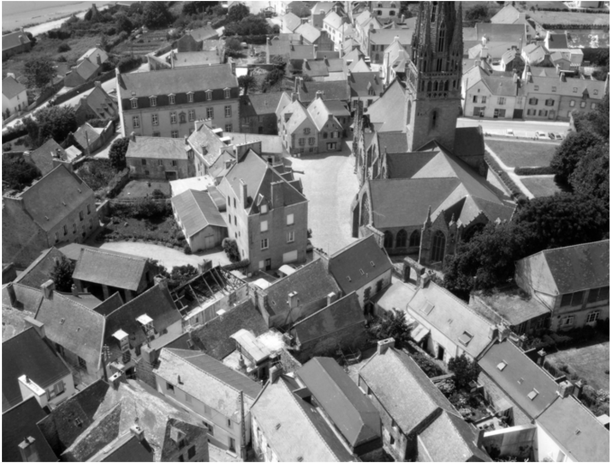
Vue aérienne, vue vers l'est
