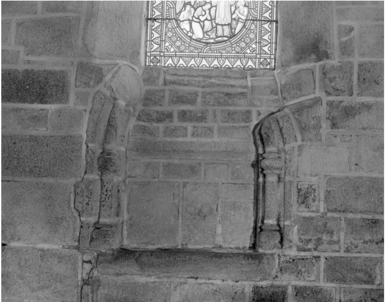
Choeur, bas-côté nord, niche
