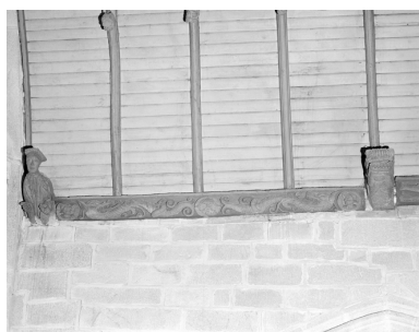
Sablère n°3, choeur, mur sud, partie gauche Phot. Guy Artur, Phot. Norbert Lambart IVR53_19832901186X
