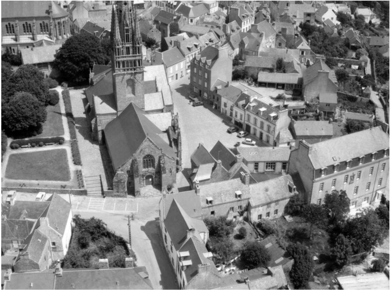
Vue aérienne, vue vers l'ouest
