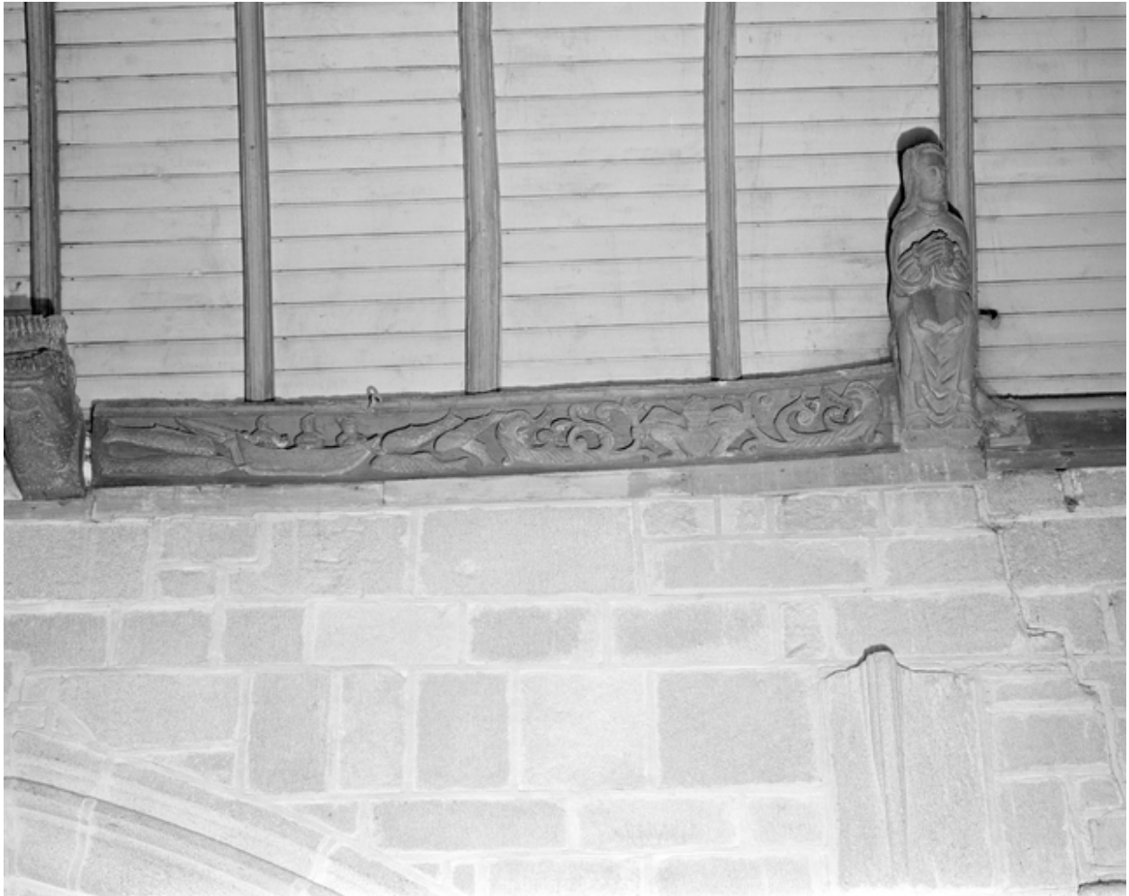
Sablère n°3, chœur, mur sud, partie droite
