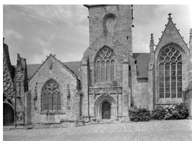
Elévation sud, partie médiane. (1980) Phot. Marie Berthou, Phot. Marie-Madeleine Tugores IVR53_19802900431V
