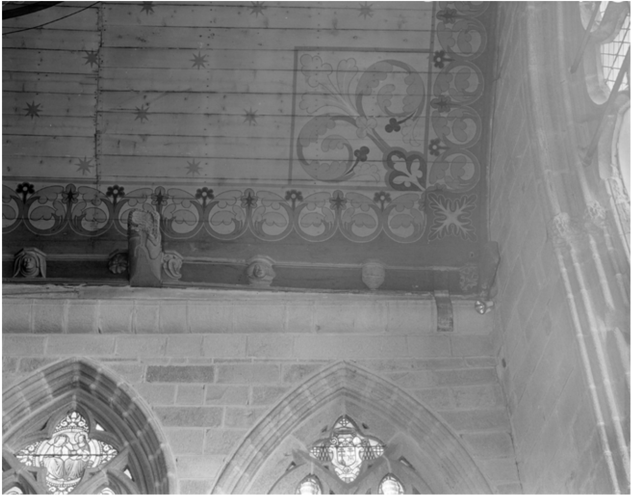
Sablère n°6, bras sud, mur est, partie droite
