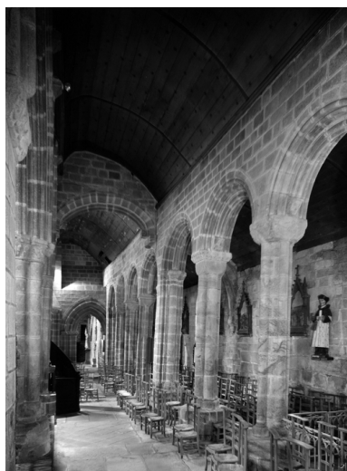
Choeur, premier collatéral nord, arcades nord Phot. Lanvéoc-Poulmic IVR53_19802900446V
