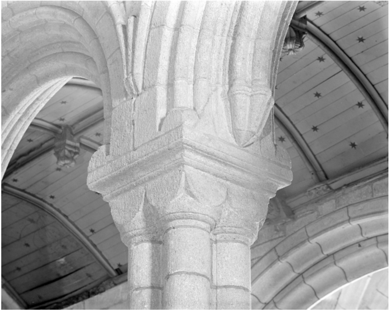
3e pile sud, vue nord-ouest
