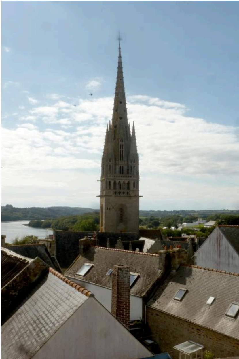
Clocher, vue générale prise de l'est.
