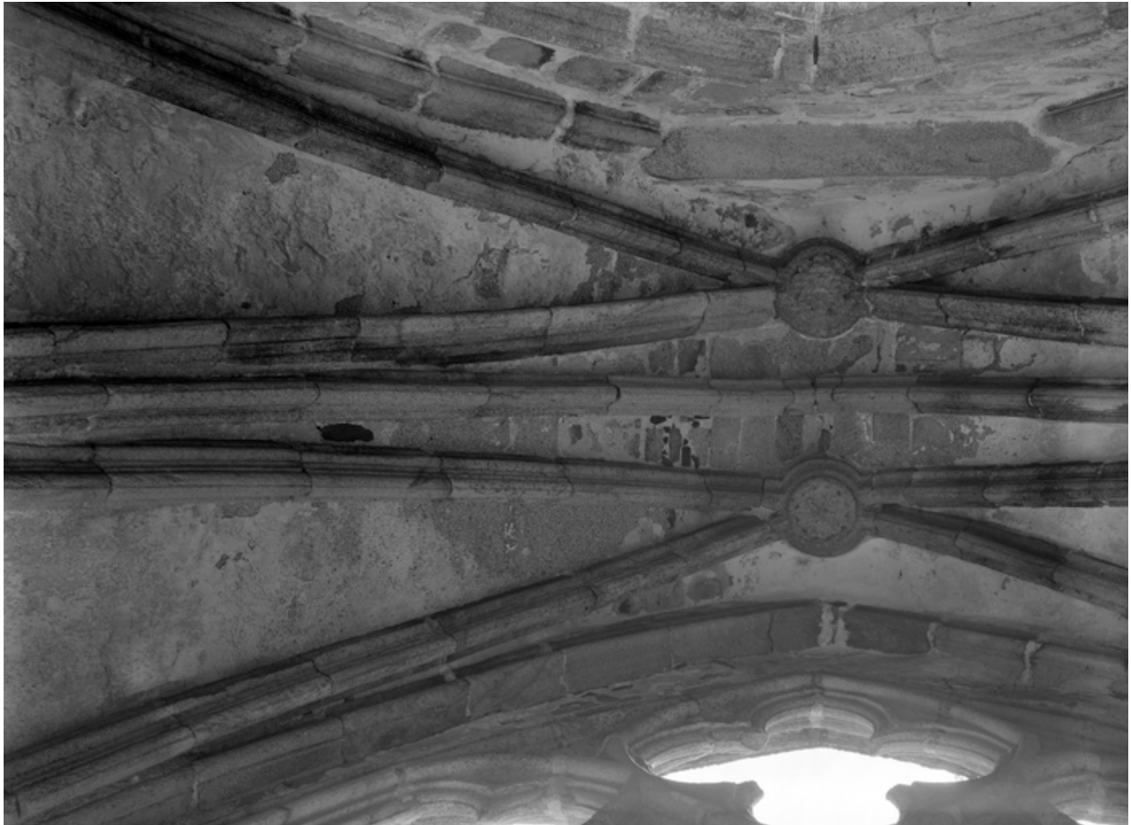
Porche sud, voûte
