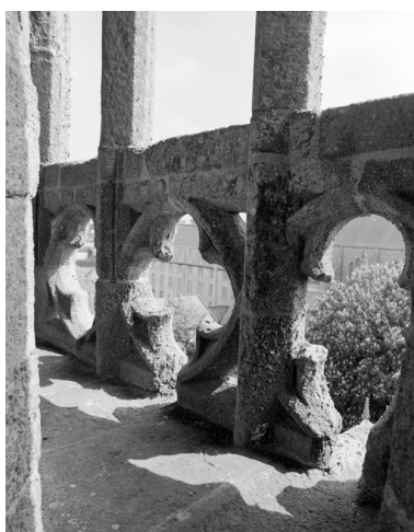
Détail de la balustrade trilobée Phot. Guy Artur, Phot. Norbert Lambart IVR53_19832901504X
