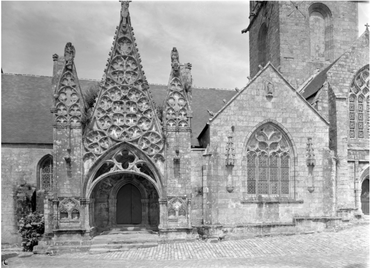
Porche sud et première chapelle sud
