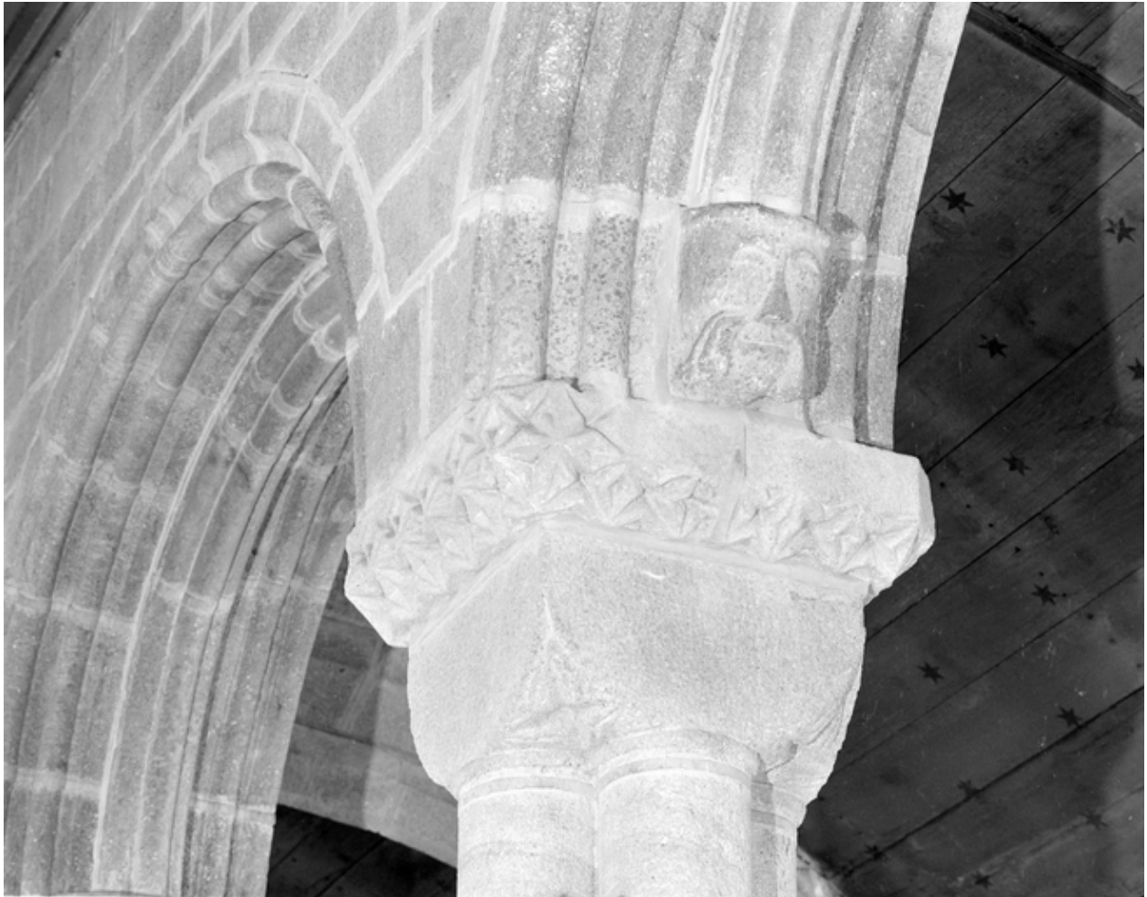
Arcades séparant les deux collatéraux nord, 4e pilier, chapiteau
