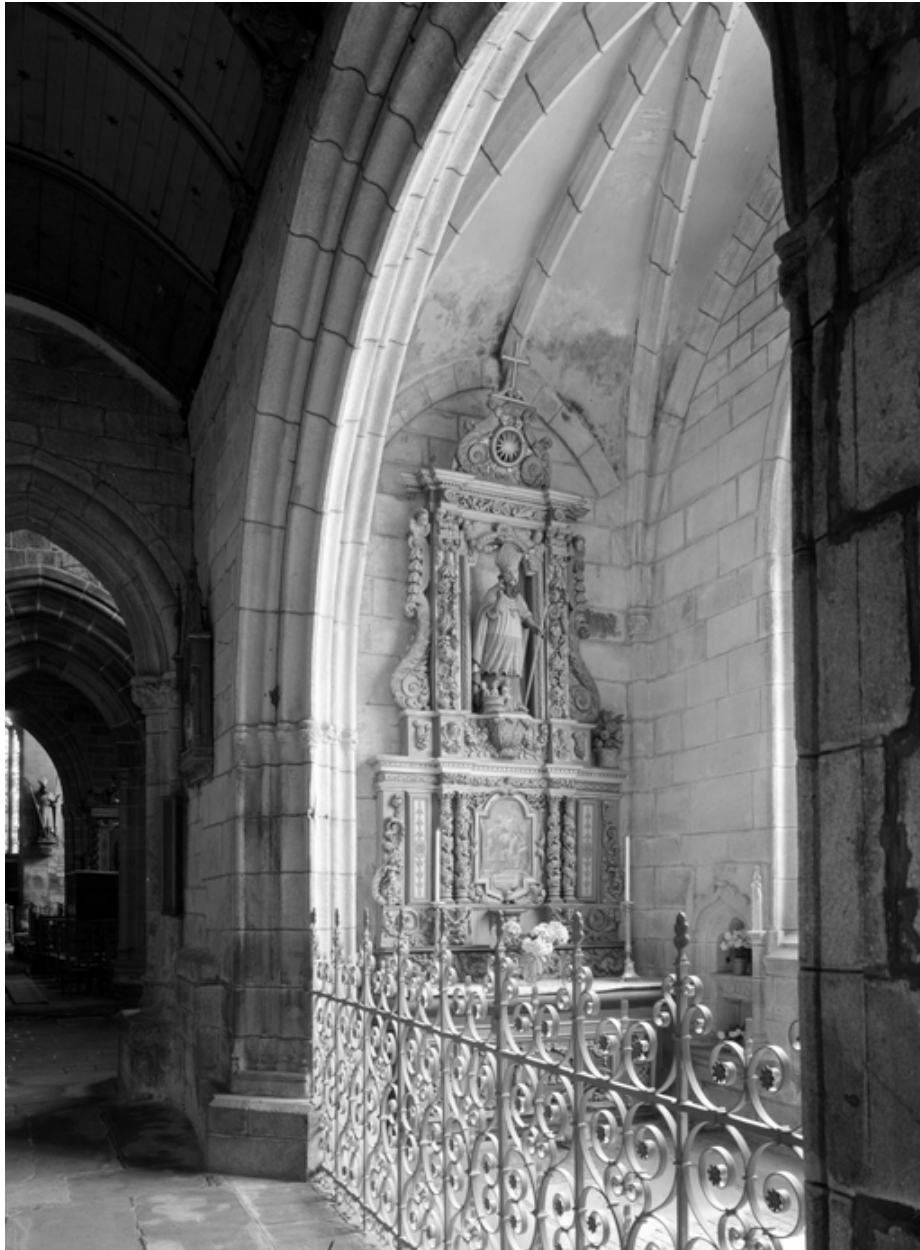
Nef, chapelle sud, vue est
