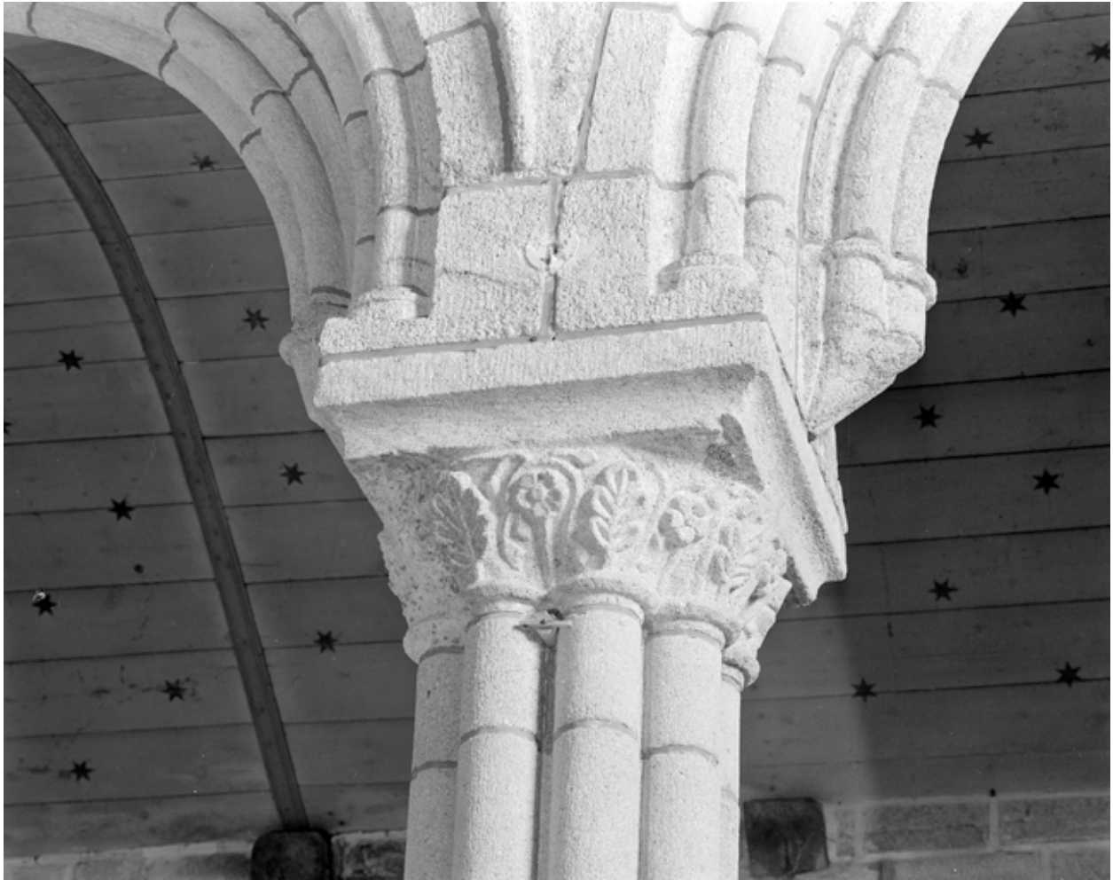
Choeur, partie ouest, 2e pile sud, détail chapiteau
