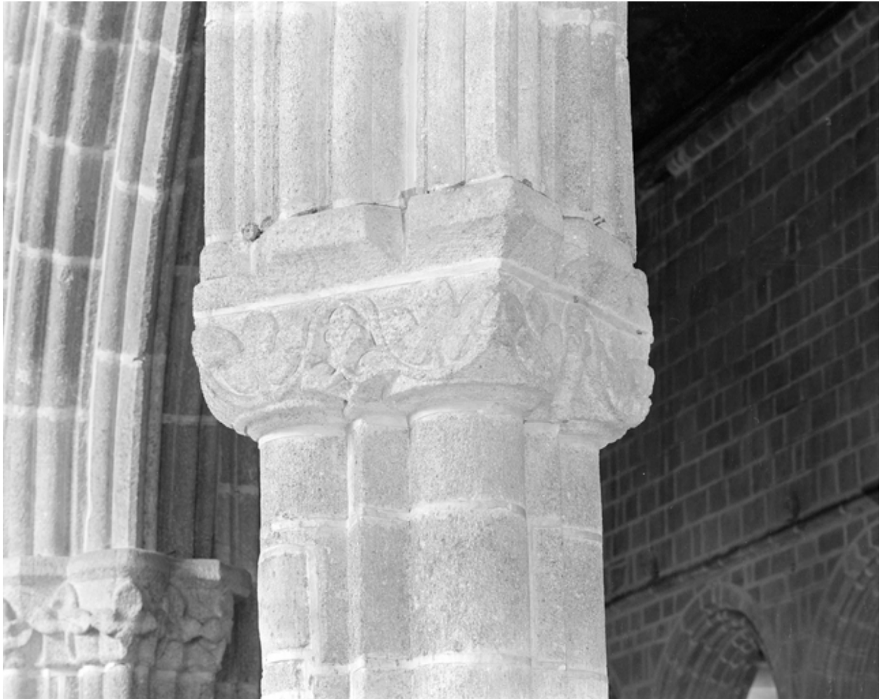
Choeur, partie est, 1ère pile sud, chapiteau
