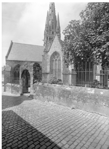
Choeur, vue générale sud-est Phot. Lanvéoc-Poulmic IVR53_19802900440V
