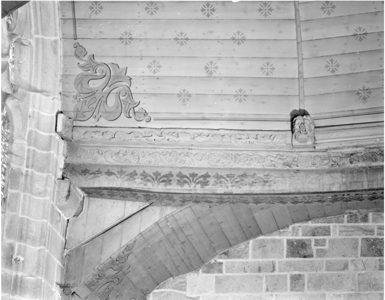
Sablère n°2, bas-côté sud, mur ouest, partie gauche
