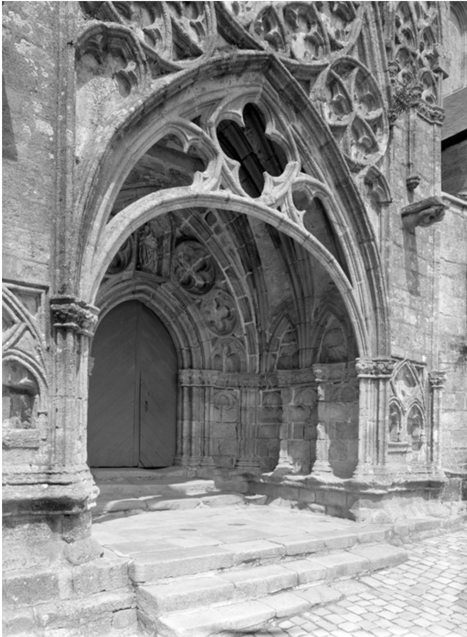
Porche sud, vue sud-ouest
