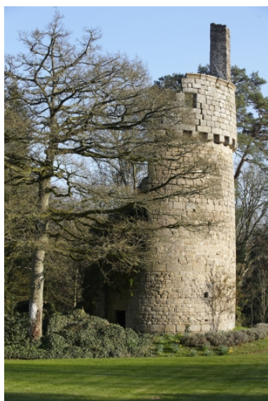
Le donjon vu depuis le nord-ouest. Phot. Rozenn Turni IVR53_20113500565NUCA
