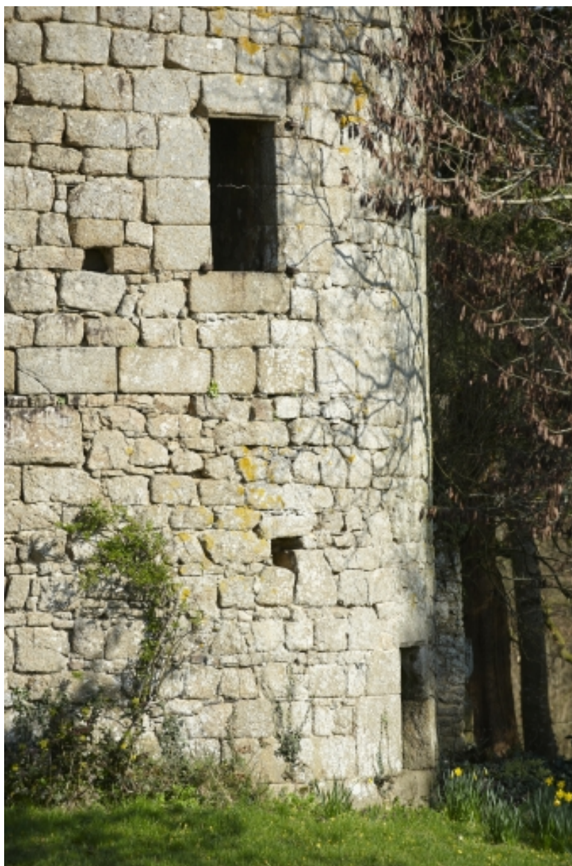
Donjon, fenêtres du rez-de-chaussée et de l'étage.
