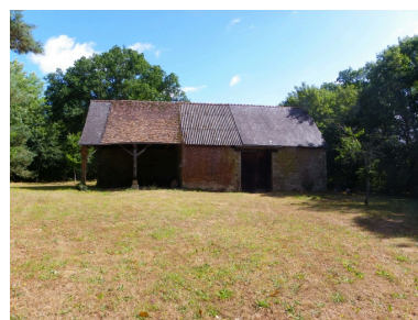
Grange isolée, façade ouest. Phot. Régis Le Bohec IVR53_20103510244NUCA
