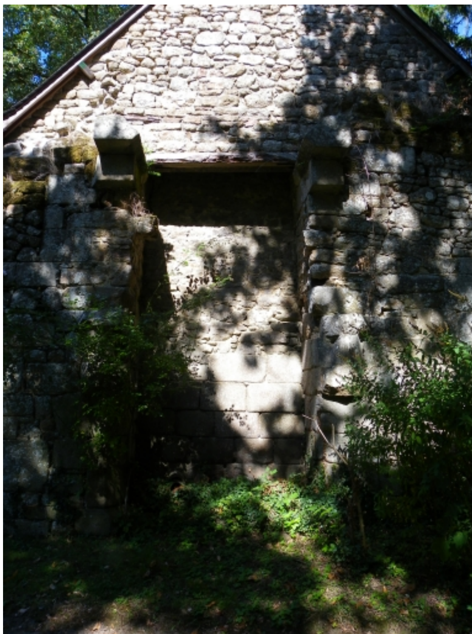
Chambre des Coëtlogon, ancienne cheminée.
