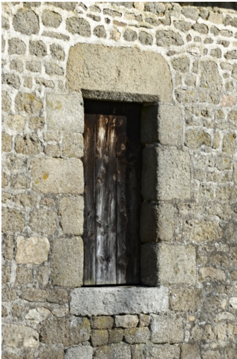
Métairie, fenêtre du rez-de-chaussée.
