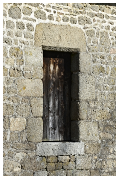
Métairie, fenêtre du rez-de-chaussée.
