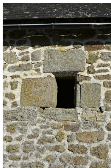
Métairie, fenêtre de l'étage.
