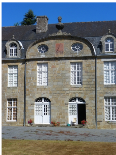
Travées centrales. Phot. Régis Le Bohec IVR53_20103510234NUCA
