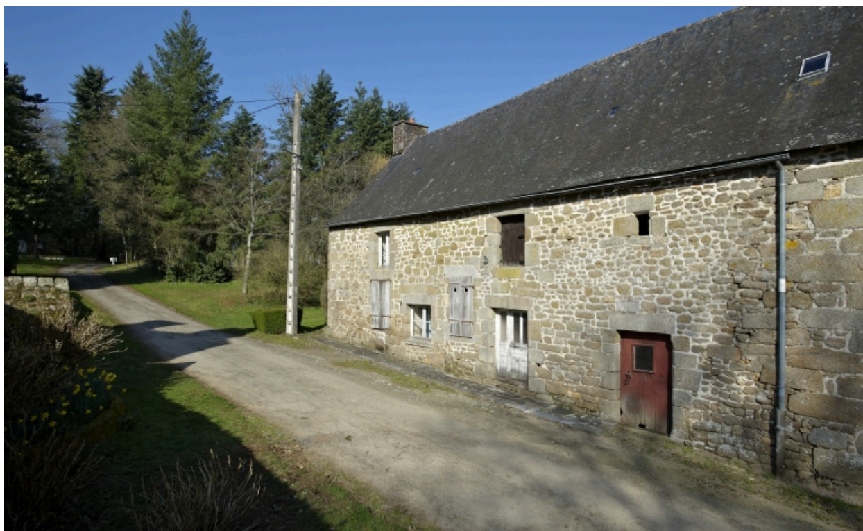
Métairie, façade sud du logis.
