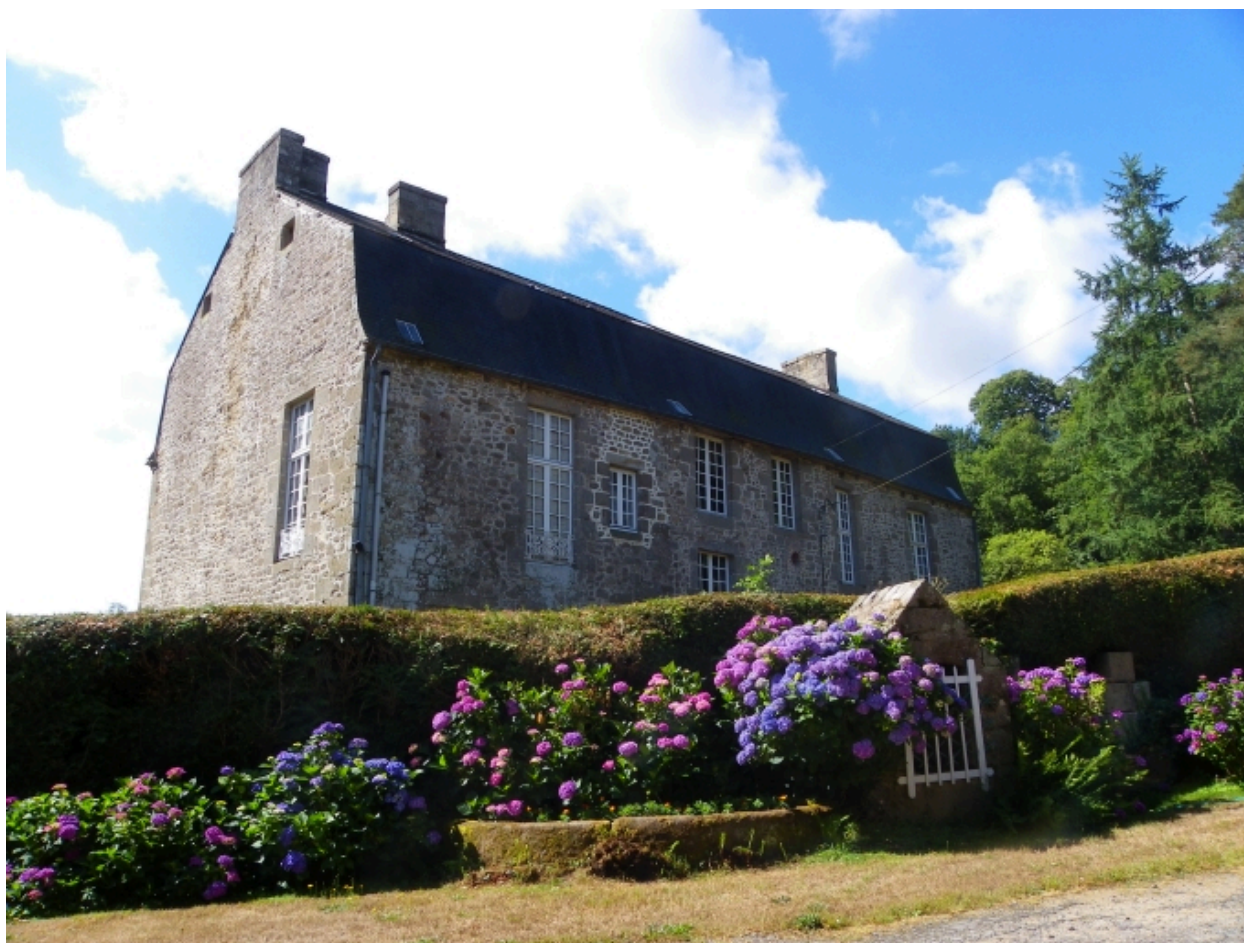
Façade nord du logis.
