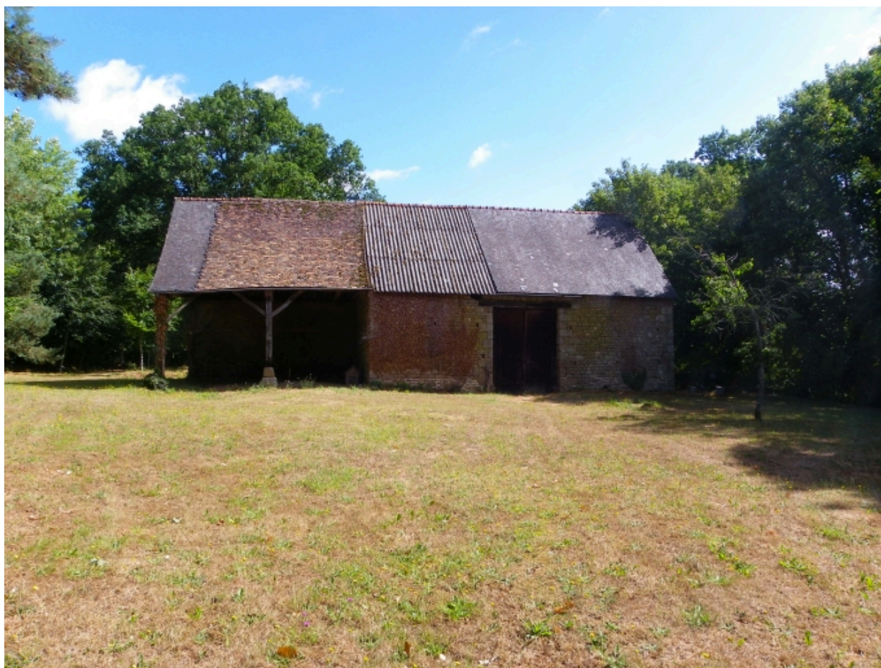
Grange isolée, façade ouest.
