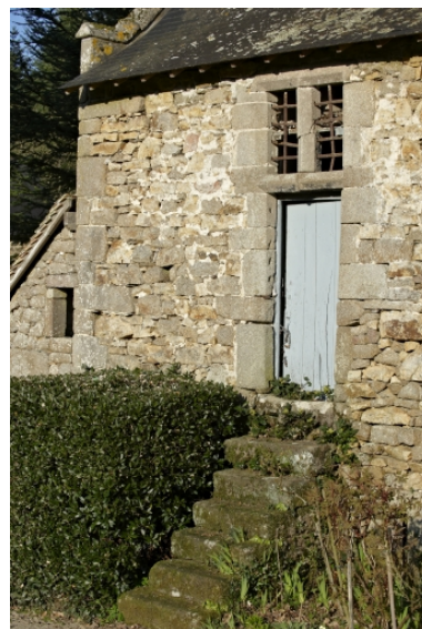
Chambre de Coëtlogon, façade ouest. Phot. Rozenn Turni IVR53_20113500549NUCA
