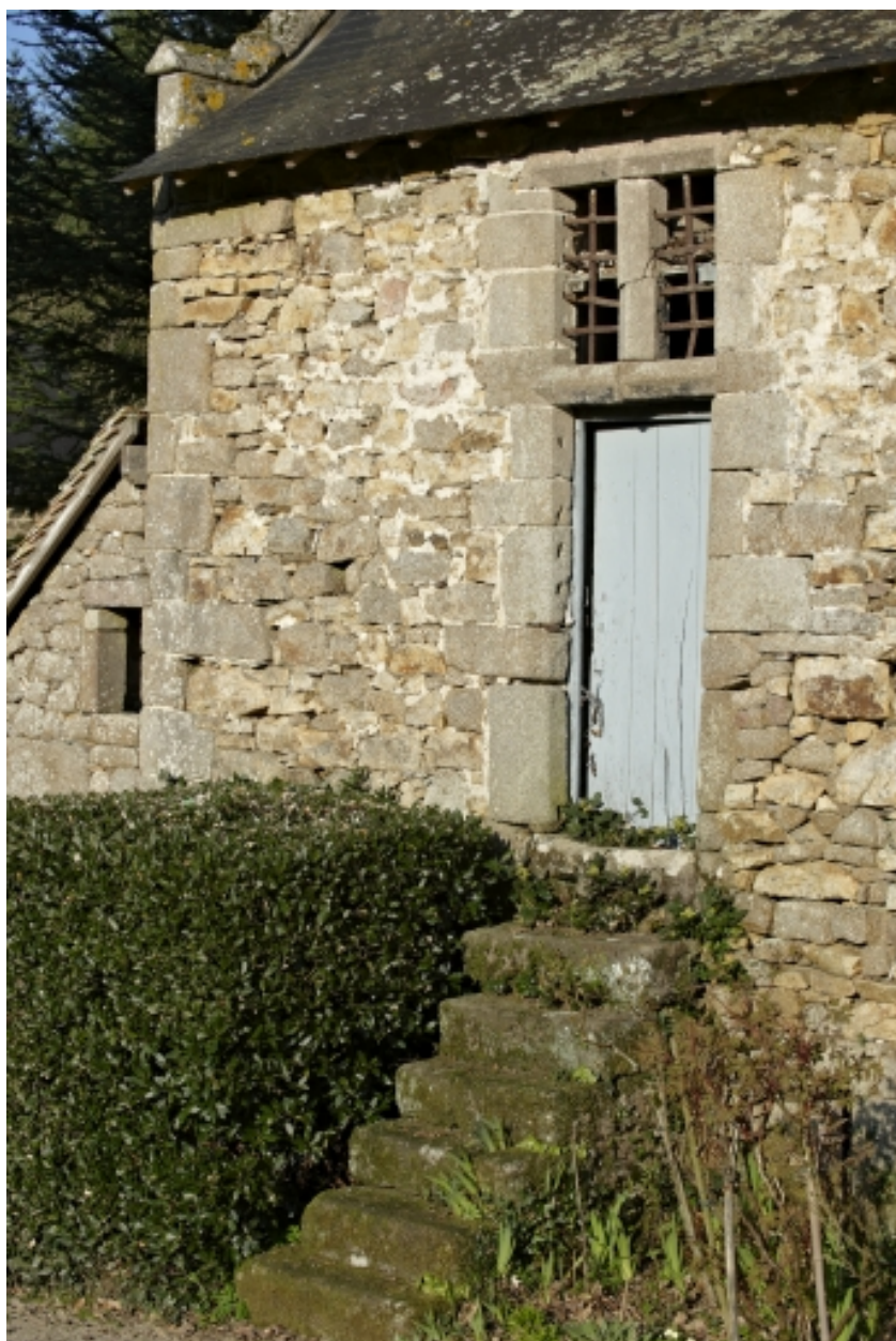
Chambre de Coëtlogon, façade ouest.
