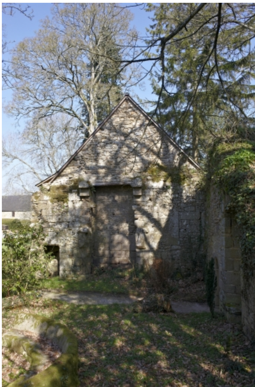
Chambre de Coëtlogon, ancienne cheminée sur le pignon sud.
