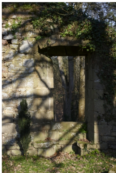
Chambre de Coëtlogon, fenêtre à coussièges. Phot. Rozenn Turni IVR53_20113500559NUCA
