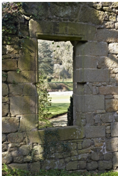
Chambre de Coëtlogon, ruines, fenêtre. Phot. Rozenn Turni IVR53_20113500556NUCA
