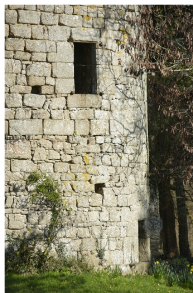
Donjon, fenêtres du rez- de-chaussée et de l'étage. Phot. Rozenn Turni IVR53_20113500564NUCA
