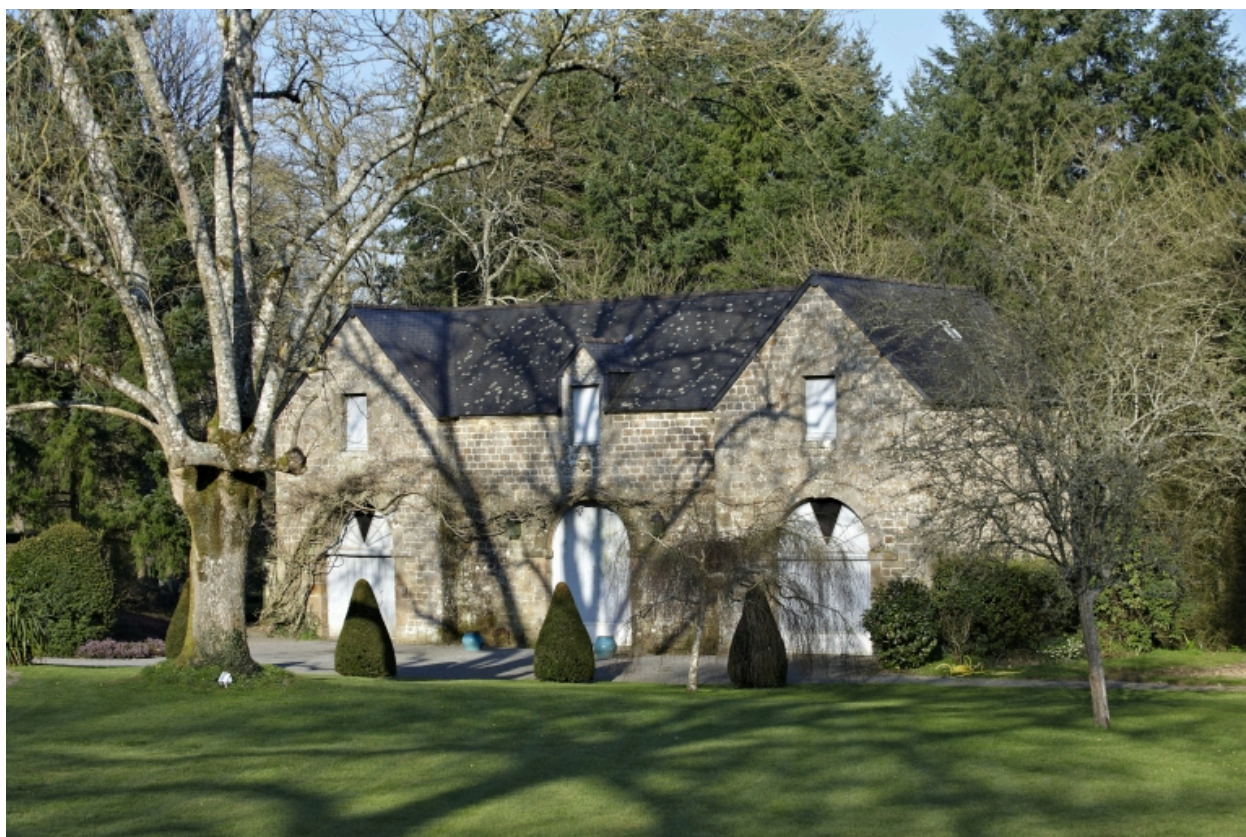
Ecurie vue depuis le sud-ouest.
