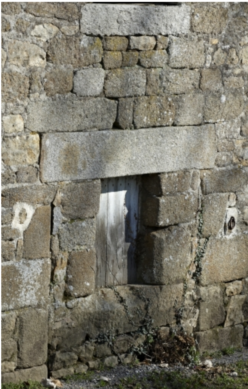
Métairie, porte transformée en fenêtre.
