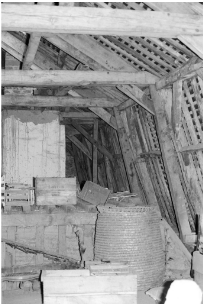
Combles et charpente du château.
