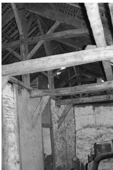
Charpente du château. Phot. Auteur inconnu IVR53_20103501240Z
