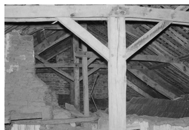
Charpente du château. Phot. Auteur inconnu IVR53_20103501241Z
