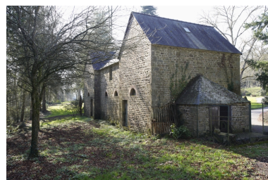
Chambre de Coëtlogon, façade postérieure. Phot. Rozenn Turni IVR53_20113500546NUCA
