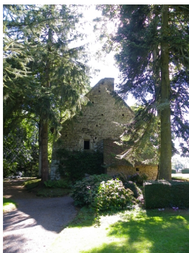
Chambre des Coëtlogon, façade nord. Phot. Régis Le Bohec IVR53_20103510248NUCA
