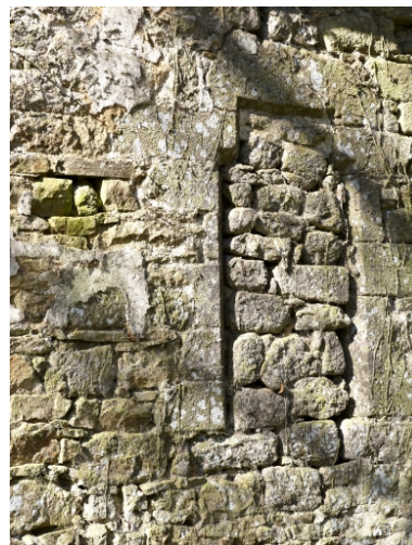
Chambre de Coëtlogon, ancienne fenêtre murée. Phot. Rozenn Turni IVR53_20113500558NUCA
