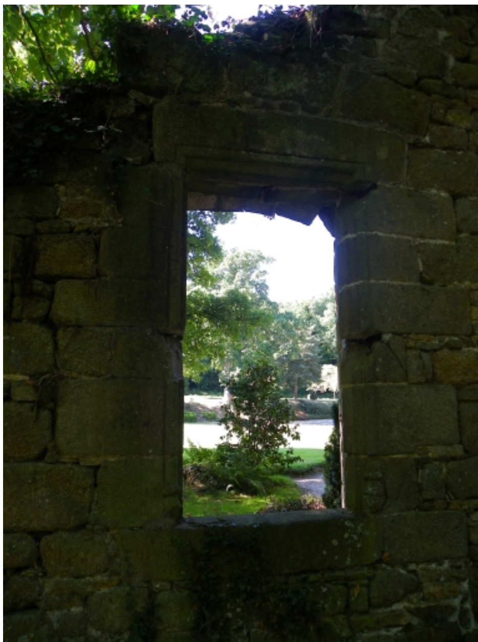
Chambre des Coëtlogon, ancienne fenêtre.
