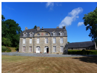
Façade sud. Phot. Régis Le Bohec IVR53_20103510233NUCA
