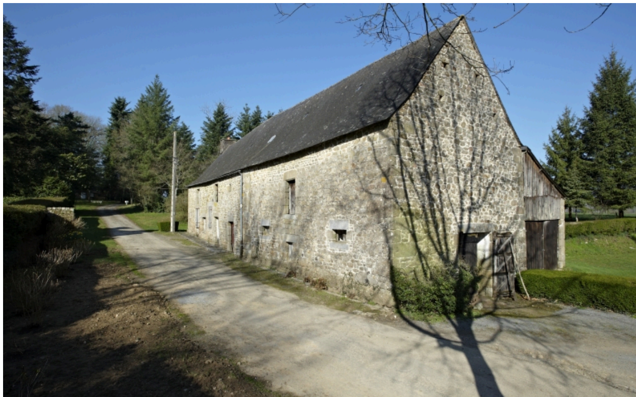
Métairie, façade sud.
