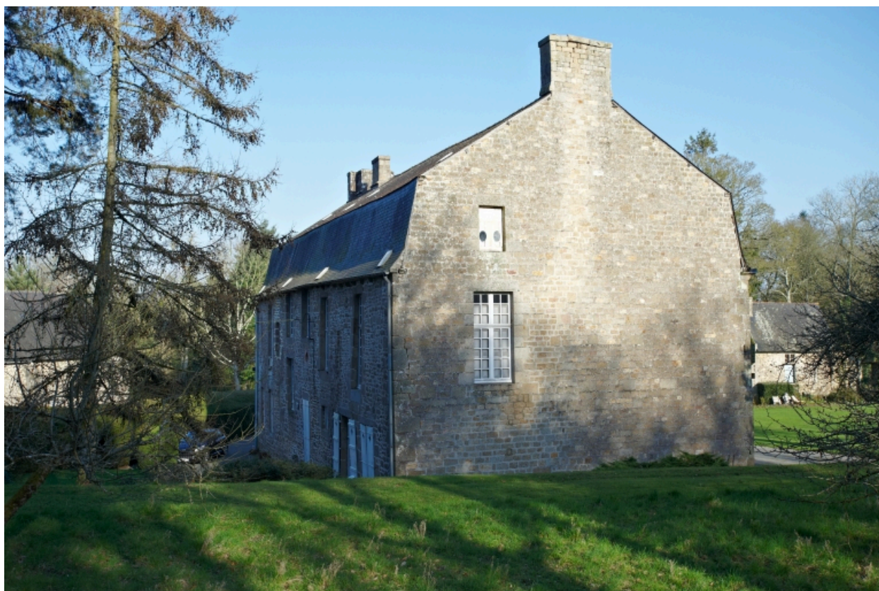
Château, façades nord et ouest.
