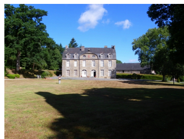
Vue générale. Phot. Régis Le Bohec IVR53_20103510232NUCA
