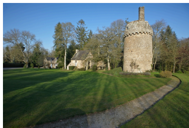
Vue d'ensemble des dépendances. Phot. Rozenn Turni IVR53_20113500568NUCA
