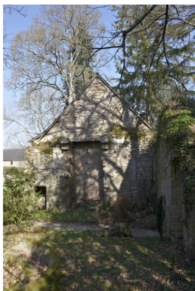
Chambre de Coëtlogon, ancienne cheminée sur le pignon sud. Phot. Rozenn Turni IVR53_20113500553NUCA
