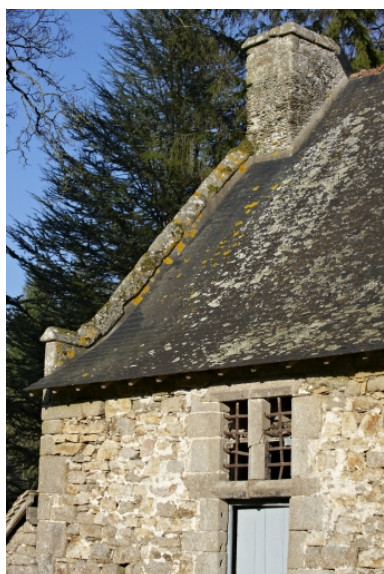
Chambre de Coëtlogon, détail du rampant nord. Phot. Rozenn Turni IVR53_20113500550NUCA
