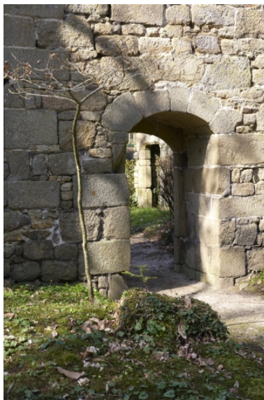
Chambre de Coëtlogon, porte de la façade est. Phot. Rozenn Turni IVR53_20113500557NUCA
