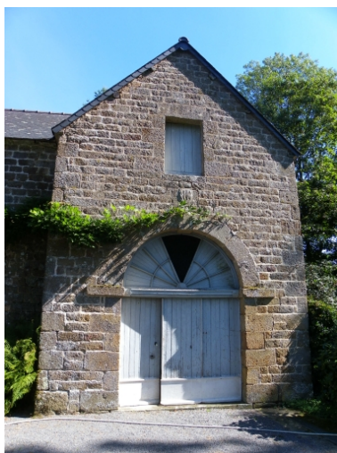
Pavillon du cocher, aile sud. Phot. Régis Le Bohec IVR53_20103510246NUCA
