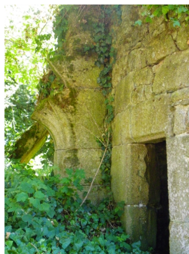
Ancienne baie trilobée. Phot. Régis Le Bohec IVR53_20103510229NUCA
