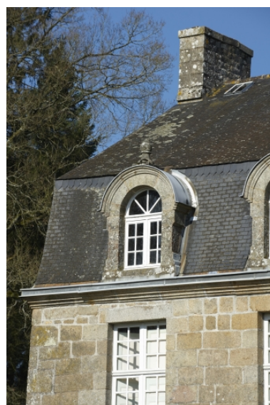
Lucarne du château. Phot. Rozenn Turni IVR53_20113500537NUCA
