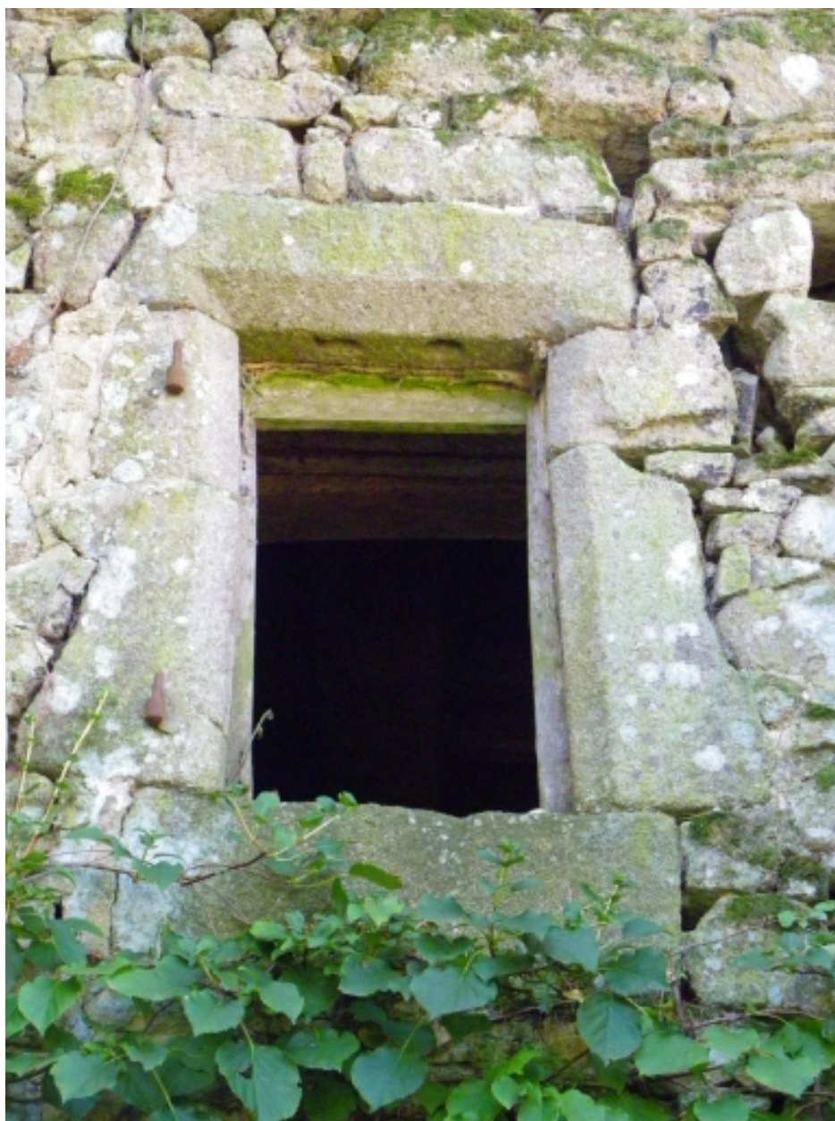
Chambre des Coëtlogon, fenêtre de l'étage.
