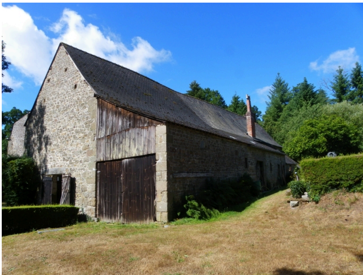
Métairie, façade postérieure.
