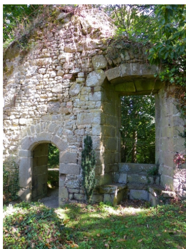
Chambre des Coëtlogon, anciennes porte et fenêtre, côté ouest. Phot. Régis Le Bohec
