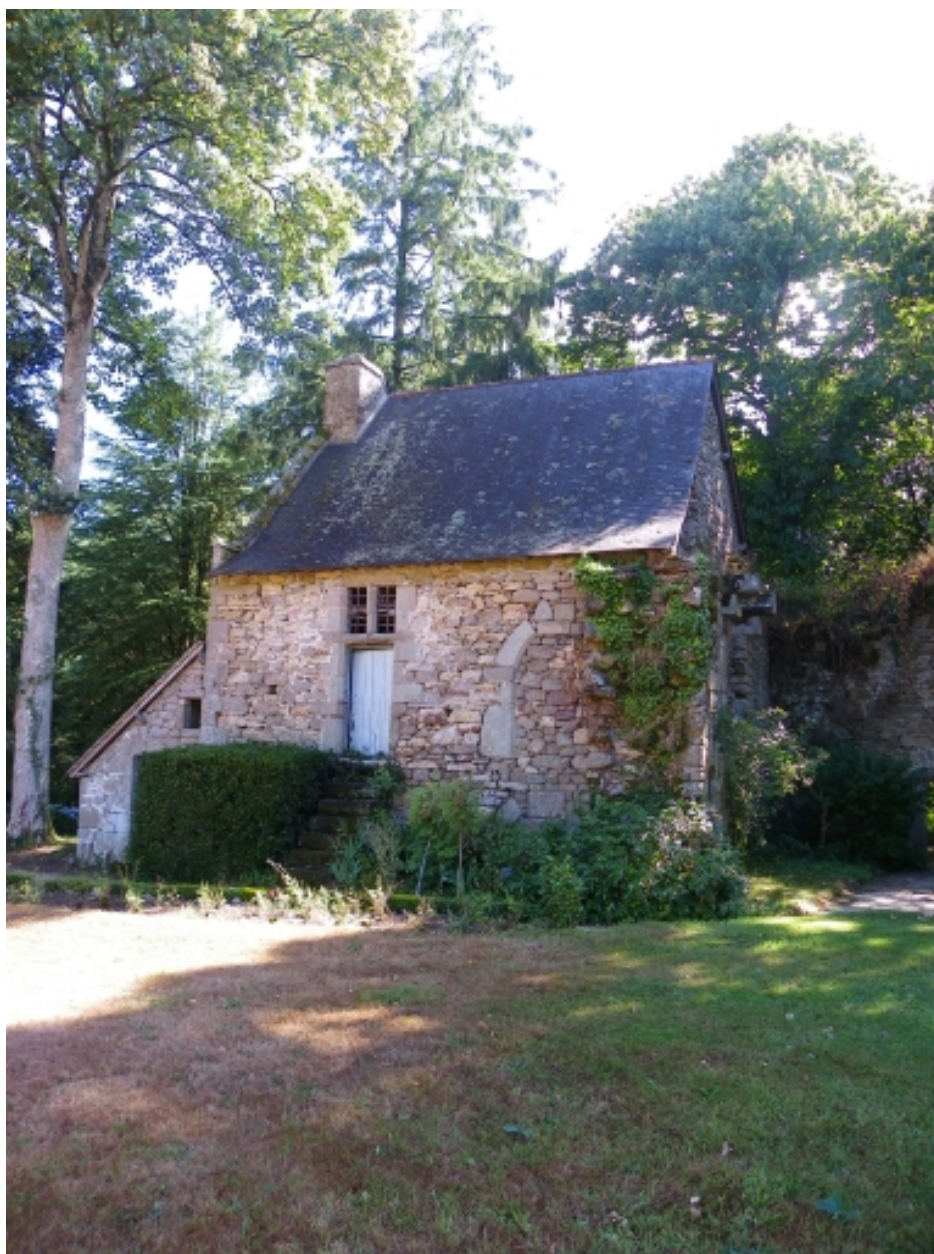
Chambre des Coëtlogon, façade ouest.
