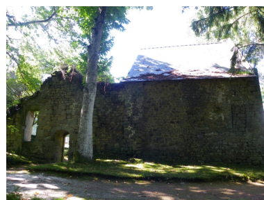
Chambre des Coëtlogon, façade est. Phot. Régis Le Bohec IVR53_20103510250NUCA
