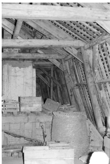
Comble et charpente du château. Phot. Auteur inconnu IVR53_20103501239Z
