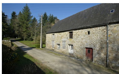
Métairie, façade sud du logis.
