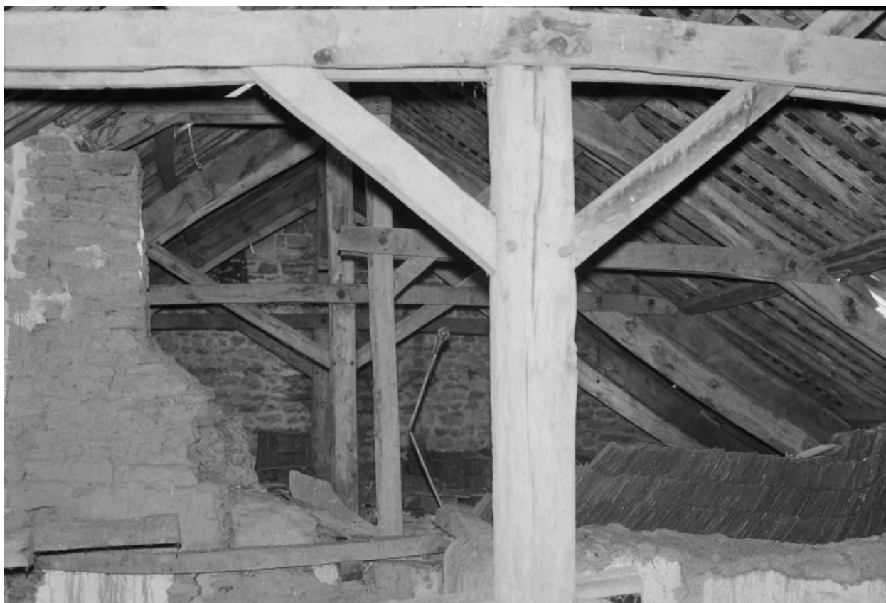
Charpente du château.
