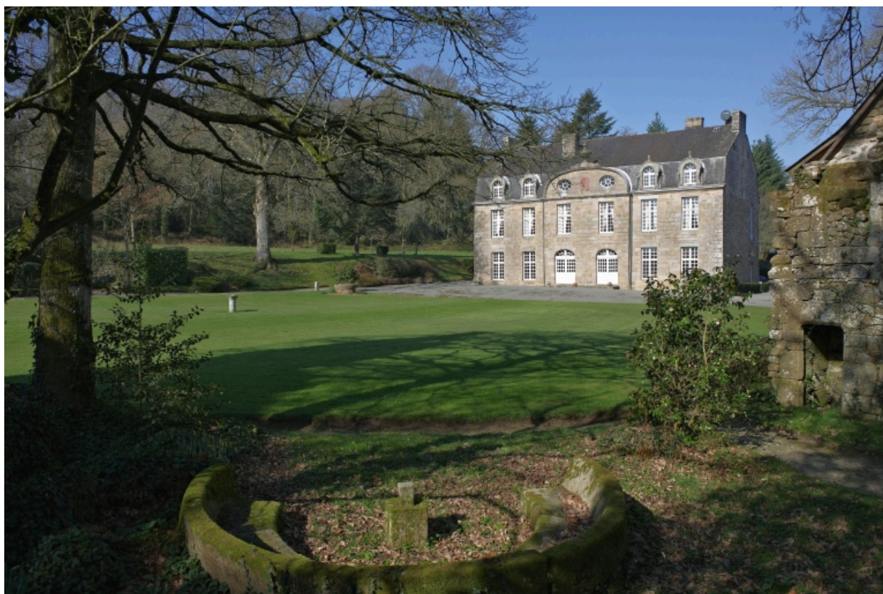
Vue du château depuis le sud-est.
