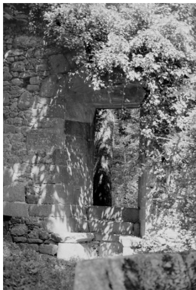
Baie à coussiège d'un ancien logis. Phot. Auteur inconnu IVR53_20103501236Z
