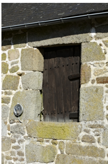
Métairie, fenêtre de l'étage.
