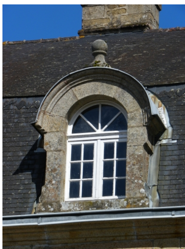
Lucarne, façade sud. Phot. Régis Le Bohec IVR53_20103510237NUCA
