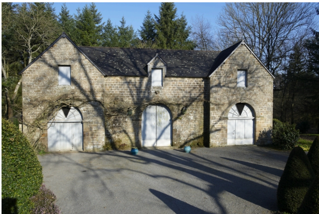
Ecurie, façade ouest.
