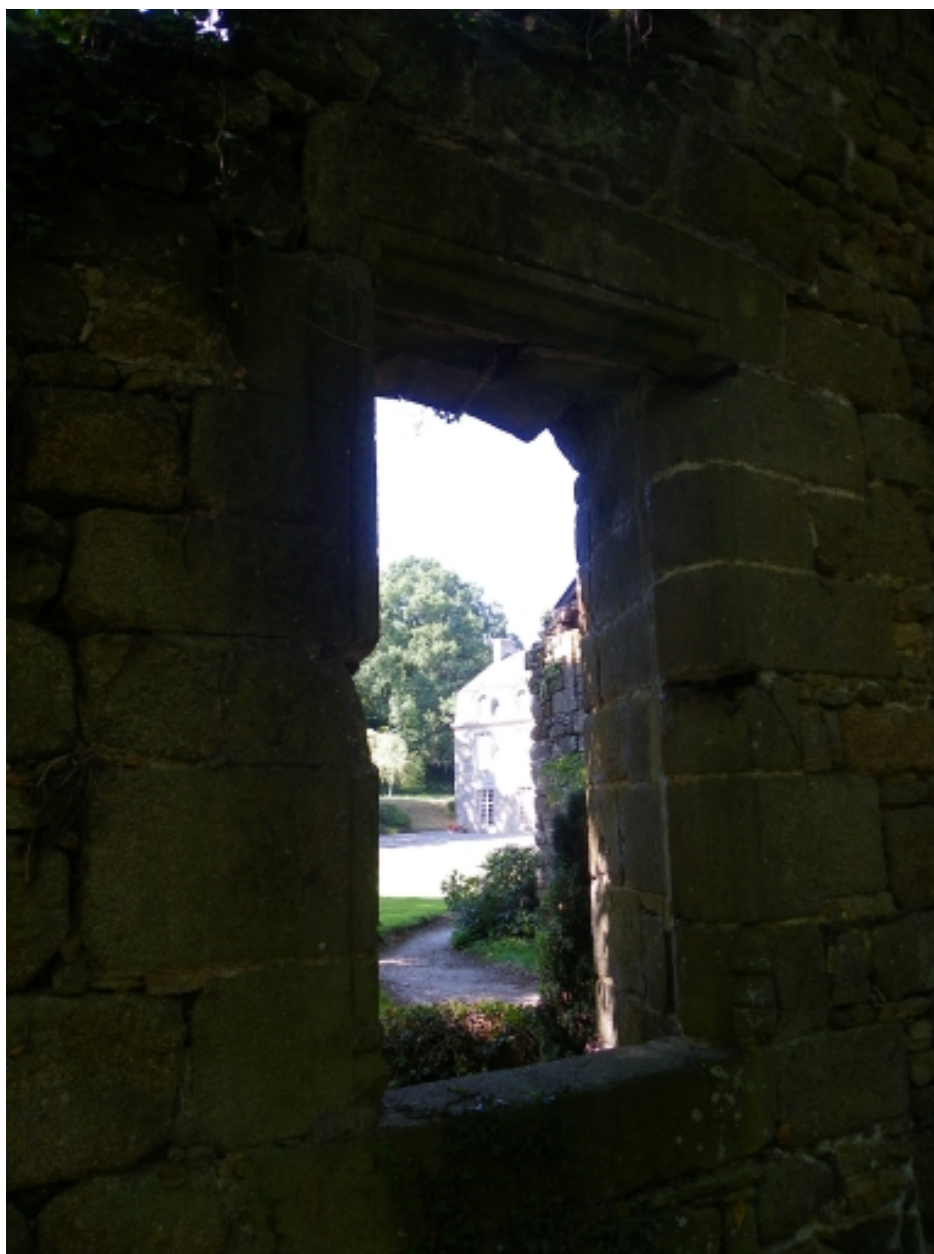
Chambre des Coëtlogon, ancienne fenêtre.
