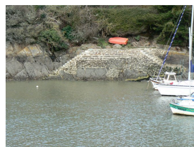
Vue générale de l'appontement pour accéder au feu amont Phot. Julien Amghar IVR53_20082908582NUCA
