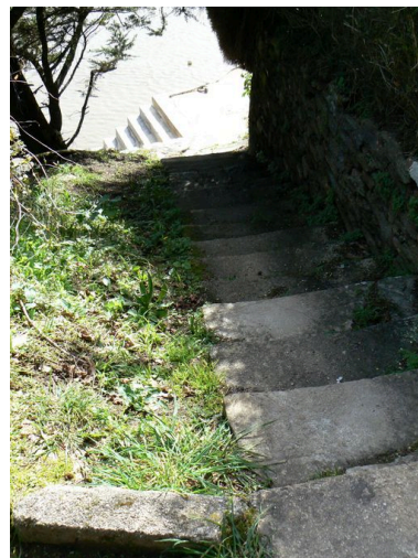
Escalier menant de la maison du gardien à l'appontement Phot. Julien Amghar IVR53_20082908585NUCA
