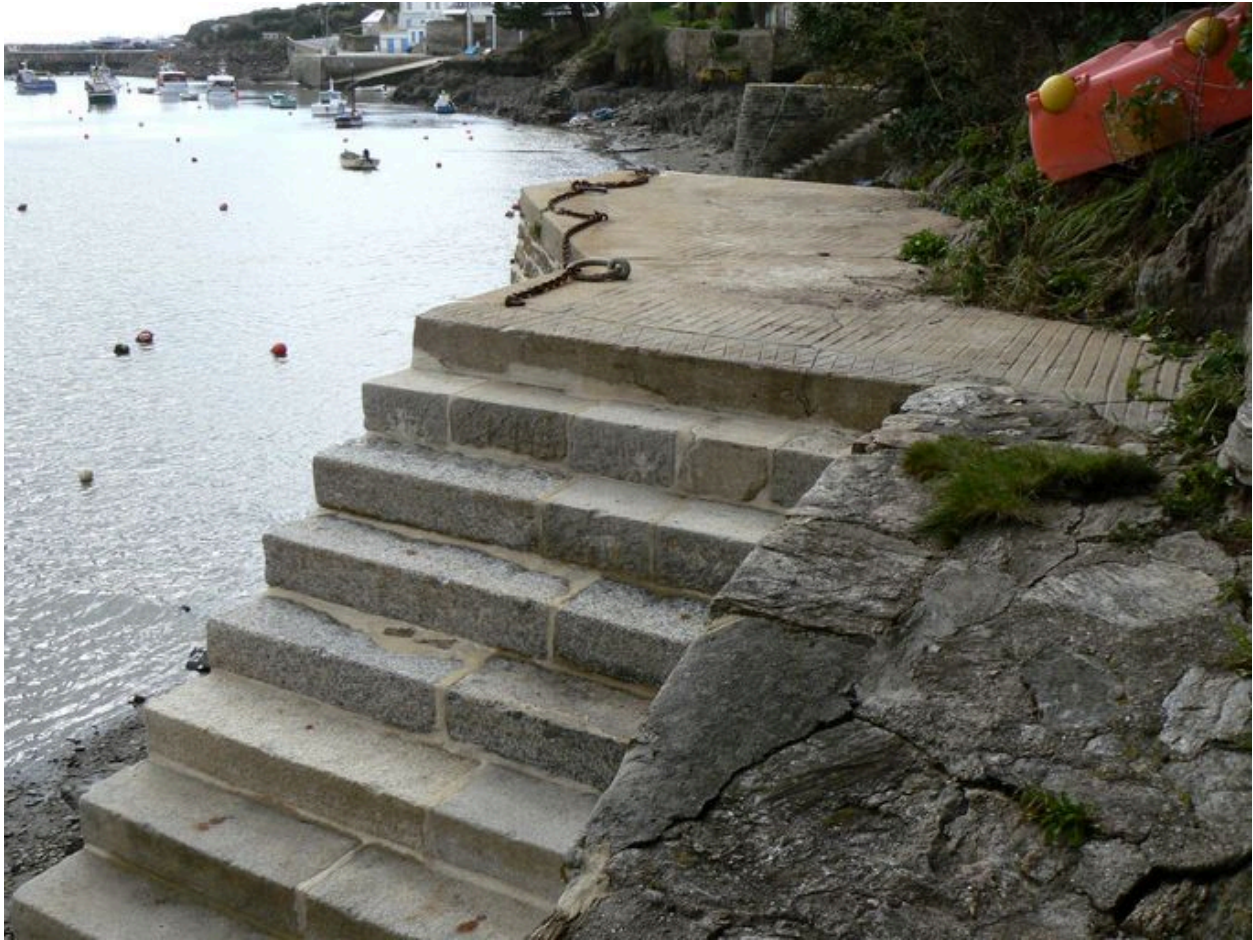
Partie supérieure de l'appontement
