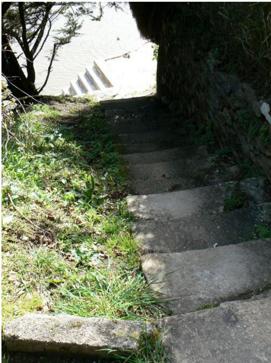
Escalier menant de la maison du gardien à l'appontement
