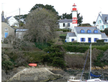
Vue d'ensemble du feu amont et de son appontement Phot. Julien Amghar IVR53_20082908581NUCA
