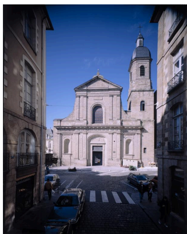
Elévation Ouest : vue générale. Phot. Guy Artur IVR53_19953500210VA
