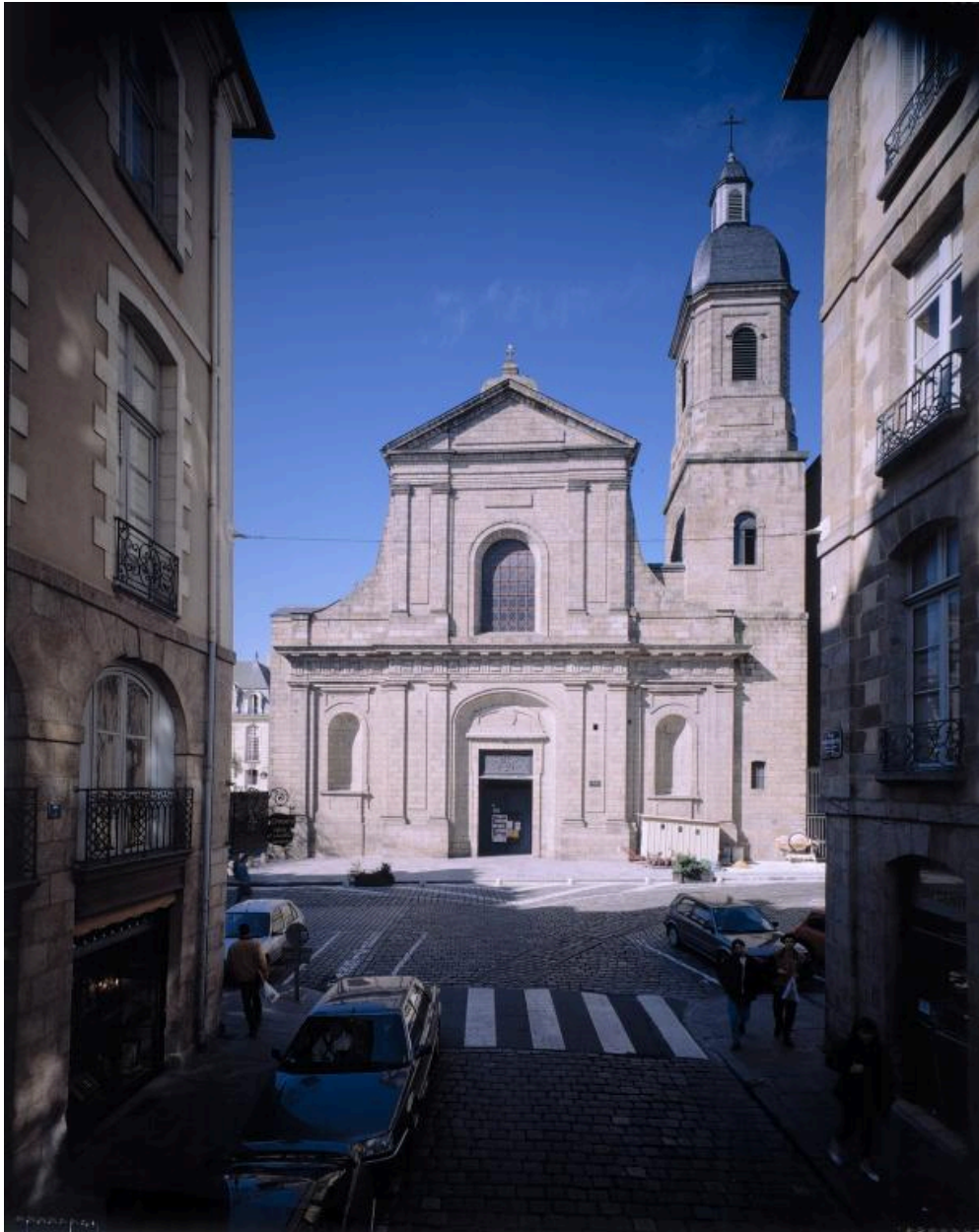
Elévation Ouest : vue générale.
