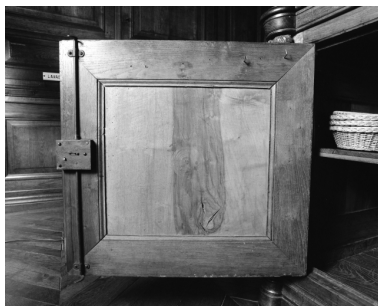
Sacristie - Détail du revers d'un panneau. Phot. Auteur inconnu IVR53_19923500730X
