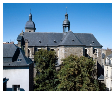
Elévation latérale : vue générale depuis l'hôtel de Blossac Phot. Guy Artur, Phot. Norbert Lambart IVR53_19893500328XA
