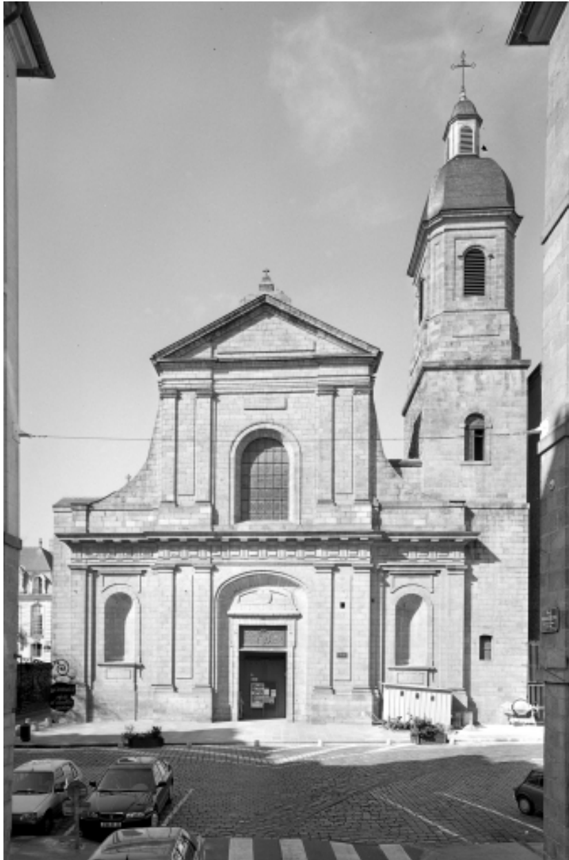
Elévation ouest : vue générale.
