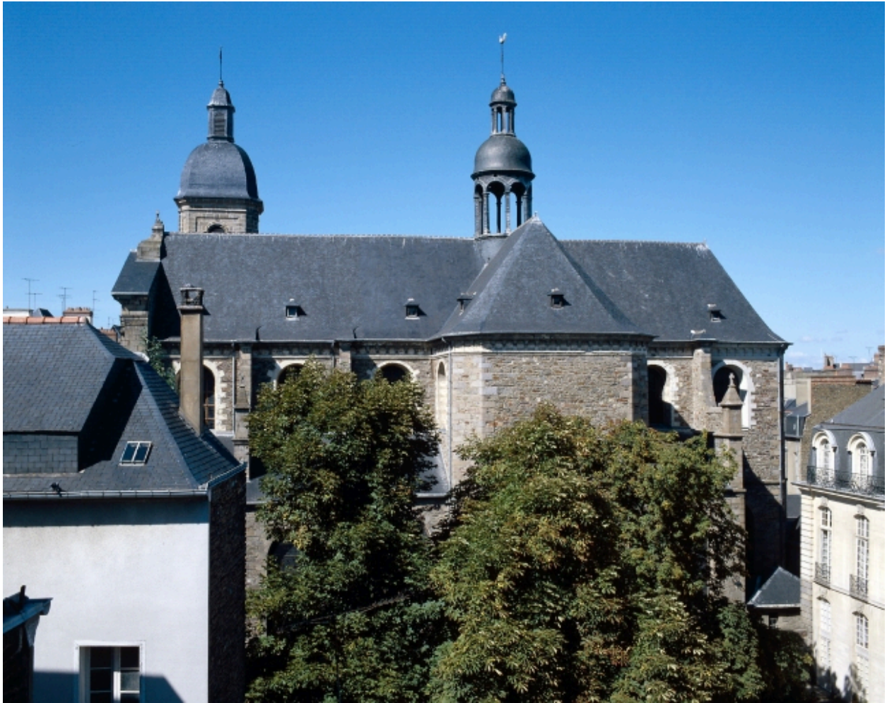
Elévation latérale : vue générale depuis l'hôtel de Blossac
