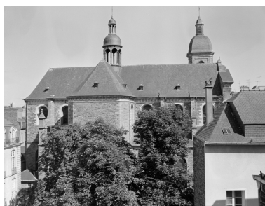
Elévation latérale : vue générale depuis l'hôtel de Blossac Phot. Guy Artur, Phot. Norbert Lambart IVR53_19893500325X
