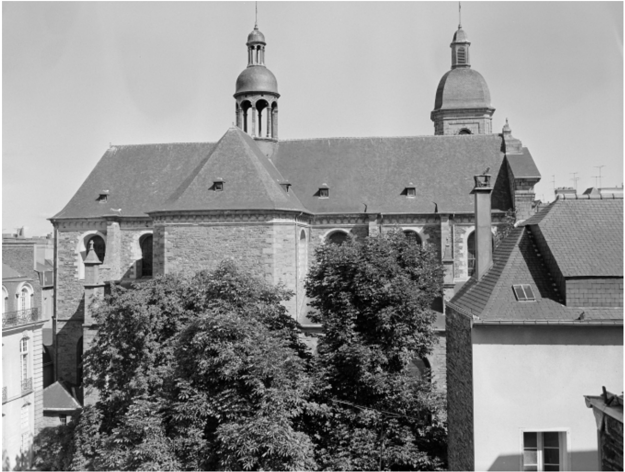
Elévation latérale : vue générale depuis l'hôtel de Blossac
