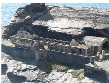
Caserne et usine électrique de l'îlot des Capucins Phot. Guillaume Marie IVR53_20082908460NUCA
