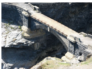
Pont de l'îlot des Capucins Phot. Guillaume Marie IVR53_20082908459NUCA
