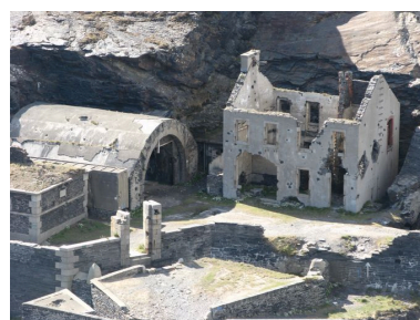
Usine électrique voûtée et maison du gardien de l'îlot des Capucins Phot. Guillaume Marie IVR53_20082908458NUCA
