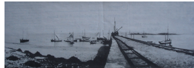
Vue de la jetée avec les rails pour les wagonnets, 1er quart 20ème siècle (collection particulière) Repro. Guy Prigent IVR53_20092210397NUCB
