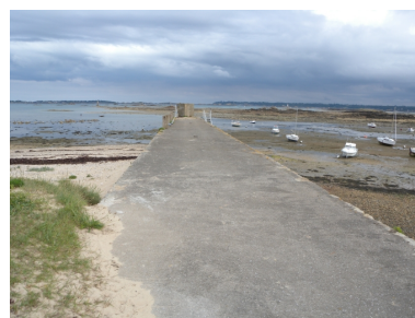
Vue du parement général de la jetée, en ciment Phot. Guy Prigent IVR53_20092210391NUCA
