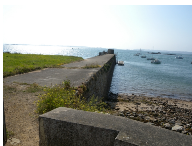
Vue du site où s'enracine la jetée Phot. Guy Prigent IVR53_20092210405NUCA
