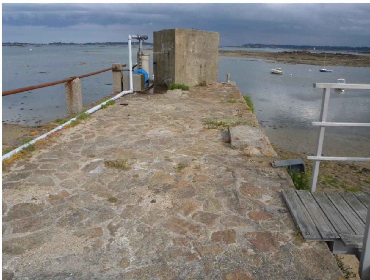
Vue de l'extrémité de la jetée, avec son parement en moellons de granite
