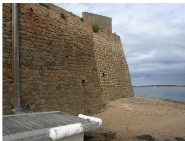
Vue du mur Nord du quai de la jetée, en partie rejointoyé Phot. Guy Prigent IVR53_20092210401NUCA
