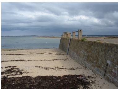
Vue de l'élévation Ouest de la jetée Phot. Guy Prigent IVR53_20092210400NUCA
