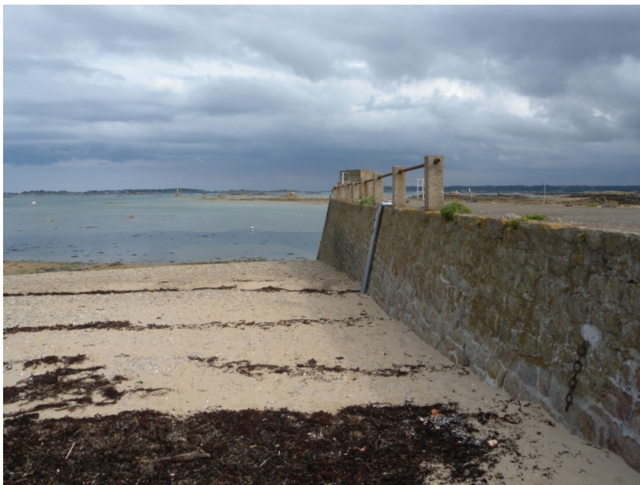
Vue de l'élévation Ouest de la jetée
