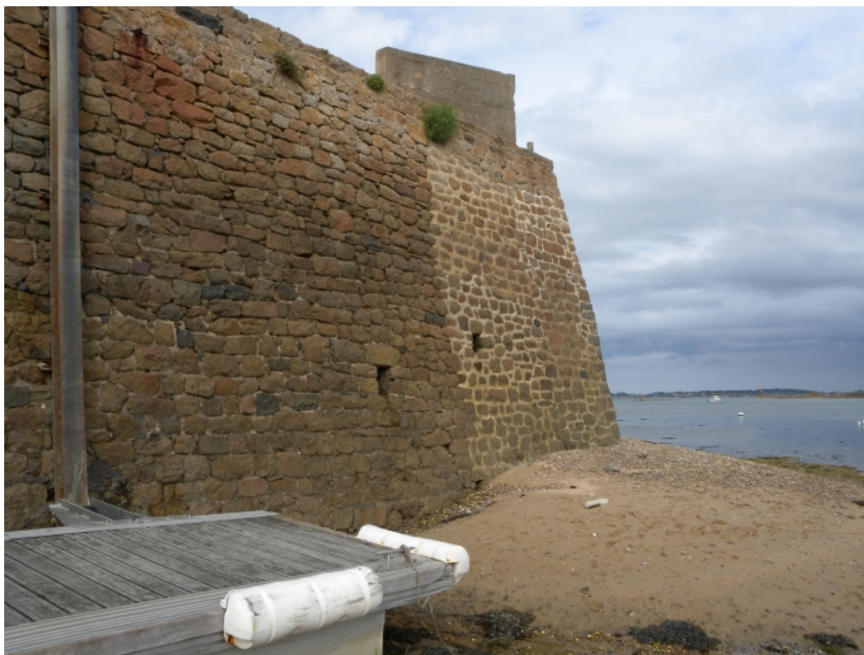
Vue du mur Nord du quai de la jetée, en partie rejointoyé
