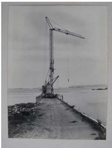
Vue générale de la jetée vers 1980 IVR53_20092210394NUCA
