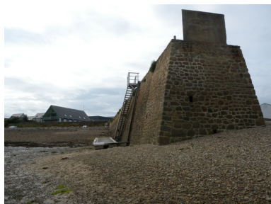
Vue du musoir du môle de la jetée Phot. Guy Prigent IVR53_20092210416NUCA
