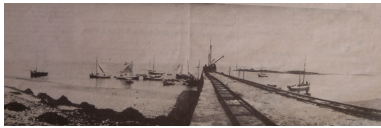
Vue de la jetée de Penn Lann, avec les bateaux goémoniers et les borneurs, 1er quart 20ème siècle (collection particulière) Repro. Guy Prigent IVR53_20092210210NUCB
