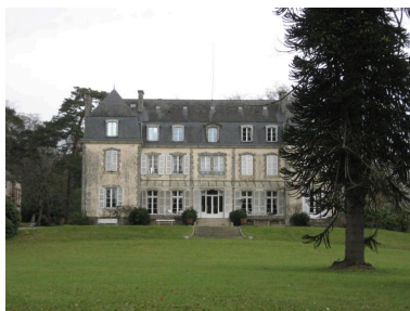
Vue Sud-Ouest (2010) Phot. Pierre Laurent Constantin IVR53_20225605020NUCA
