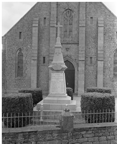
Monument aux morts, face ouest, vue générale Phot. Guy Artur, Phot. Norbert Lambart IVR53_19862900363X
