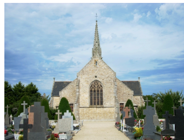
Vue générale de l'élévation est Phot. Gwénaél Fauchille IVR53_20082906576NUCA
