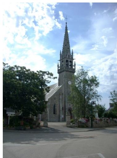
Vue générale ouest Phot. Gwénaél Fauchille IVR53_20082906575NUCA
