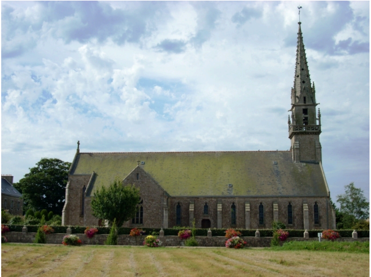
Vue générale, élévation nord
