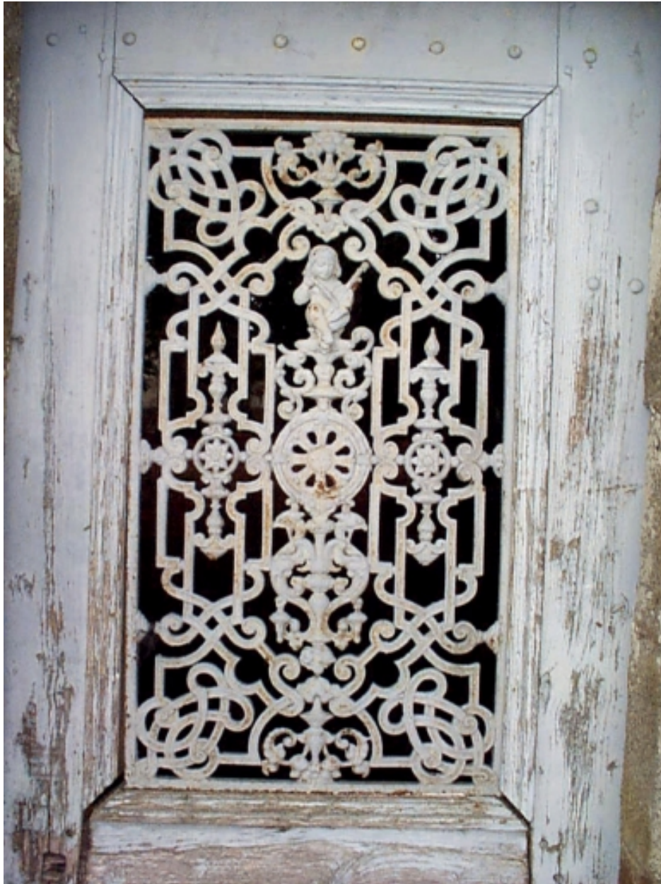
Détail de la grille de la porte latérale du portail sud
