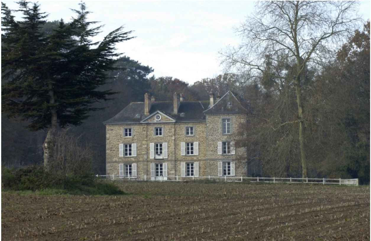
Vue de situation sud-est
