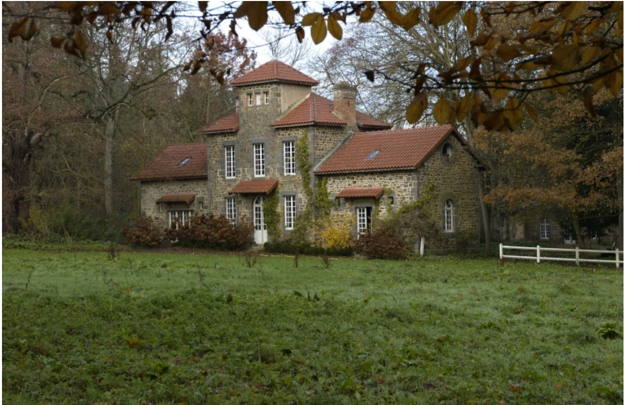
Atelier de peinture et communs : vue générale ouest
