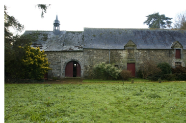
Chapelle et commons : élévation est Phot. Norbert Lambart IVR53_20053503462NUCA
