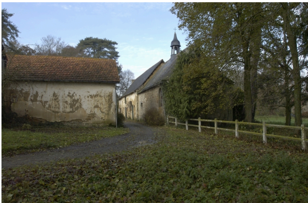
Chapelle et dépendances : vue générale sud-ouest
