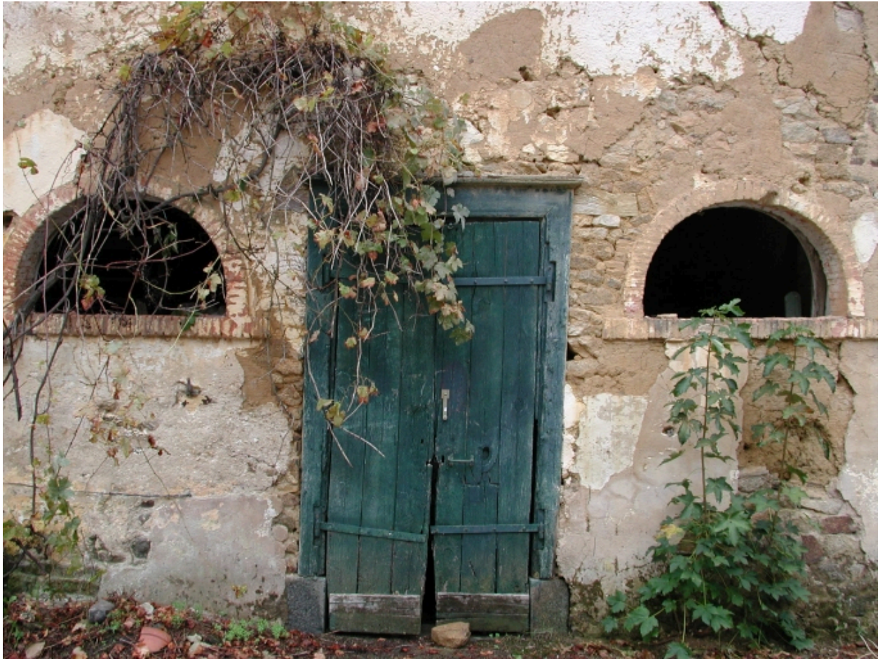
Détail de l'élévation sud des anciennes écuries
