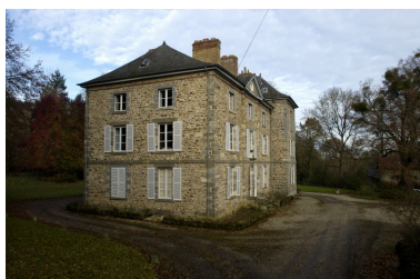
Vue générale sud-ouest Phot. Norbert Lambart IVR53_20053503455NUCA
