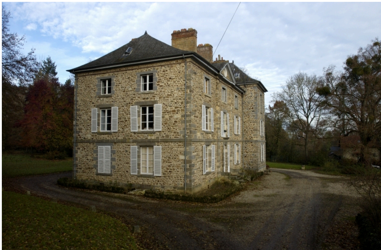
Vue générale sud-ouest
