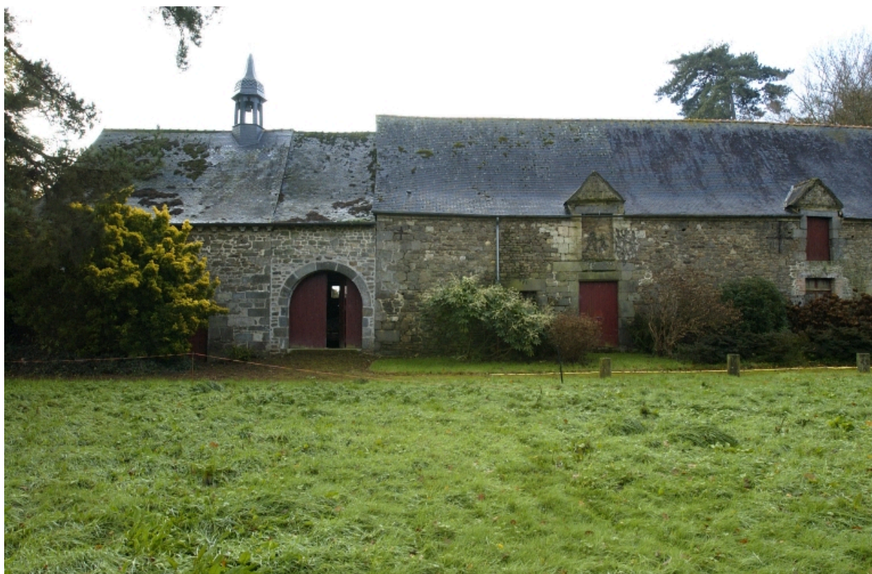
Chapelle et communs : élévation est
