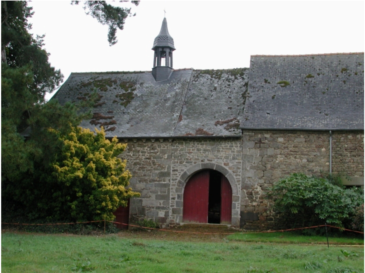
Chapelle à l'extrémité est de l'aile sud des communs
