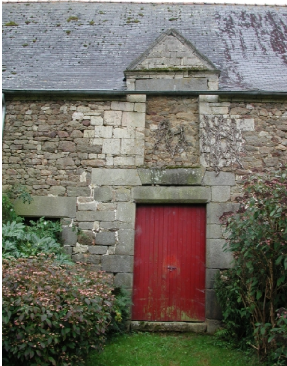
Aile sud des communs : détail de l'élévation nord
