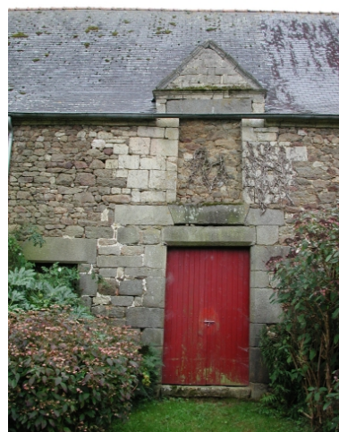
Aile sud des communs : détail de l'élévation nord Phot. Elise Lauranceau IVR53_20053519911NUCA
