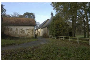
Chapelle et dépendances : vue générale sud-ouest Phot. Norbert Lambart IVR53_20053503467NUCA
