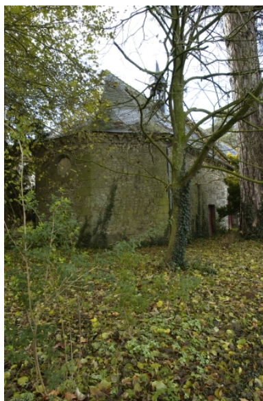
Chapelle, chevet : vue générale sud Phot. Norbert Lambart IVR53_20053503461NUCA
