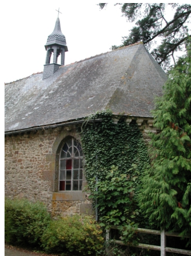
Chapelle : détail de chevet, vue du sud-est Phot. Elise Lauranceau IVR53_20053519913NUCA
