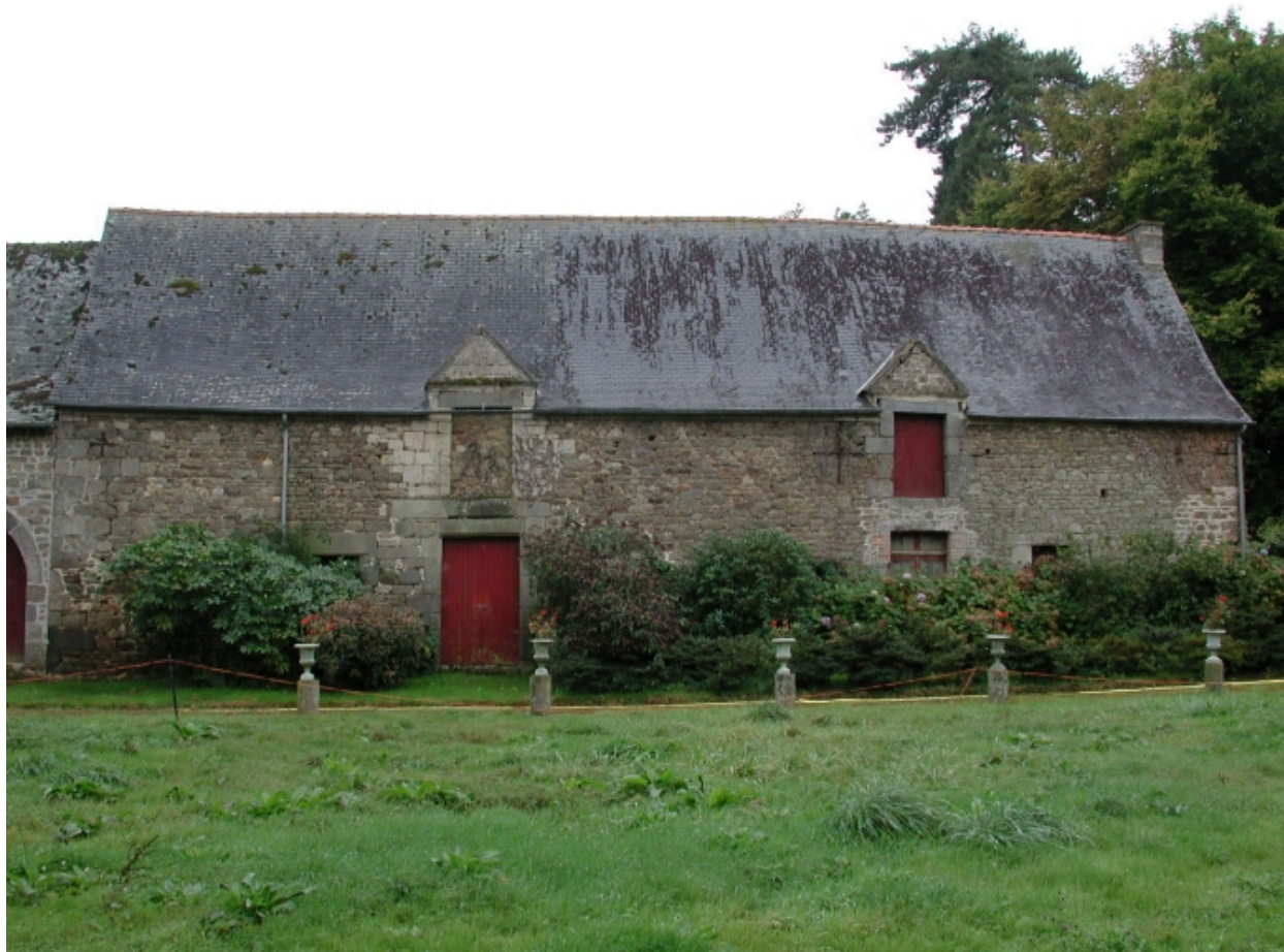
Aile sud des communs : vue générale
