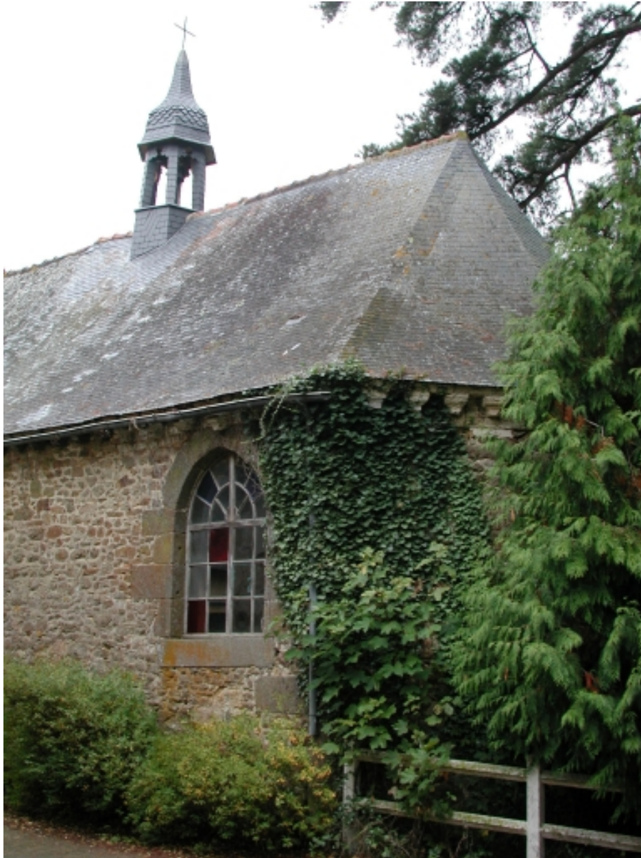
Chapelle : détail de chevet, vue du sud-est
