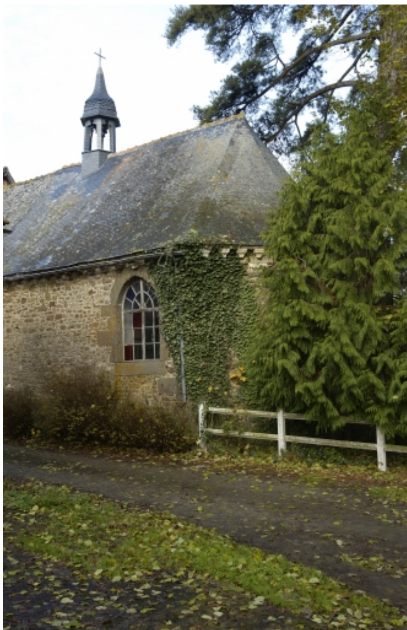
Chapelle, chevet : vue générale sud-ouest
