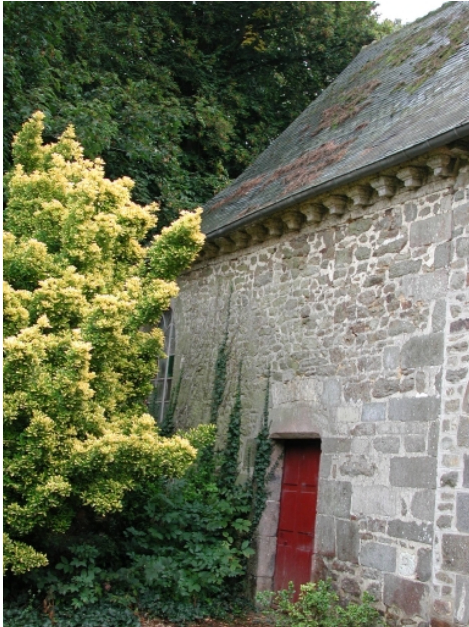
Chapelle : détail de l'élévation nord
