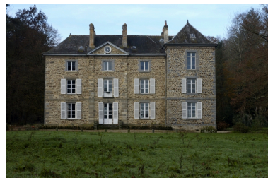
Vue générale sud Phot. Norbert Lambart IVR53_20053503458NUCA
