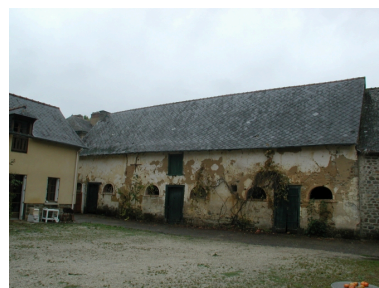
Ferme : vue générale de la cour vers le nord Phot. Elise Lauranceau IVR53_20053519916NUCA
