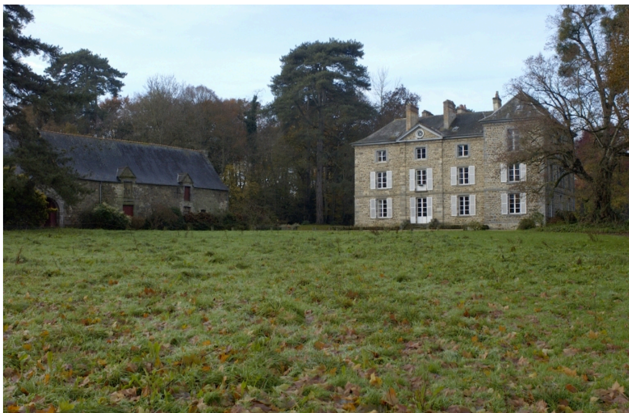
Vue de situation sud-est
