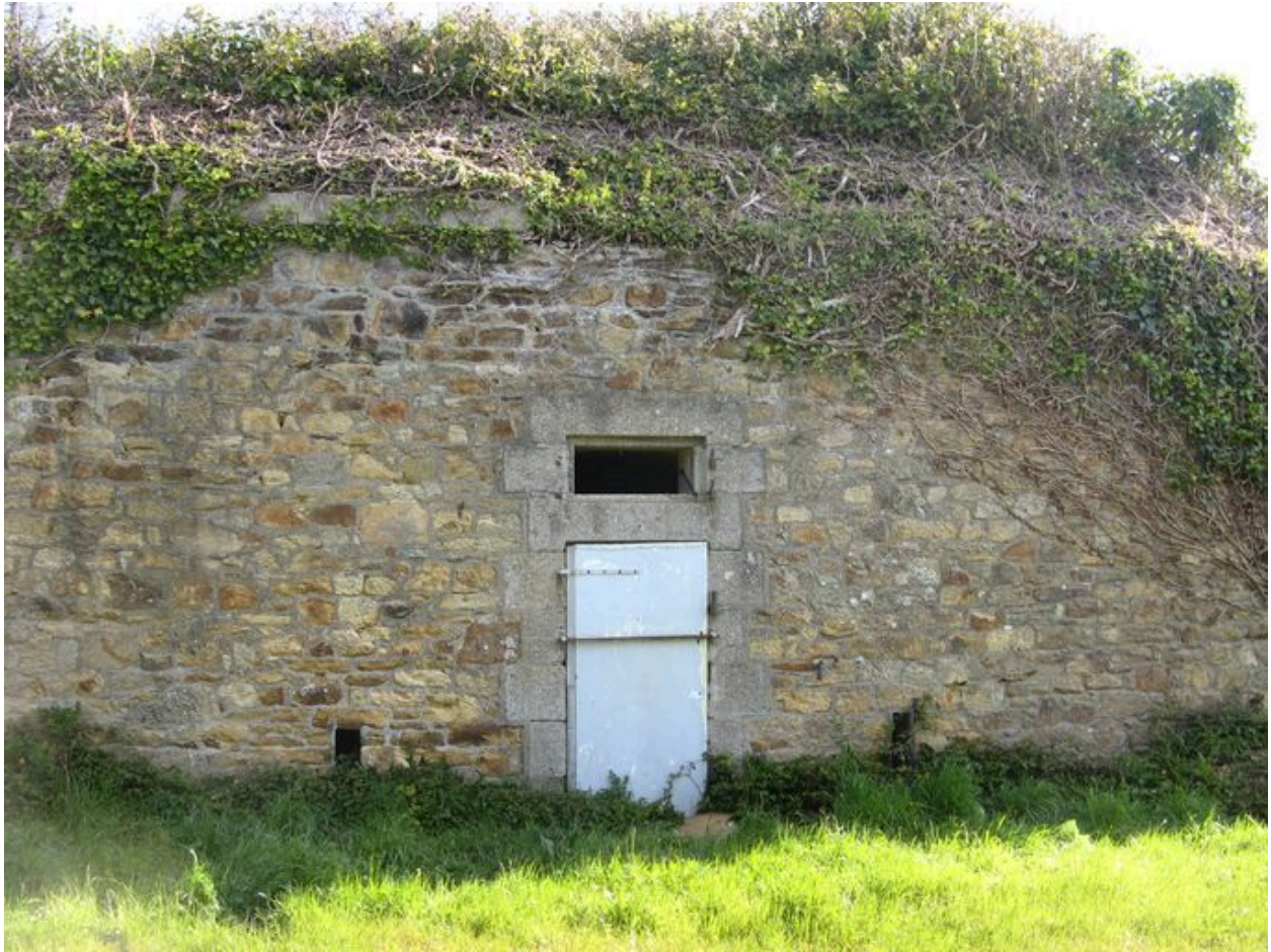
Elément de la batterie de Pont-Scorff
