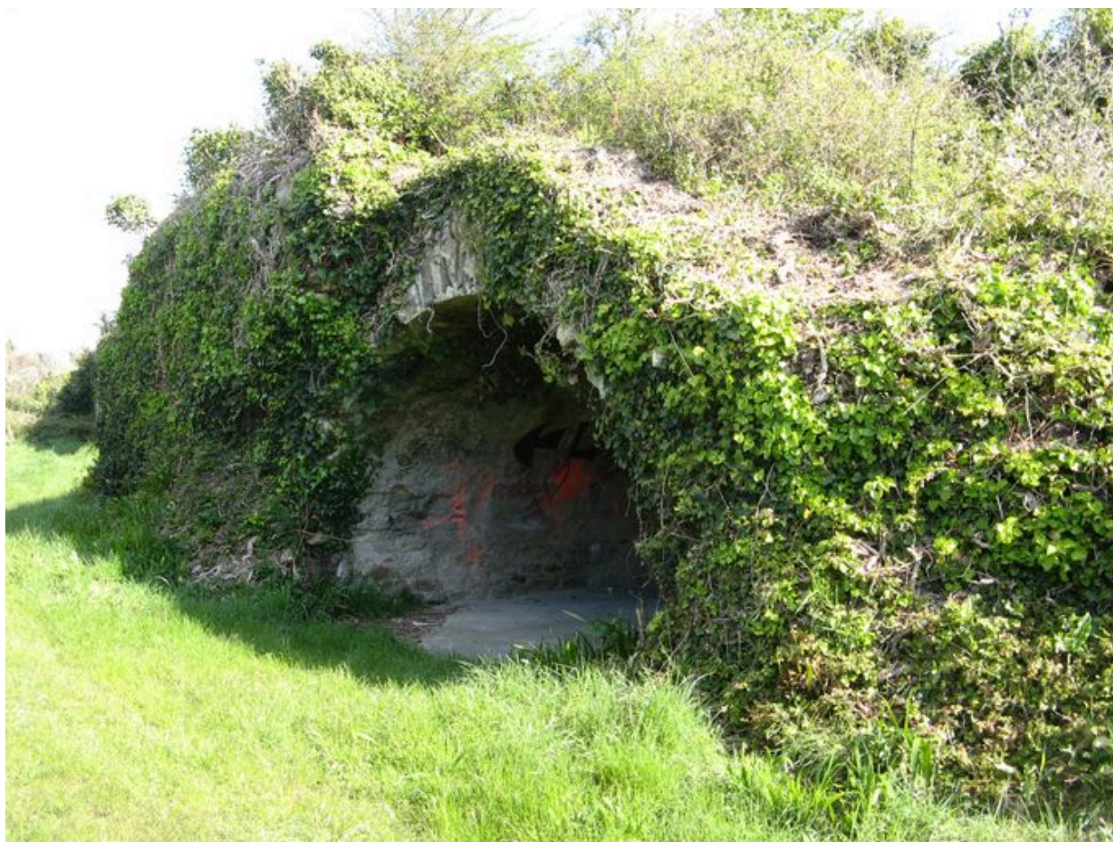
Elément de la batterie de Pont-Scorff
