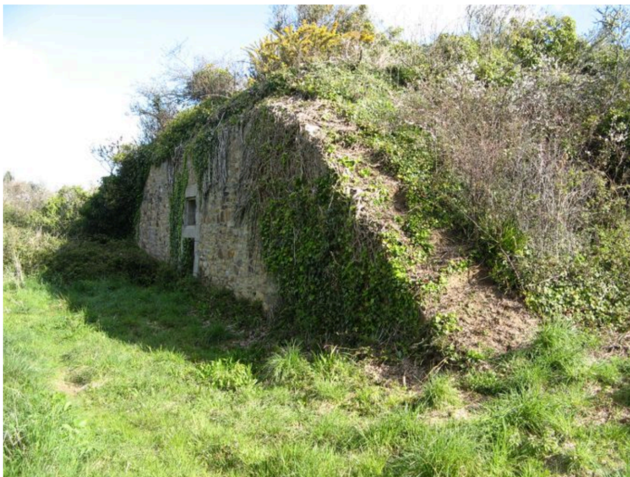
Elément de la batterie de Pont-Scorff
