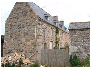
Corps de logis (façade antérieure) Phot. Patrick Pichouron IVR53_20072209715NUCA
