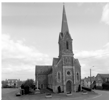
Elévation Sud-Ouest : vue générale Phot. Guy Artur, Phot. Norbert Lambart IVR53_19943500841X
